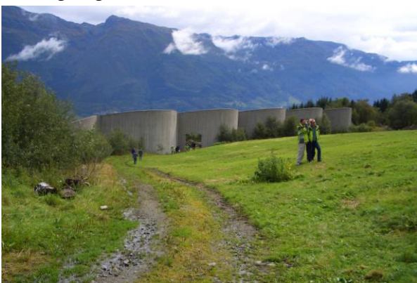
113,4 Meter lange Lawinenschutzmauer oberhalb der Ortschaft Bleie, die nach der Lawinenkatastrophe vom 27. Jänner 1994 errichtet wurde
