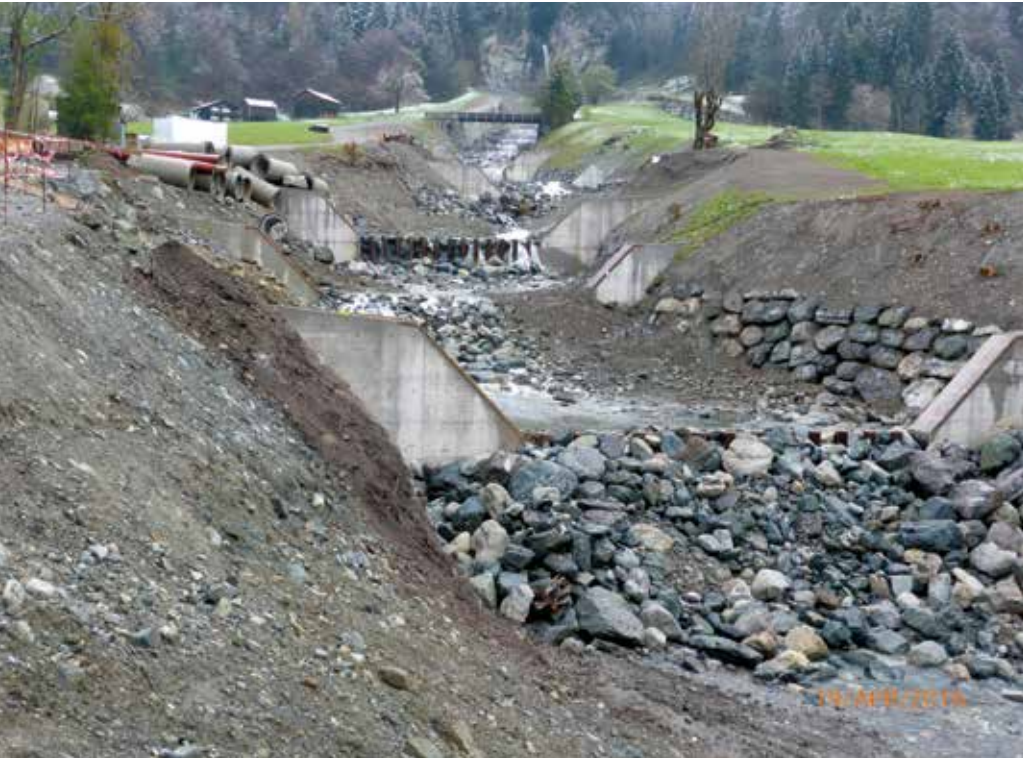
Abb. 8: "Kamm- sperren" während der Bauphase
