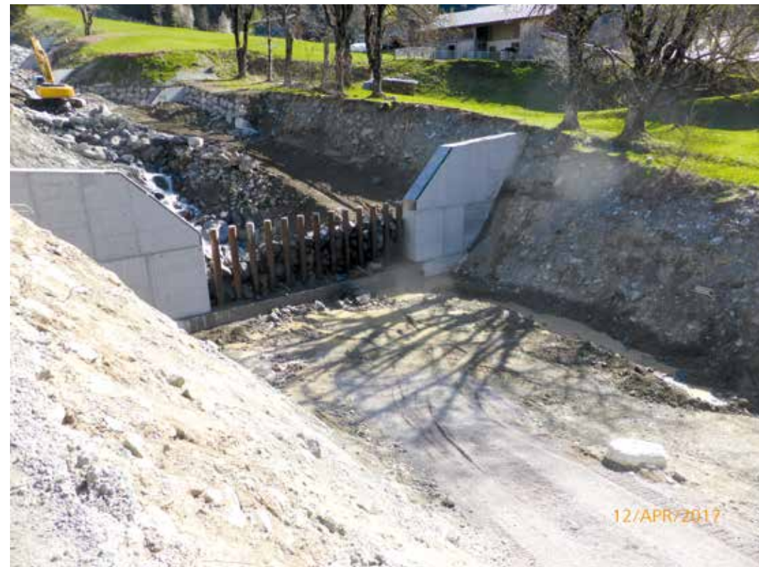
Abb. 6: „Kamm Sperre“ vor Hinterfüllung
