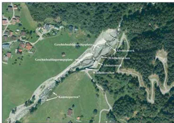
Abb. 2: Lage der Bauwerke am Schwemmkegel des Balbierbaches (Orthofoto August 2015)
