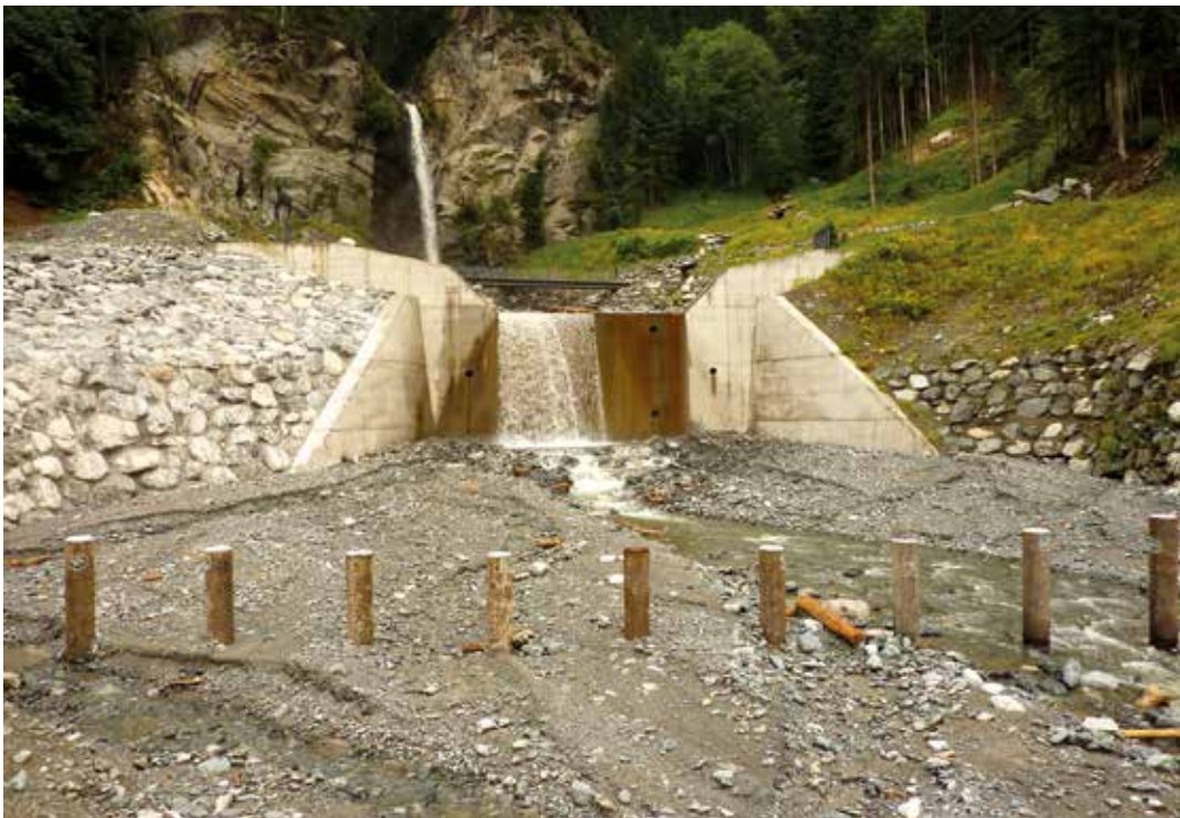
Abb. 5: Absturzwerk und Wildholzrechen
