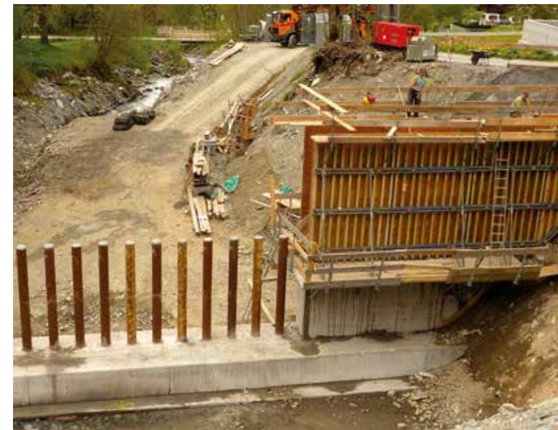
Abb. 4: Wildholzrechen während der Bauphase
