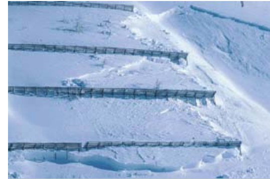
Abb. 1: Lawinenanbruch neben der Verbauung Nolle, Oberwald, Kt. Valais am 12. Februar 1999. Im Verbau wurde der Anbruch durch die Stützwerke erfolgreich verhindert.
