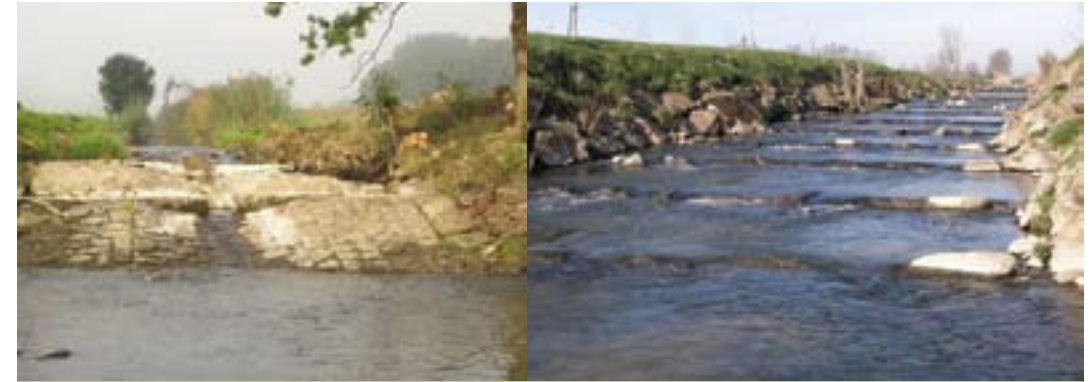
Abb. 10 und 11: Abschlussrampe Leitenbach in die Aschach-/Barbenregion; vor und nach Umbau.
