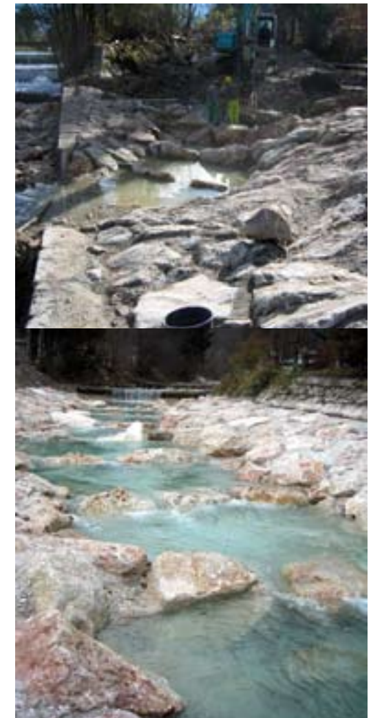
Abb. 10: Tümpelpass am Goiserer Weißenbach im Bauzustand und nach Fertigstellung.
