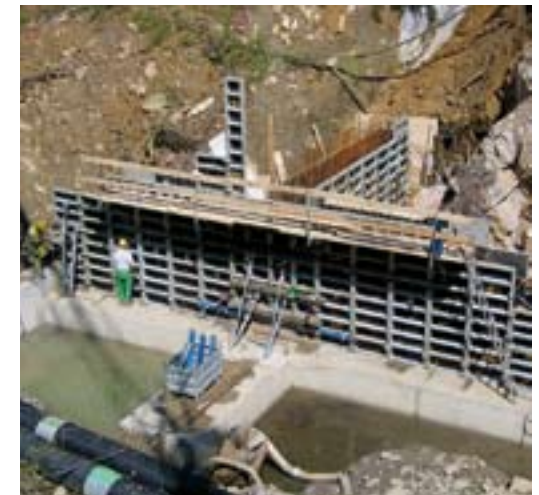
Abb. 7: Bau des Schrägrechens am Schwarzenbach bei hm 15,0.
