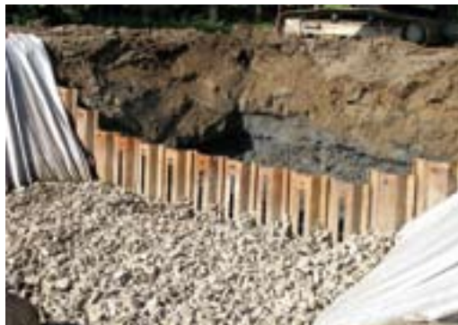
Abb. 14 Innbach: Fixierung der Rampenkronen durch geschlitzte Spunddielen.
