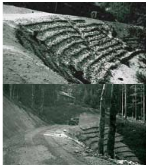
Abb. 5 und 6: Dammschüttungen bepflanzt mit Weidencordon im Weißeneckbach 1953, Gde. Grünau i. A. Gbl. Salzkammergut.
