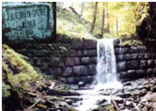
Abb. 8: Falkenhaynsperre – Trockenmauerwerk, erbaut 1885.
