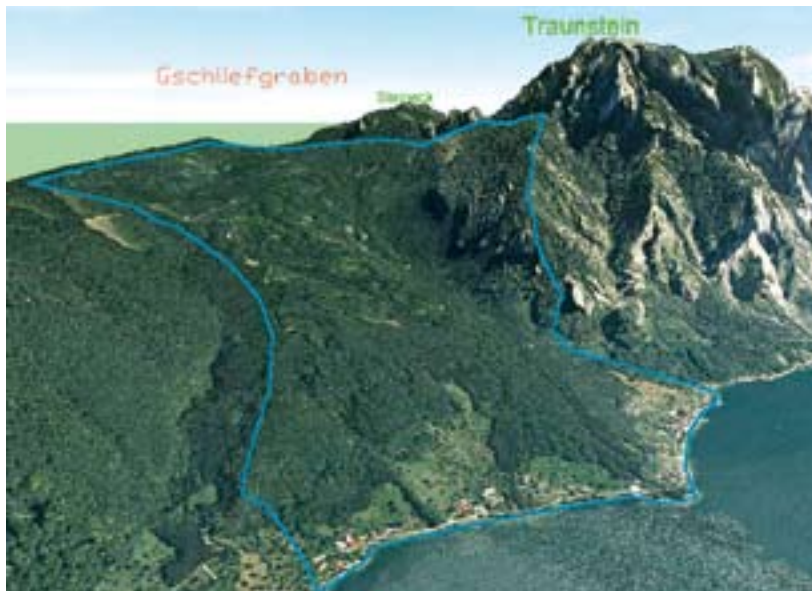
Abb. 9: Blick in den Gschliefgraben (blaue Umrandung), Stadtgemeinde Gmunden. Entlang des Schwemmkegels liegen zahlreiche Wohnobjekte im potenziellen Gefährdungsbereich (Rote Wildbachgefahrenzone).
