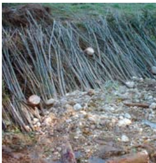
Abb. 6: Detailansicht der Weidenspreitlage unmittelbar vor der Überdeckung mit Erde.
