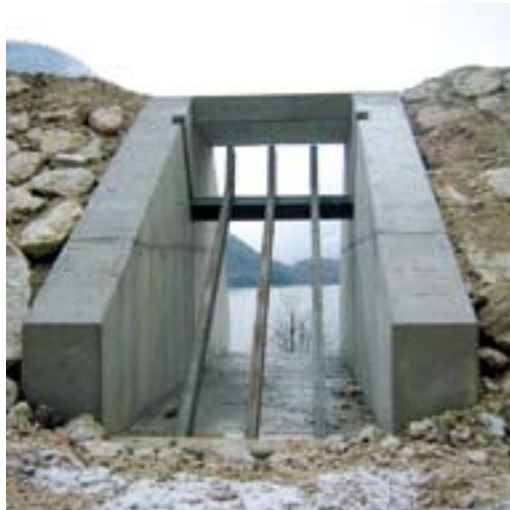
Abb. 4: Lawinenauffangdamm Steingraben: Blick auf den Schrägrechen der Hochwasserentlastungsanlage.
