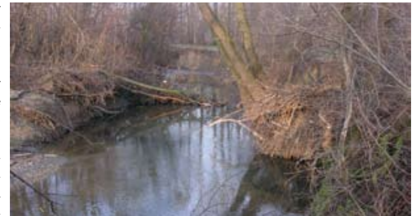
Abb. 1: Abflussbehindernder Uferbewuchs führt zu Verklauungen durch Wildholz; unterspülte Bäume lenken den Stromstrich ab und bewirken Seitenerosionen.
