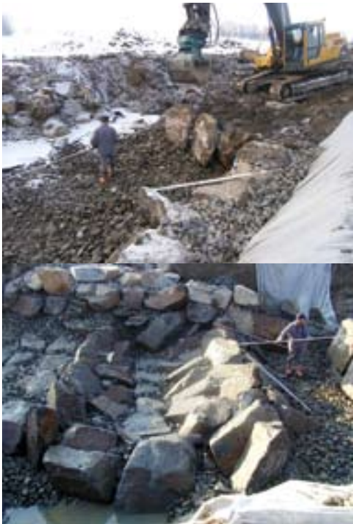
Abb. 12 und 13: Leitenbach; Bauausführung Rampe 1 (links) und Rampe 2 (rechts).
