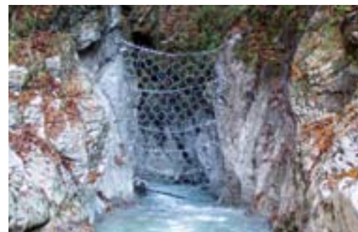
Abb. 4: Netzsperr in hm 14,0 unmittelbar nach Fertigstellung.
