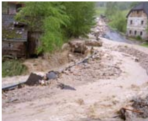
Abb. 7: Pechgraben, Gemeinde Laussa (Ereignis vom Mai 2005)
