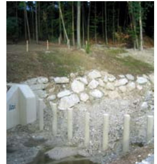
Abb. 2: Wildholzrechen mit Ablagerungsbereich in hm 7,60 des Kuchlbaches, Gde. Altmünster, unmittelbar nach Fertigstellung im Juni 2007.
