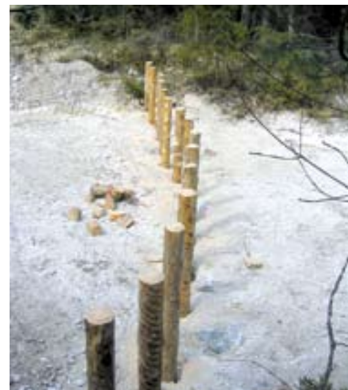
Abb. 6: In Fließrichtung wurde der Unholzrechen gekrümmt ausgeführt, um ankommendes Unholz effektiv zur Ablagerung zu bringen (Konzentrationswirkung).
