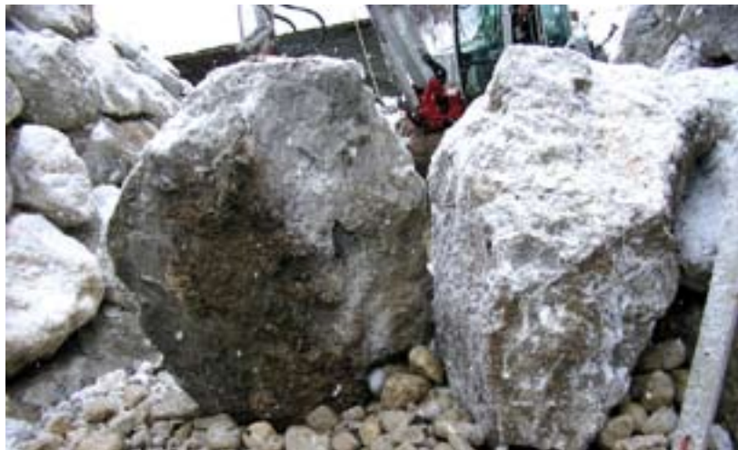
A.3) Zweigliedrige Steinsohlrampe in Betonbettung
