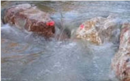
Abb. 18: Laussabachrampe: V-förmiger Korridor, Forellenregion.
