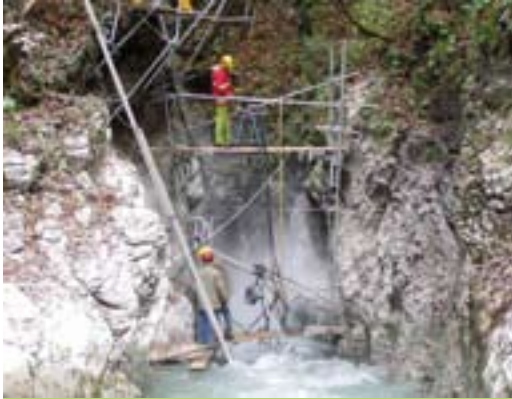
Abb. 5: Durchführung der Bohr- und Verankerungsarbeiten
