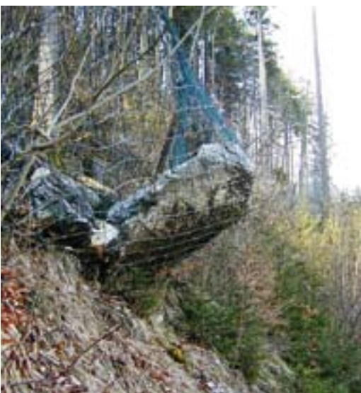
Abb. 3: Vor Sturz auf die Hallstättersee-Landesstraße von einer 350 kJ-Verbauung „aufgefangene“ Felsplatte mit einer Kubatur von rd. 1,0m³. Die Felsplatte löste sich unmittelbar oberhalb der Verbaulinie und wäre ohne Verbauung direkt auf die stark frequentierte Landesstraße gefallen.
