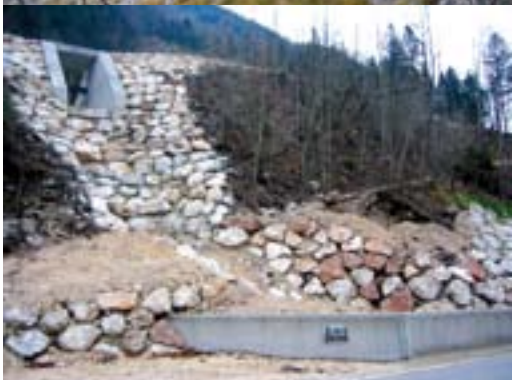
Abb. 2: Mittels permanenten Sicherungsmaßnahmen, wie der Errichtung von Anbruchsverbauungen und Lawinendambbauten z. B. im Bereich der sogenannten Steingrabenlawine, wird versucht, die vorherrschende Lawinengefährdung für die Region zu minimieren.
