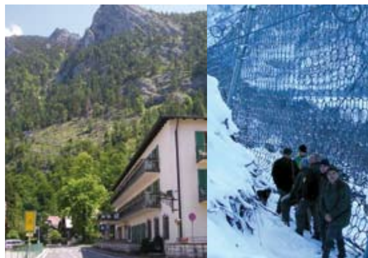
Abb. 8: Links: Das 3.000-kJ-Steinschlagschutznetz überspannt die unterhalb des Schobersteins gelegene Hangmulde und reicht von links randlich in die durch den Herbststurm 2002 entstandene Kahlfäche. Rechts: Besichtigung der Baustelle mit Kollegen der Bezirksforstinspektion Vöcklabruck.
