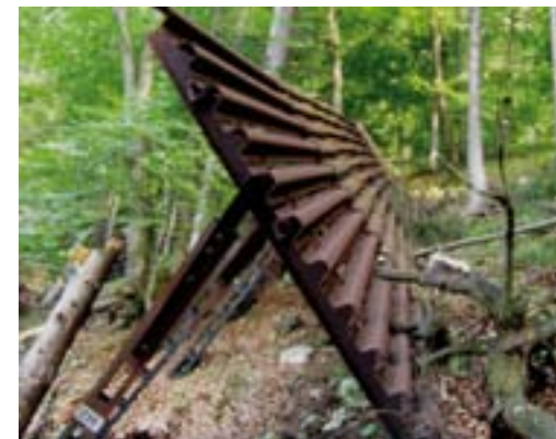
Abb. 1: VÖEST-Alpine-Stützwerk mit Steinschlagpanzerung im Bereich des Kleinen Wehrgrabens, Gemeinde Bad Goisern.
