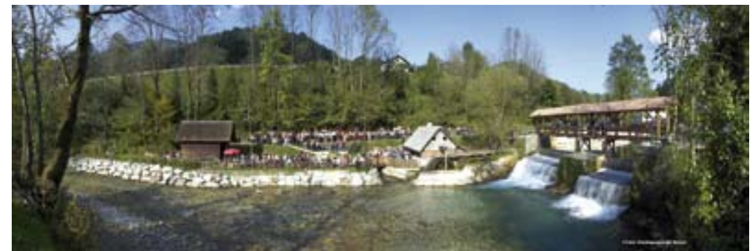
Abb. 1: Ohne das historische Ambiente zu stören wurde das Vorfeld des Katzensteinerwehrs kaum sichtbar mit Wasserbausteinen in Betonbettung und mit einer ca. 4 m breiten Sohlgurte gesichert. Rechtsufrig konnte ein Tümpelpass auf Filterschicht integriert werden.
