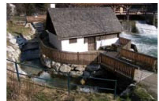
Abb. 6: Gaflenzbach, FWH Katzensteinerwehr, Tümpelpass.
