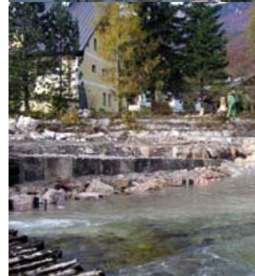
Abb. 9: Nach Sicherung des Grundschnellenvorfeldes gegen Unterkolkung mittels Lärchenpilotierung und in Beton verlegten Kalkwasserbausteinen konnte die Steingrundschnelle abgesenkt und so eine organismenpassierbare Anbindung des Goiserer Weißenbaches an den Vorfluter hergestellt werden.
