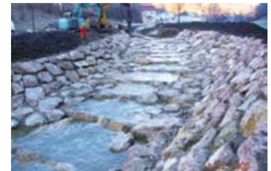
Abb. 7: Grüntalrampe im Laussabach: Mit mittig integriertem Tümpelpass soll die Verlandung der Tümpel am Rampenfuß vermindert werden.
