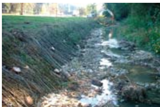
Abb. 3: Fixierung mit Holzpiloten und Draht.
