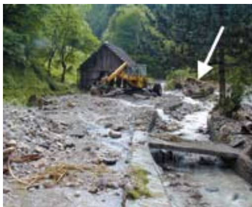
Abb. 2: Zerstörte Straße und überflutetes Wohnobjekt nach Verklausung einer Brücke durch Wildholz.
