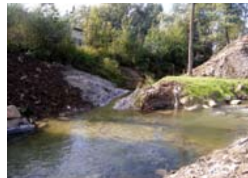
Abb. 17: Innbach: Sicherung am Rampenfuß, Nachbettung mit Tiefzone unterhalb der Steinschichtung.
