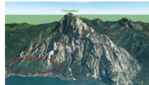
Abb. 10: Traunsteinwestabfall mit darunterliegendem Siedlungsgebiet „Unterm Stein“. Der Gefahrenzonenplan für das Stadtgemeindegebiet von Gmunden weist seit der 1. Revision 2000 hier einen blauen Vorbehaltsbereich aus. Zur Untermuerung dieser Festlegungen ist eine entsprechende Quantifizierung des vorhandenen Gefährdungspotenziales erforderlich (Akzeptanz- bzw. Argumentationsprobleme).
