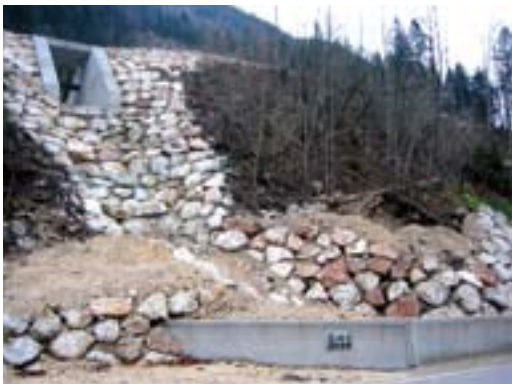
Abb. 3: Die neu errichtete Hochwasserentlastung soll die Standsicherheit des Lawinenauffangdammes der Steingrabenlawine sicherstellen. Bauwerk unmittelbar nach Fertigstellung.
