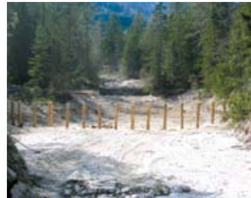
Abb. 5: Die Lärchenpiloten wurden mit Pilotenschuhen versehen und mittels Bagger und hydraulischem Schlagwerk rd. 3,0 m in den grobschottrigen Untergrund gerammt. Die verbleibende Pfahlhöhe beträgt rd. 2,50 – 3,00 m.
