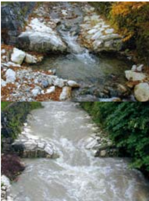
Abb. 11, 12: Die sanierte Grundschwelle der Ortsregulierung Steinbach bei hm 0,4 bei Niederwasser und bei erhöhter Wasserführung.
