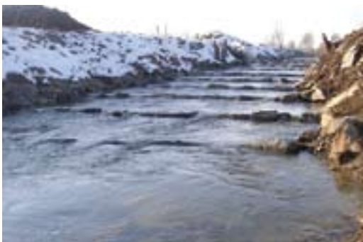
Abb. 20: Leitenbach, Gde. Waizenkirchen, Modellrampe: Wanderkorridor Barbenregion.
