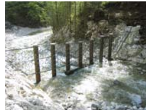
Abb. 1: Wildholzrechen mit Feinholzfilter zur Freihaltung der Schlitzsperrenöffnung ca. 50 m oberhalb der vorhandenen Schlitzsperre im Dietlbach, Gde. St. Wolfgang im Salzkammergut bzw. Gde. St. Gilgen (hm 13,42).
