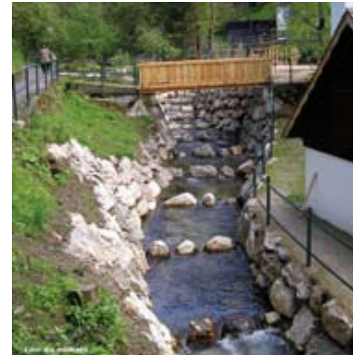
Abb. 3: Der Fischeaufstieg wird mittels einer Schieberkonstruktion aus dem Staubereich des Katzensteinerwehrs mit ca. 150 l/s dotiert. Entgegen der allgemeinen Regeln mündet er senkrecht in den Hauptbach und wird dennoch problemlos von den Fischen angenommen.
