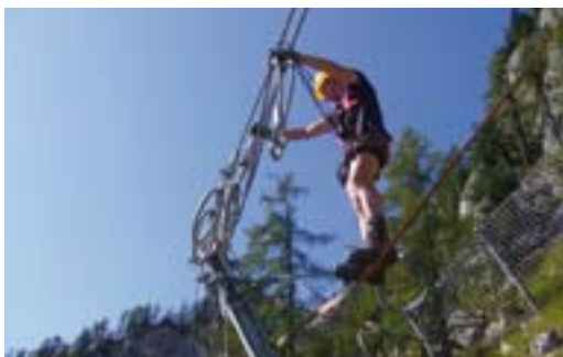
Abb. 7: Montage der Steinschlagschutzverbauung RXI-200 im Anbruchgebiet der Steingrabenlawine.
