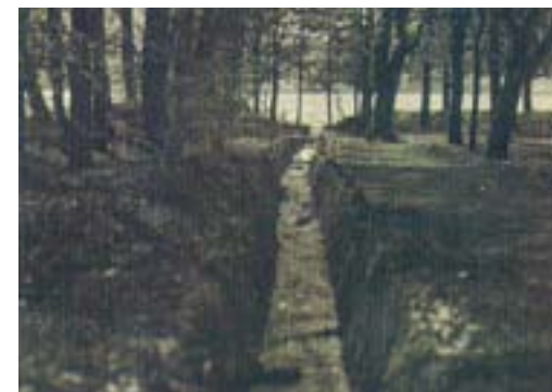
Abb. 2: Der Kandlbach-Unterlauf vor (links) und nach Errichtung des Regulierungsgerinnes 1926
