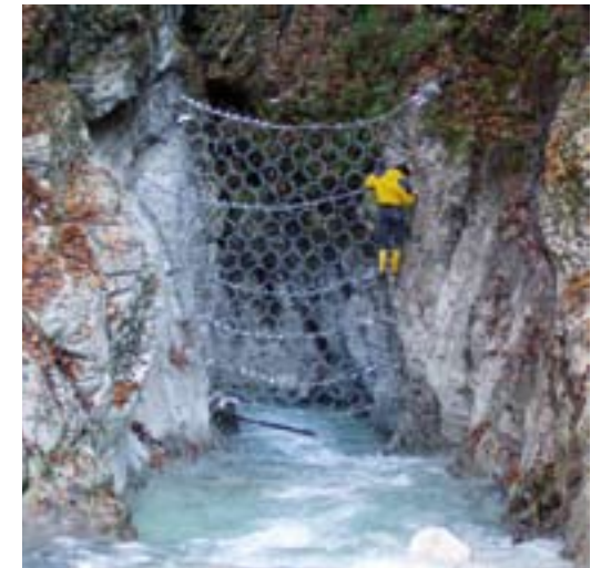
Abb. 2: Fertiggestellte Netzsperrre in hm 14,0 mit ca. 1,3 m Bodenspalt.
