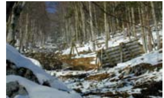
Abb. 7: Die Keferriesenlawinenverbauung am Brentenkogel wurde 1999 zerstört, Schäden im Ortsgebiet von Ebensee konnten aber verhindert werden.
