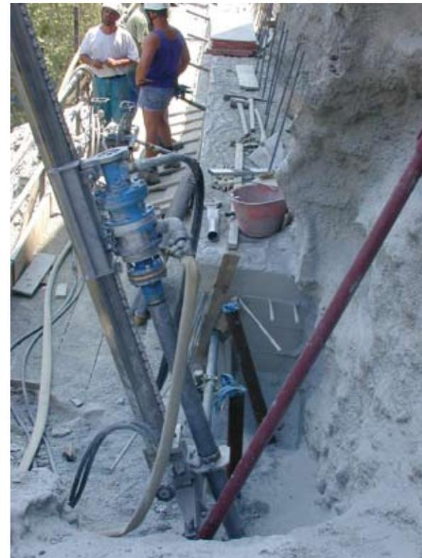
Abb. 7: Arbeiten mit der Leichtbohrlafette
