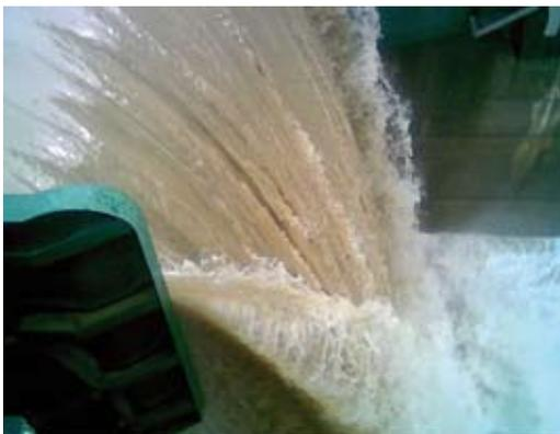
Abb. 19: Mit programmierten Wasserableitungen in Verbindung mit den meteorologischen Prognosen können große Speicherbecken Volumen zum Hochwasserrückhalt (Kappung der Hochwasserwelle) bereitstellen
