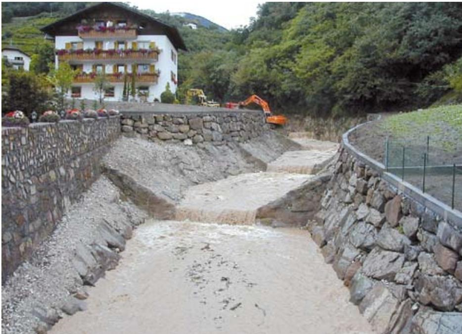
Abb. 23: Verbauungsmaßnahmen im Unterlauf des Prissianerbaches
