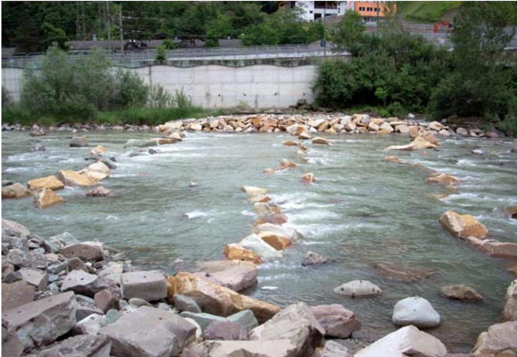
Abb. 2: Aufgelöste Rampe anstelle der Sperre am Eisack bei Blumau (Foto Vito Adami)
