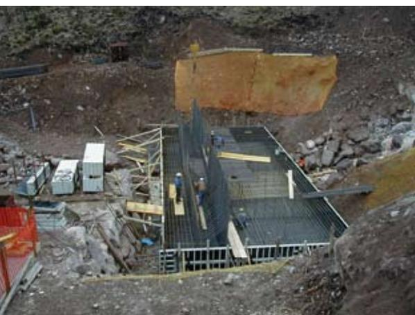
Abb. 16: Bau der ersten Geschieberückhaltesperre
