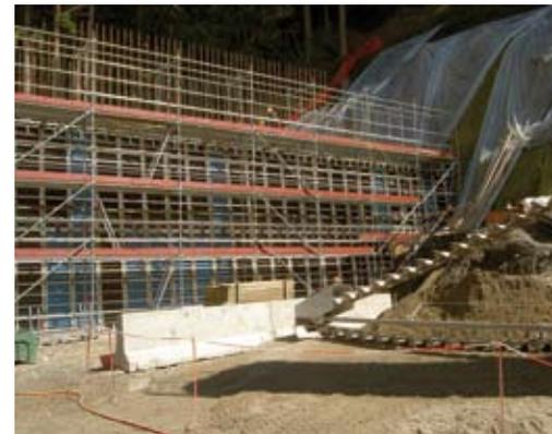
Abb. 8 und 9: Errichtung von Betonsperren, 1970 und 2008
