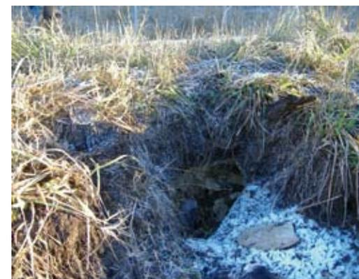
Abb. 16: Beispiel einer öfters auftretenden Anomalie: Das Vorhandensein von Tierhöhlen im Dammkörper kann Sickerwege verursachen, welche schlimmstenfalls zum hydraulischen Bruch führen können.
