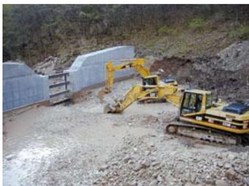
Abb. 19: Kurz nach dem Bau des ersten Rückhaltebeckens wird dieses nach einem Murgang mit Geschiebe aufgefüllt
