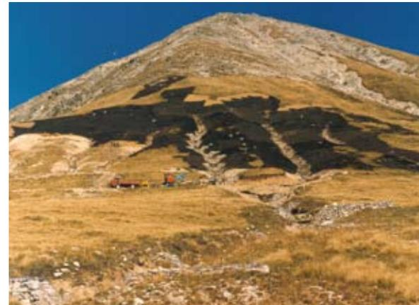
Abb. 2: Aufbringen der Bitumenemulsion auf die Mulchschicht (Meran 2000 im Jahr 1986)
