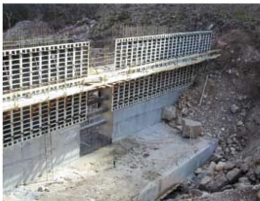
Abb. 17: Bau der ersten Geschieberückhaltesperre
