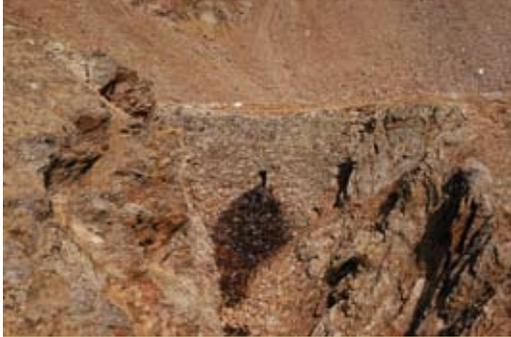
Abb. 3: Talseitige Trockenaufmauerung mit Wasseraustritten
