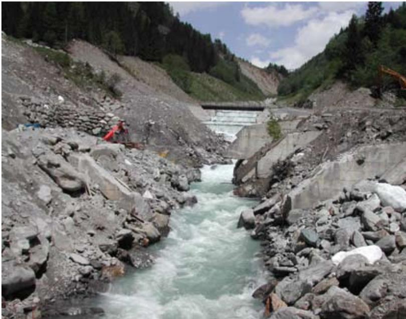
Abb. 6: Oben: neuer Sperrtyp mit verschiebbaren Elementen.
