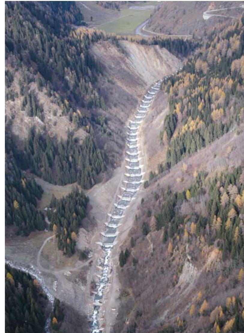
Abb. 3: Die Passer bei Hahnebaum. Oben: neue Verbauung; unten: Verbauung aus den 70er-Jahren. Aus dem Luftbild ist deutlich erkennbar, dass mit den neuen Verbauungen das Gerinne drastisch verbreitert wurde.
