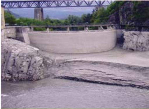
Abb. 5: Entleerung des Speichers in Franzensfeste (Juni 2000): an der Mauer abgelagertes Material (ca. 20 m Höhe)
