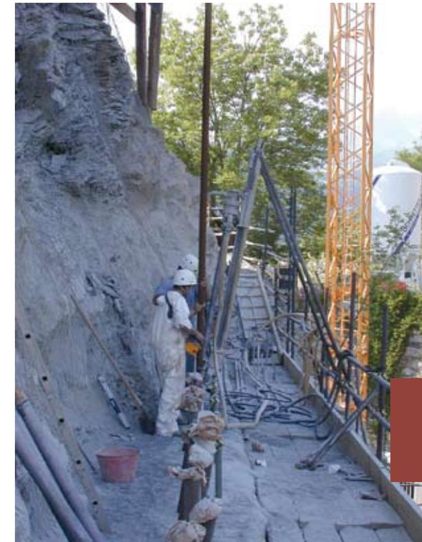
Abb. 8: Das Einbringen der Pfähle mit dem Kran
