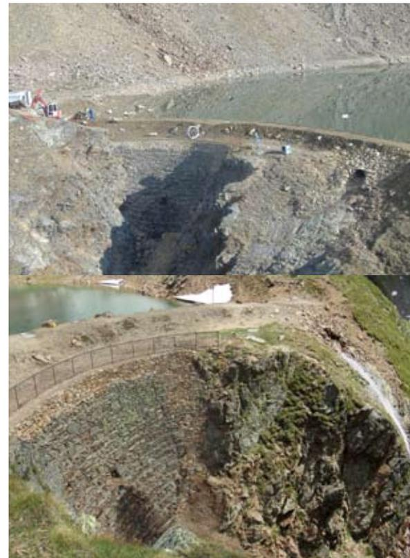
Abb. 10a und b: Dammbereich vor Abschluss der Arbeiten mit sichtbarem Abfluss des Überlaufes des Drainagenwassers
