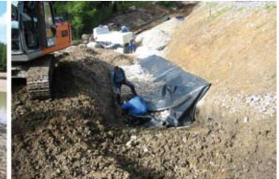
Abb. 10: Links: abgedeckte Innenböschung, rechts: Einbau des Filters am luftseitigen Dammfuß
