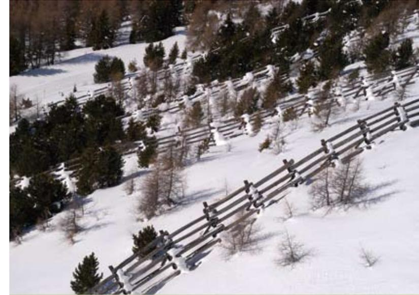
Abb. 6: Anfänge der Schneebrücken: Stahl-Holzkonstruktion
