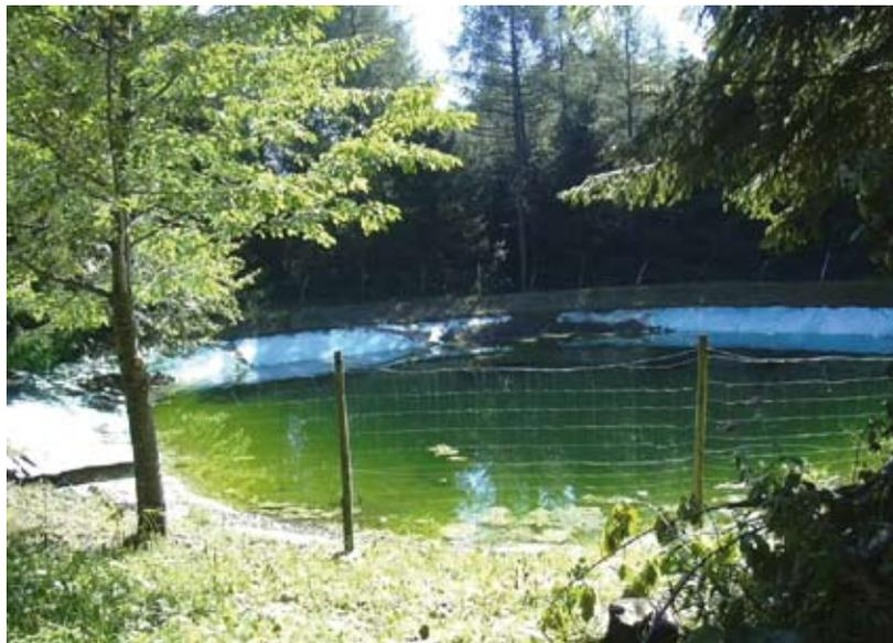
Abb. 14: Beispiel großer Vernachlässigung eines Brandschutzbeckens. Die Dichthaut ist in mehreren Punkten gerissen, es fehlt ein geeigneter Überlauf und auf dem Damm wachsen Bäume.
