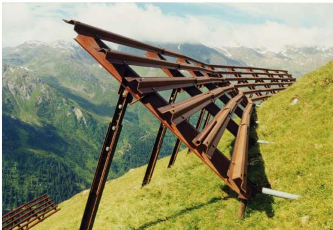
Abb. 9: aufgelöster Anker
