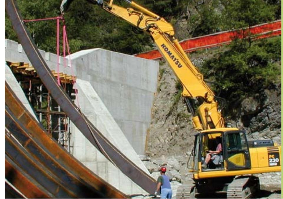
Abb. 10: Einheben der Kastenprofile
