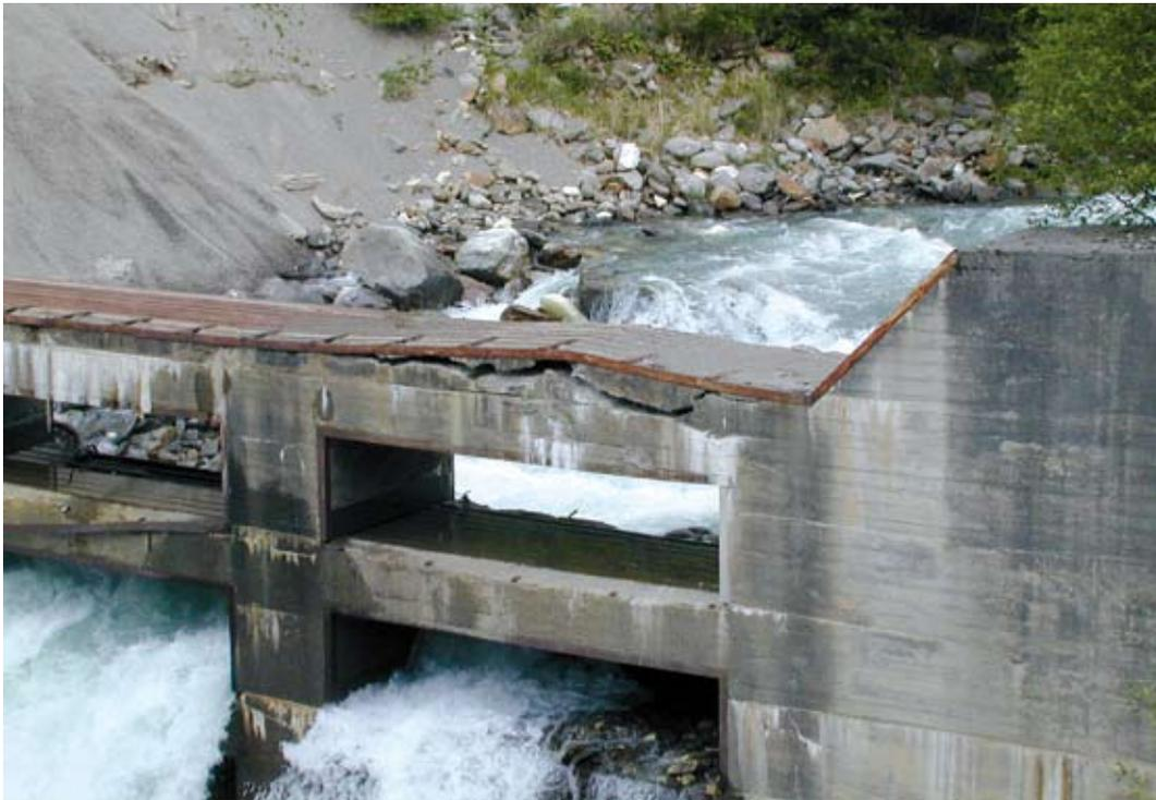
Abb. 2: Durch den Talzus Schub aufgewölbte Krone der Geschieberückhaltesperre bei Kohlstatt
