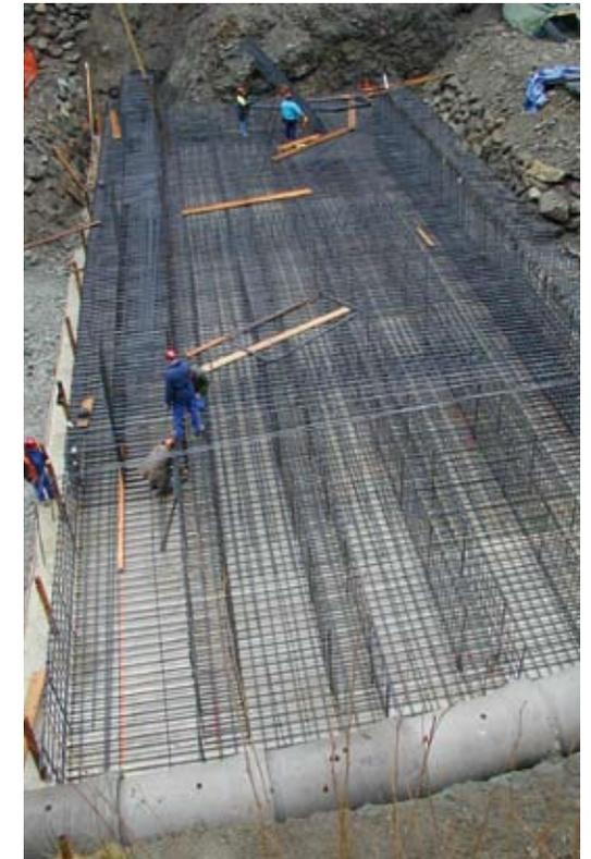
Abb. 7: Binden des Fundamentkorbes
