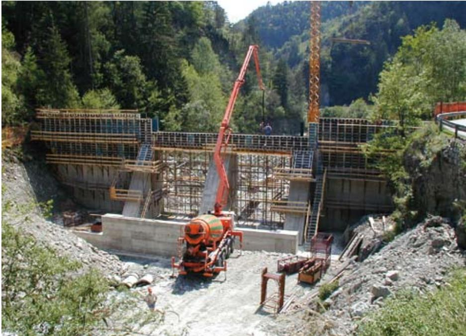
Abb. 9: Der obere Balken wird gegossen
