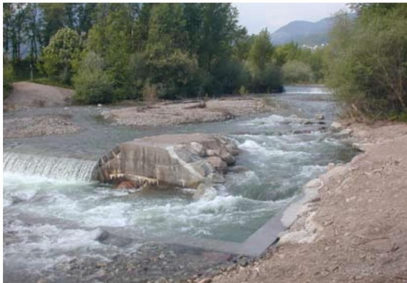
Abb. 6: Fertiggestellte L-Rampe im Mai 2007 an der 5. Sperre der Falschauer
