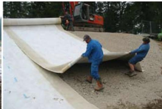
Abb. 10: Links: abgedeckte Innenböschung, rechts: Einbau des Filters am luftseitigen Dammfuß
