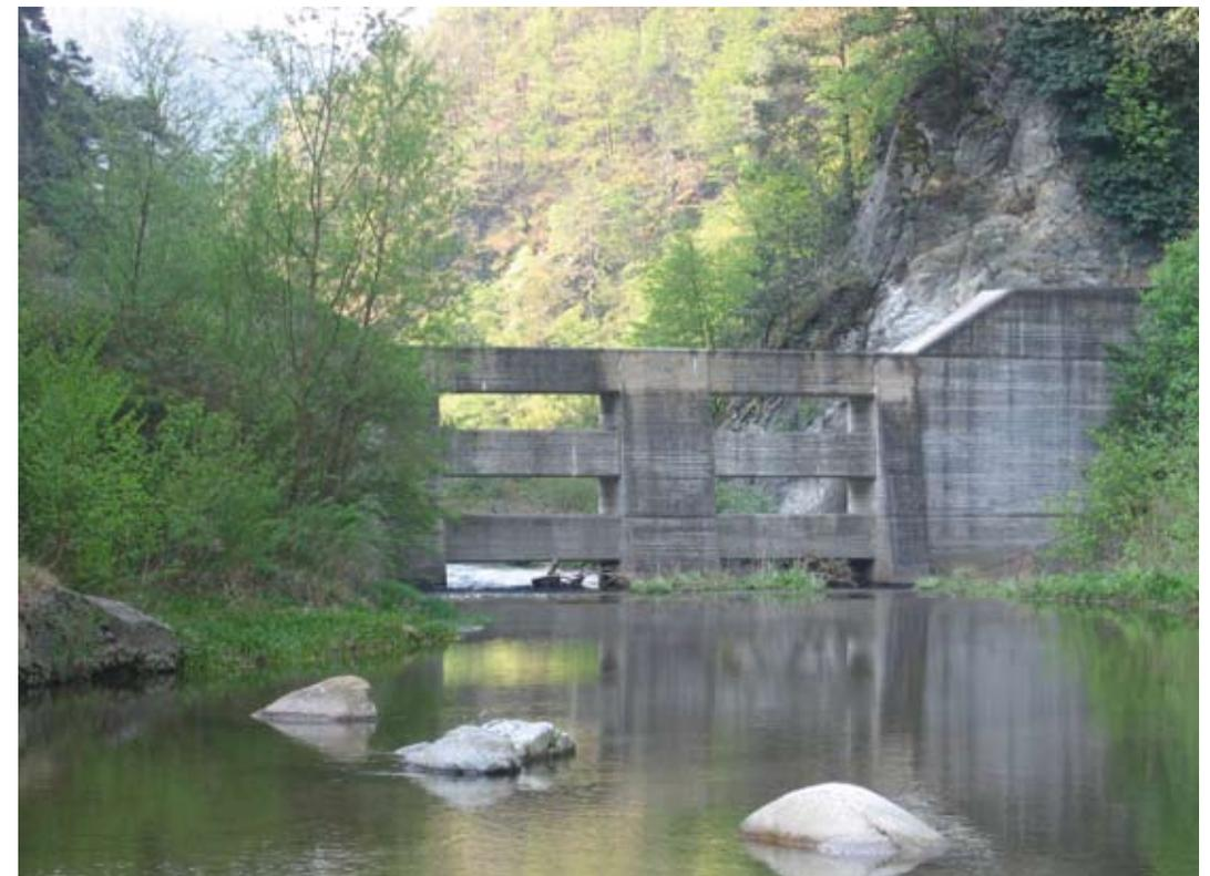
Abb. 2: Geschieberückhaltesperre am Tinnebach
