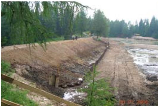
Abb. 9: Links: Spundwandkopf, rechts: Verlegung der Bentonitmatte
