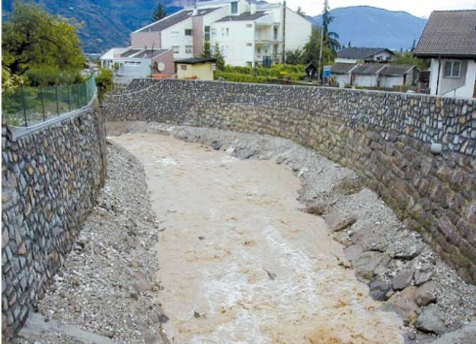
Abb. 22: Verbauungsmaßnahmen im Unterlauf des Prissianerbaches
