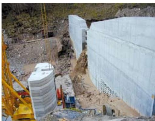
Abb. 18: Bau der ersten Geschieberückhaltesperre
