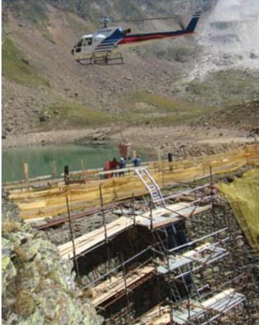
Abb. 8: Gänzlicher Materialtransport mittels Hubschrauber
