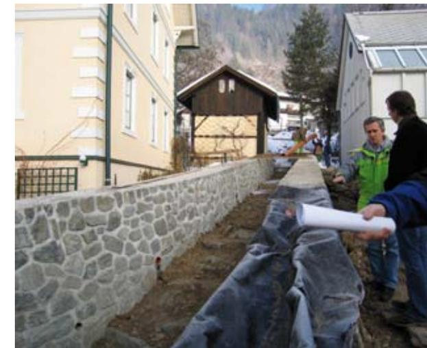
Abb. 4: Ortsregulierung – Ufermauern in Zyklopenmauerwerk
