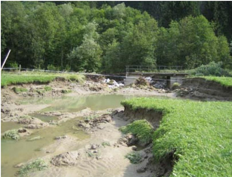
Abb. 1: Erosionsschaden bei einem Hochwasserschutzdamm mit geringer Stauhöhe
