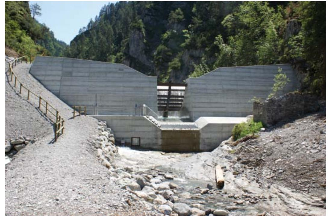
Abb. 4: Neu errichtete Geschiebedosiersperre 2008/2009 mit Tiroler Wehr und Restwasserabgabe
