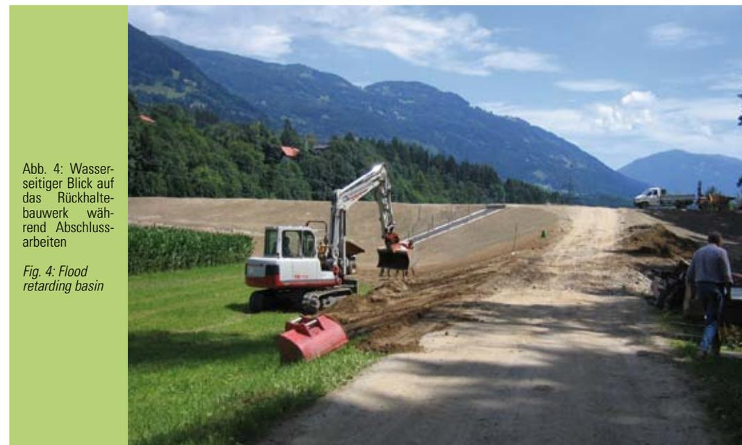
Abb. 4: Wasserseitiger Blick auf das Rückhaltebauwerk während Abschlussarbeiten
