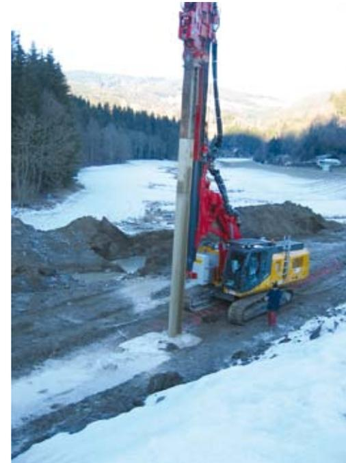
Abb. 6: Herstellung der Schmalwand: Der I-Träger, an dessen unterem Ende sich eine Düse befindet, wird mittels Rüttelbohle in den Boden getrieben.
