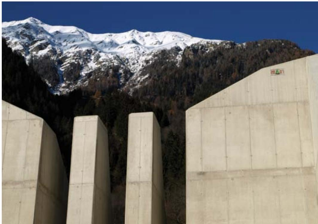
Abb. 2: Murbrecher am Tresdorferbach integriert in den Lawinenauffangdamm für die Lawine Tresdorferbach
