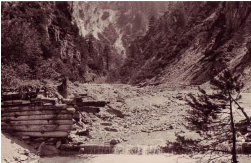
Abb. 1: Zerstörung des Querwerkes in Holzkastenbauweise am 14. Juni 1952
