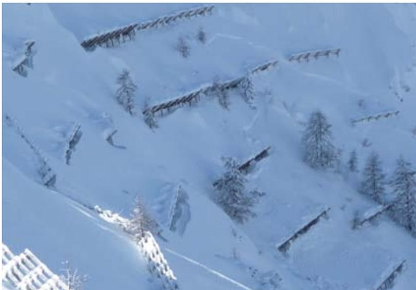
Abb. 8: Verfüllte Stahlschneebrücken im Winter 2008/2009 mit Abbrüchen innerhalb der Lawinverbauung
