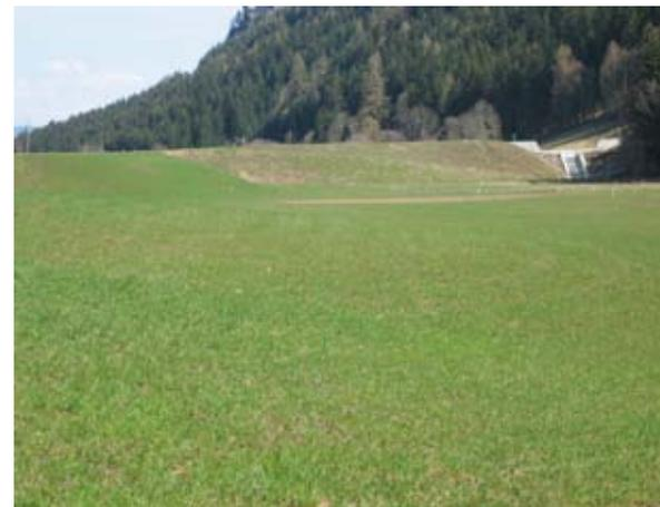
Abb. 2: Blick auf einen Teil des Dammes und das Auslaufbauwerk mit Rechen (Wasserseite). Der Homogendamm ist ca. 180 m lang und 9 m hoch. Für seine Errichtung wurden 30.000 m<sup>3</sup> Erdmaterial (gesiebt) aus einer nahe gelegenen Abbaufläche verwendet.
