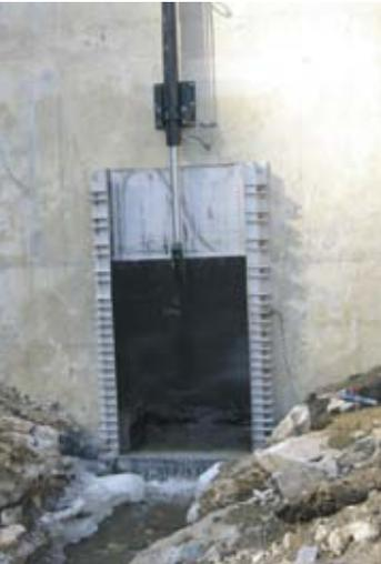
Abb. 7: Das hydraulisch verstellbare Schütz ist so eingestellt, dass beim Bemessungsereignis eine Reduktion der Hochwasserspitze von 37 m<sup>3</sup>/s auf 5 m<sup>3</sup>/s erfolgt.
