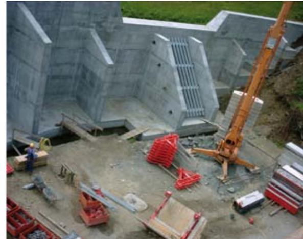
Abb. 1: Auslaufbauwerk während der Bauphase, der Wildholzrechen ist bereits eingebaut
