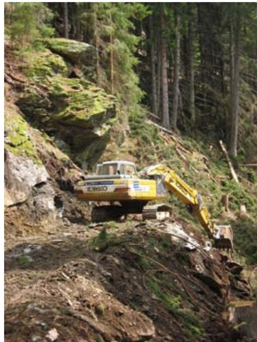
Abb. 5: Forstwegebau in felsigem Steilgelände
