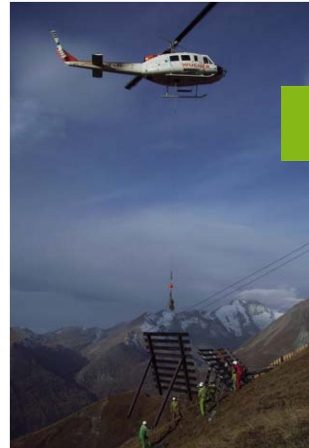
Abb. 4: Versetzen von Schneebrücken im Abbruchgebiet der Lawine Heiligenblut
