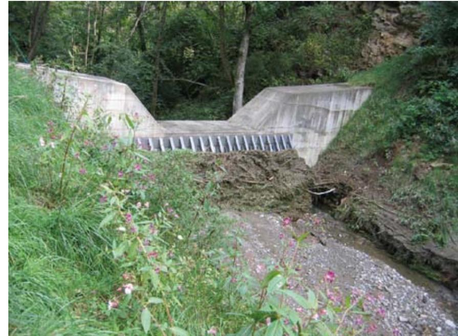
Abb. 9: Eine von drei bereits beaufschlagten Geschieberückhalte-sperren
