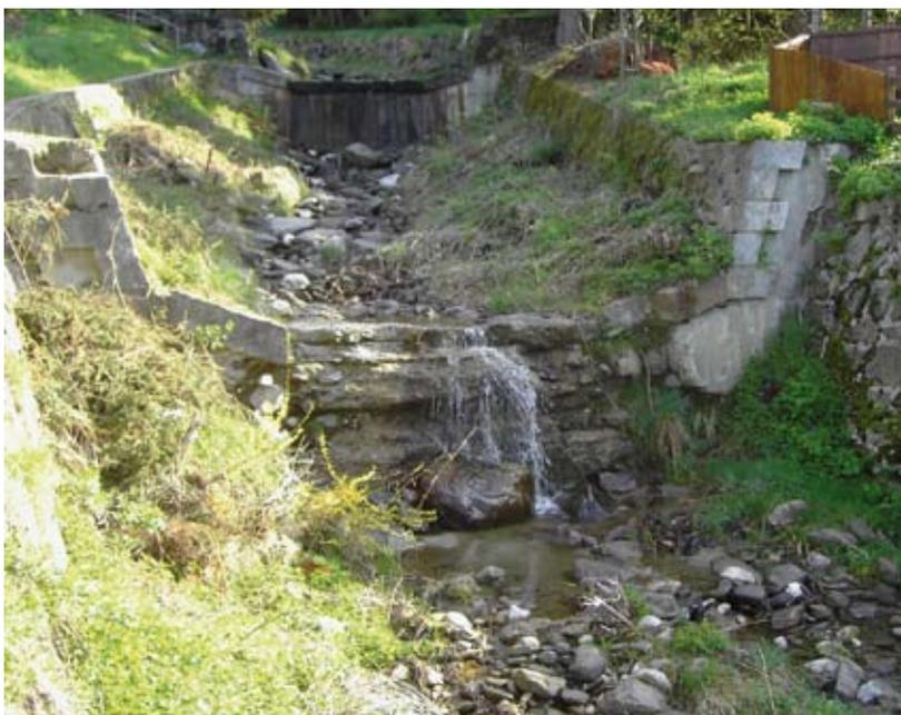
Abb. 5: Grundschwelle in Stampfbeton (Baujahr 1932, Ausbesserungsarbeiten 1949), Zustandsstufe 5 – schlechter Erhaltungszustand, Funktionsfähigkeit ist für das nächste Ereignis (HQ30) nicht gegeben, Schadenstypen: Verwitterung von Stampfbeton, Durchfeuchtung und Durchströmung
