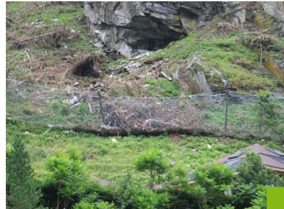
Abb. 7: Fertiggestelltes Steinschlagnetz ober Hotelanlage
