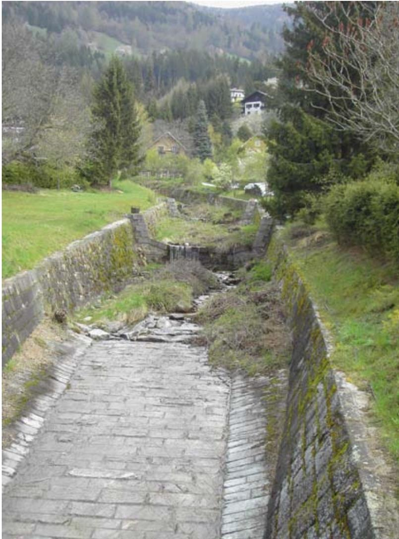
Abb. 7: Leitwerke, Gerinne (Baujahr 1955), Zustandsstufe 4 – mangelhafter Erhaltungszustand, eingeschränkt funktionsfähig, Verlandungen im Gerinne, teilweise Steine aus Fuß der Mauer herausgelöst
