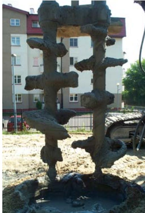
Abb. 6: Soilcrete-M-Gerät mit Doppelpaddel
