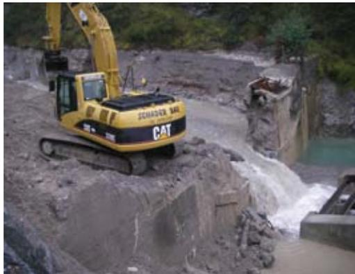
Abb. 5: Beginn des Sperrenabtrages (links) und teilweise geschleifte Sperre (rechts)
