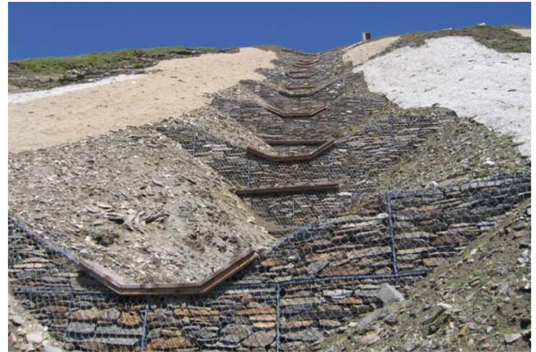
Abb.4: Grundschwellen mit Drahtschotterkörben und Erosionsschutzgewebe
