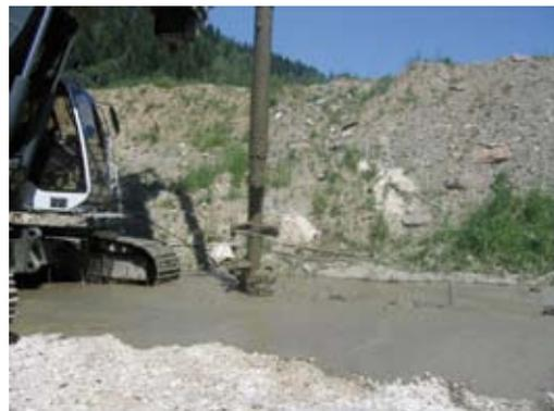
Abb. 5: Beim „deep soil mixing“ wird über ein rotierendes Paddel der Boden mit einer Zementsuspension vermischt.
