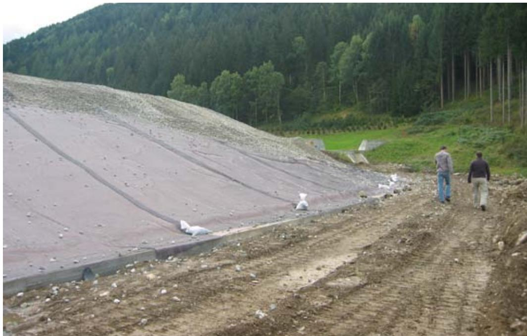
Abb. 4: Der gesamte Dammkörper wurde wasserseitig mit einer Dichtfolie überzogen, die einzelnen Dichtbahnen wurden miteinander verschweißt. Am unteren Ende ist der Schmalwandkopf, auf dem die Folie mittels Nirostaschienen befestigt wurde, erkennbar.
