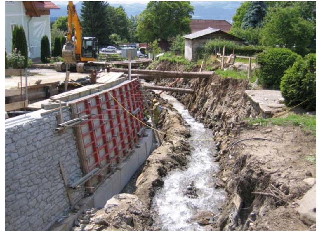
Abb.7: Uferleitwerke mit Strukturbeton kommen nur abschnittsweise und bei sehr begrenzten Platzverhältnissen zur Ausführung. Für die rechte Ufersicherung ist eine Grobsteinschichtung vorgesehen
