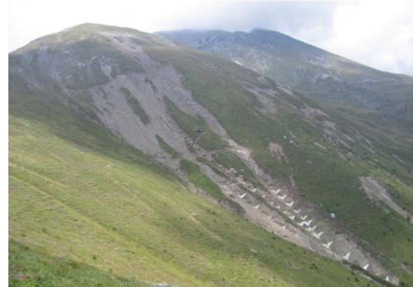
Abb.2 Erosionsflächen im Bereich des Steggrabens – Maßnahmen des Projektes – Konsolidierung der Bachsohle und Begrünung der offenen Flächen
