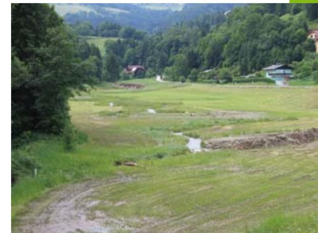
Abb. 3: Um ein ökologisch ansprechendes Bild zu erhalten, wurde der ursprünglich gerade Bachlauf in die Tiefenlinie des zuvor ausgehobenen Rückhaltebeckens verlegt und mäandrierend ausgebildet. Für die Ausformung des Rückhaltebeckens wurden rund 100.000 m<sup>3</sup> Erdmaterial bewegt.
