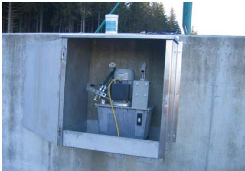
Abb. 8: Schaltkasten mit Hydraulik
