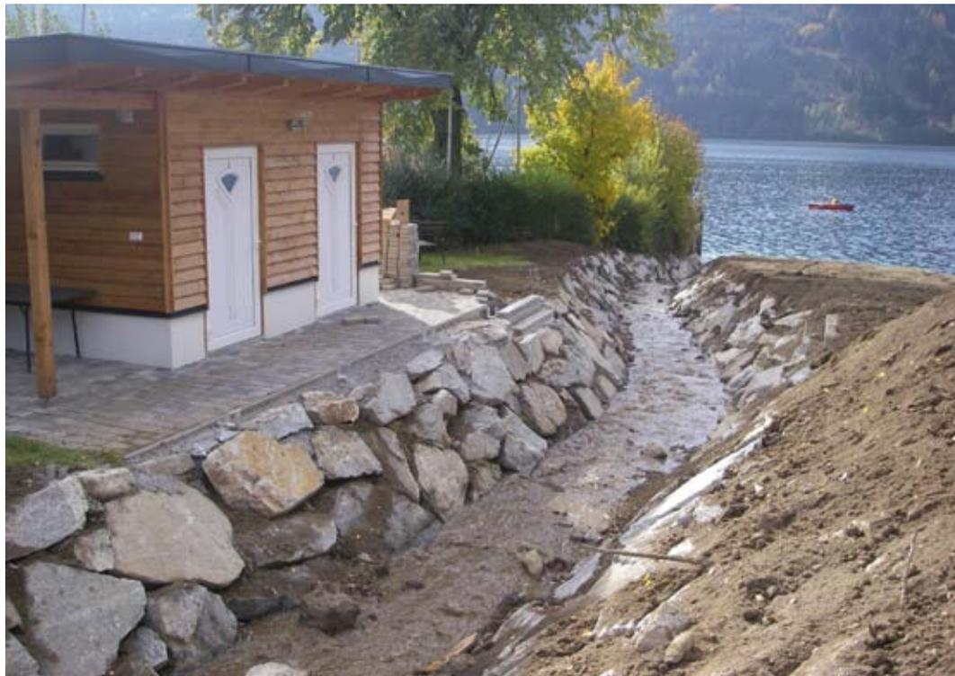
Abb. 7: Herstellung eines offenen Gerinnes im Bereich des Strandbades. Ursprünglich war dieser Bachabschnitt verrohrt (DN 600 mm) geführt.
