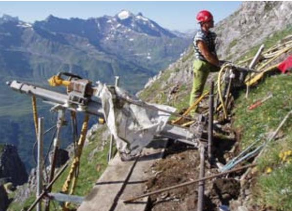
Abb. 7: Hydraulischer Außenlochhammer beim Einbau von Selbstbohrankern
