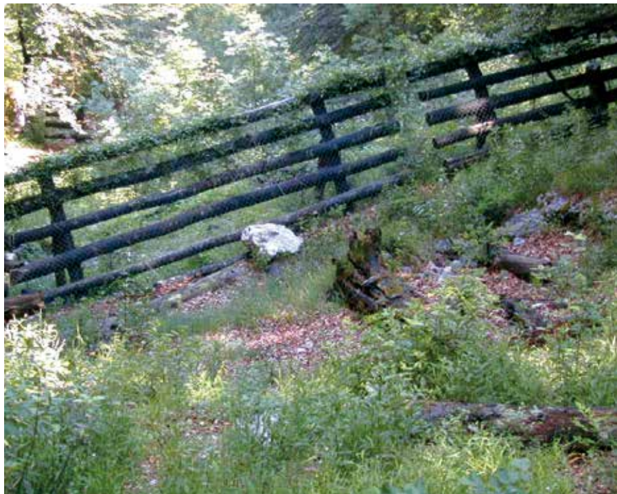
Abb. 4: Holzschnee- brücken aus Robinienrundholz
