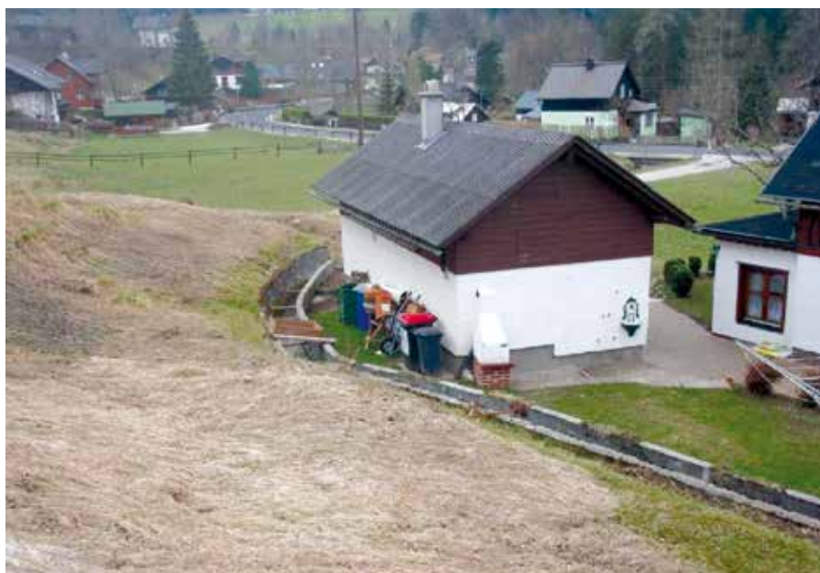
Abb. 6: Ehemaliges Gerinne in Betonschale, zukünftig natür- lich ökologisch (© Janu)
