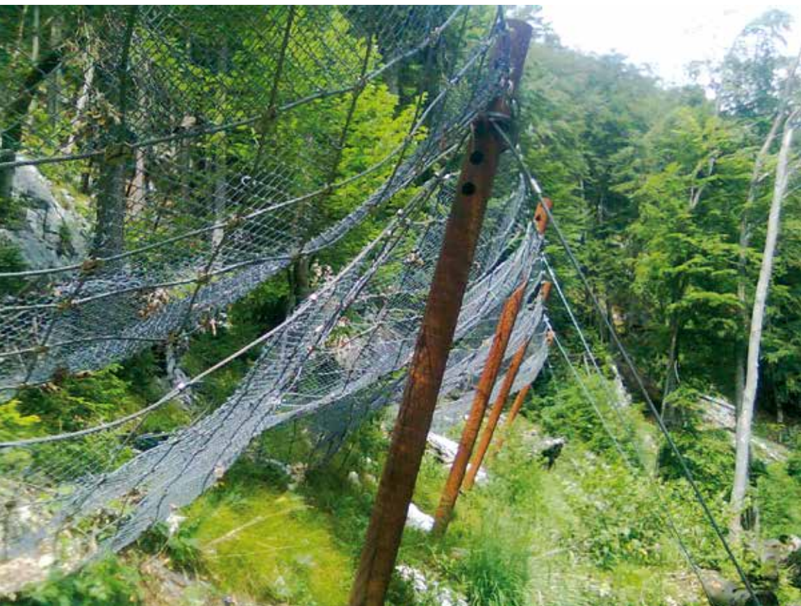
Abb. 11: Ergänzende Schneenetverbauungen im Bannwald Brentenkogel
