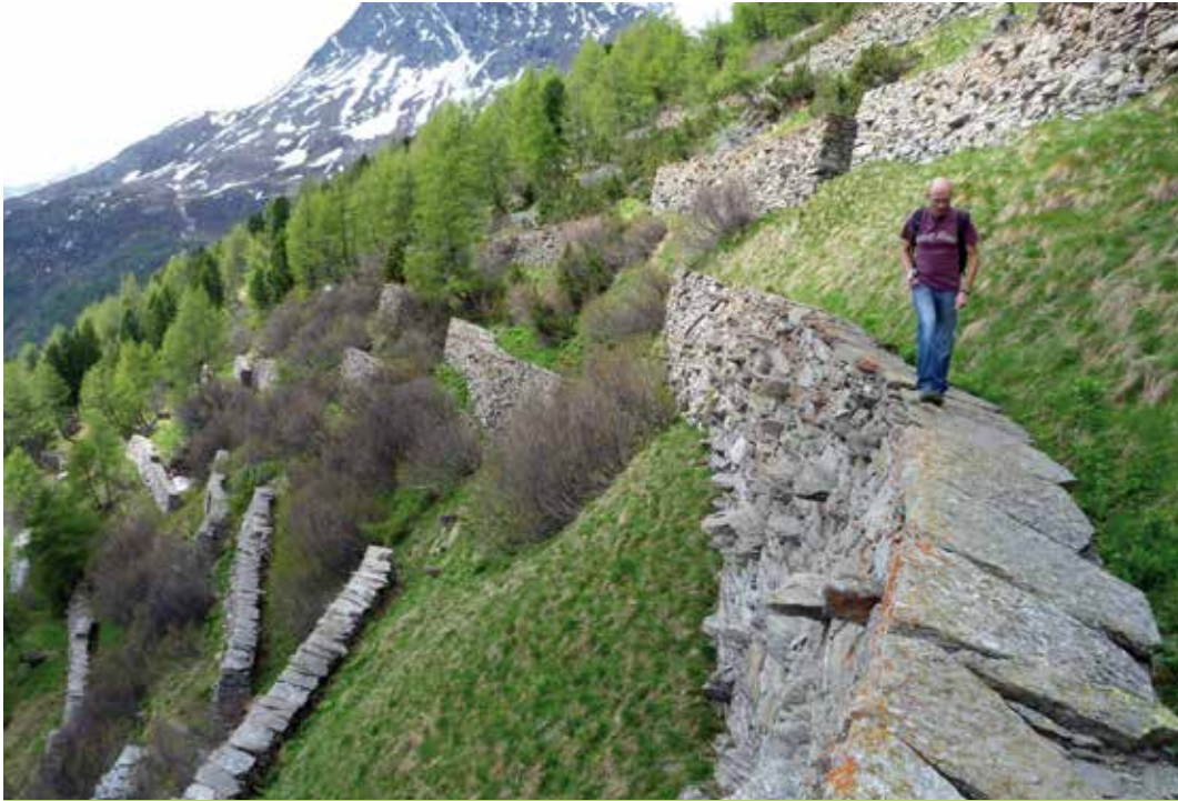
Abb. 1: Lawinverbauung aus Steinmauern bei der Alp Grüm zum Schutze der Berninastrecke der Rhätischen Bahn, Baujahr 1913 bis 1939 (Foto: S. Margreth).
