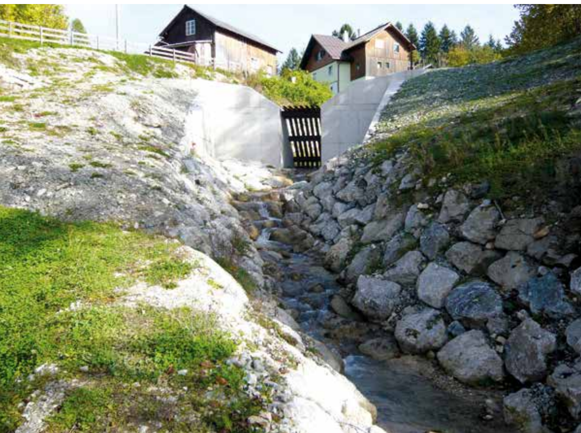
Abb. 8: Geschiebesperre Fassungsvermögen ca. 600 m 3 , Organismenpassierbarkeit ist gegeben (© Janu)
