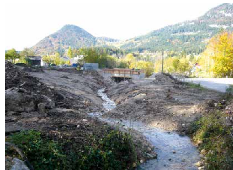
Abb. 10: Oberlauf: Vorlandsicherung mit Grobsteinschichtung, Böschungen mit eingebauten Wurzelstöcken überschüttet, Gerinne kann sich links und rechts auf einer Breite von ca. 2m frei entfalten (© Janu)
