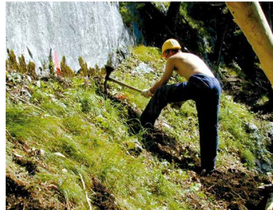
Abb. 3: Aufforstungs- und Gleitschneeschutzmaßnahmen (Anlegen von Bermen)
