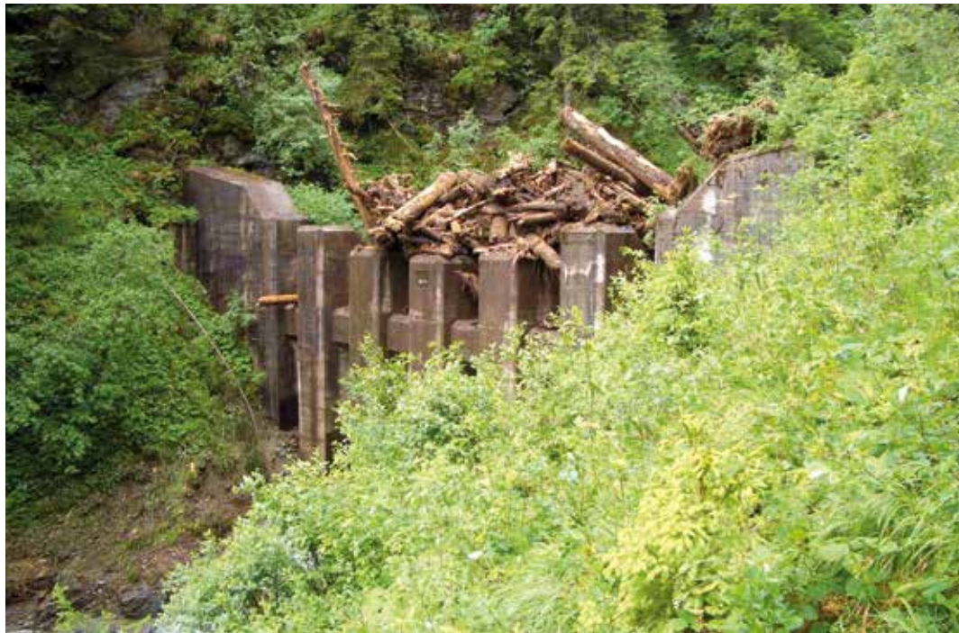
Abb. 3: Wildholzurückhalt durch einen Murbrecher im Reitersbach (© WLV Salzburg)
