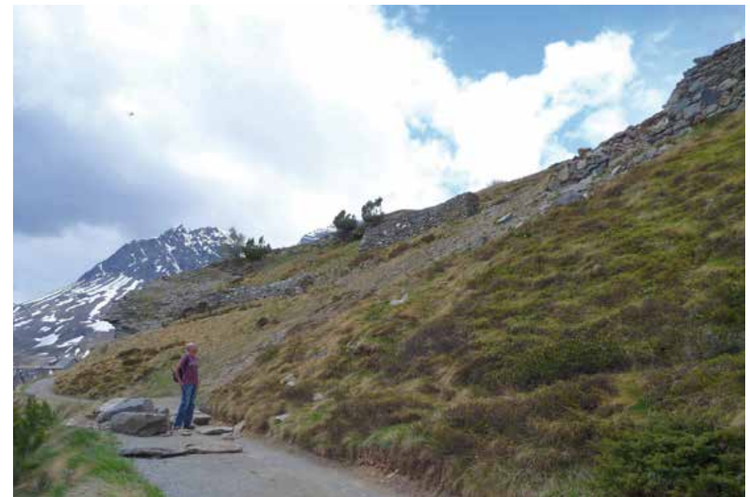
Abb. 3: Eingestürzte Steinmauer verschüttet einen Weg bei der Alp Grüm (Foto: S. Margreth).
