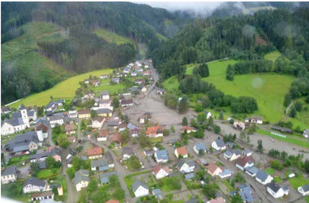
Abb. 1: Murenkatastrophe von St. Lorenzen (Triebeben, Steiermark) vom 21.7.2012 (© WLV)
