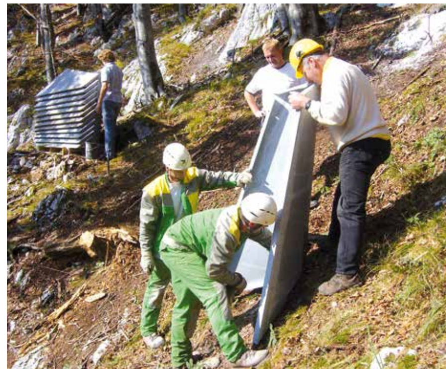
Abb. 7: Gleitschnee- schutz: Montage von Snowgrip- pern
