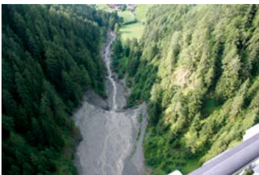
Abb. 10: Geschieberückhaltebecken hm 18,3: Ablagerung von 25.000 m³ Geschiebe (bachabwärts schauend)
