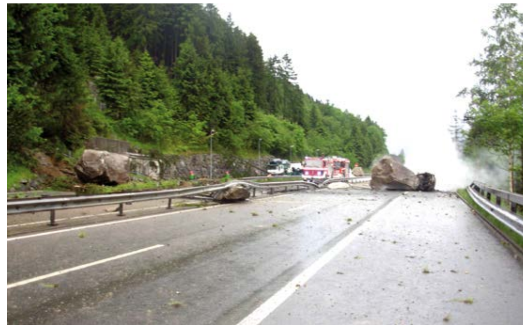
Abb. 1: Der Felssturz auf die Gotthardautobahn am 31. Mai 2006 (Foto: W. Arnold, Amt für Tiefbau UR).
