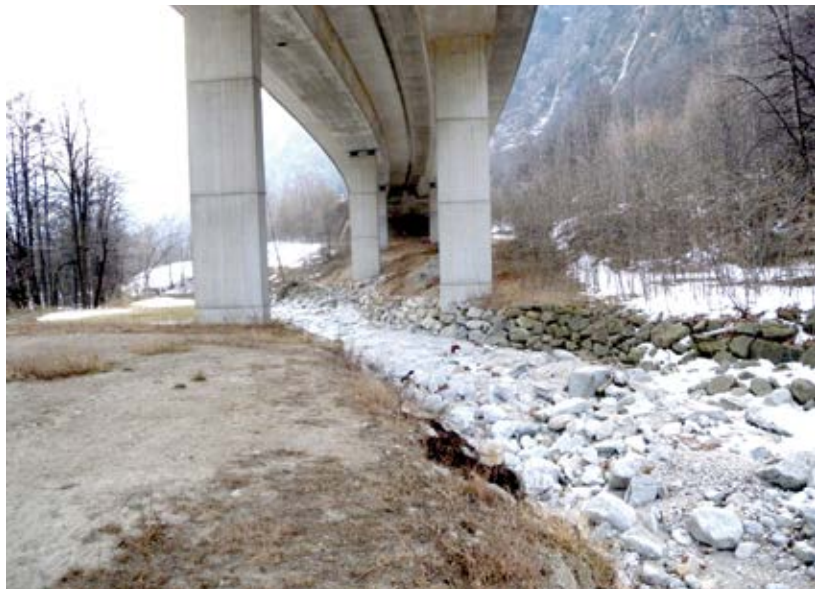
Abb.3: Auch die Gefährdung der Brückenpfeiler durch Unterkolkung ist zu beurteilen (Foto: Judith Dobmann, Geo7).
