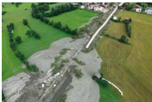
Abb. 11: Beginn der flächigen Ablagerung unterhalb der Unterlaufregulierung zwischen hm 0,0 und hm 5,3
