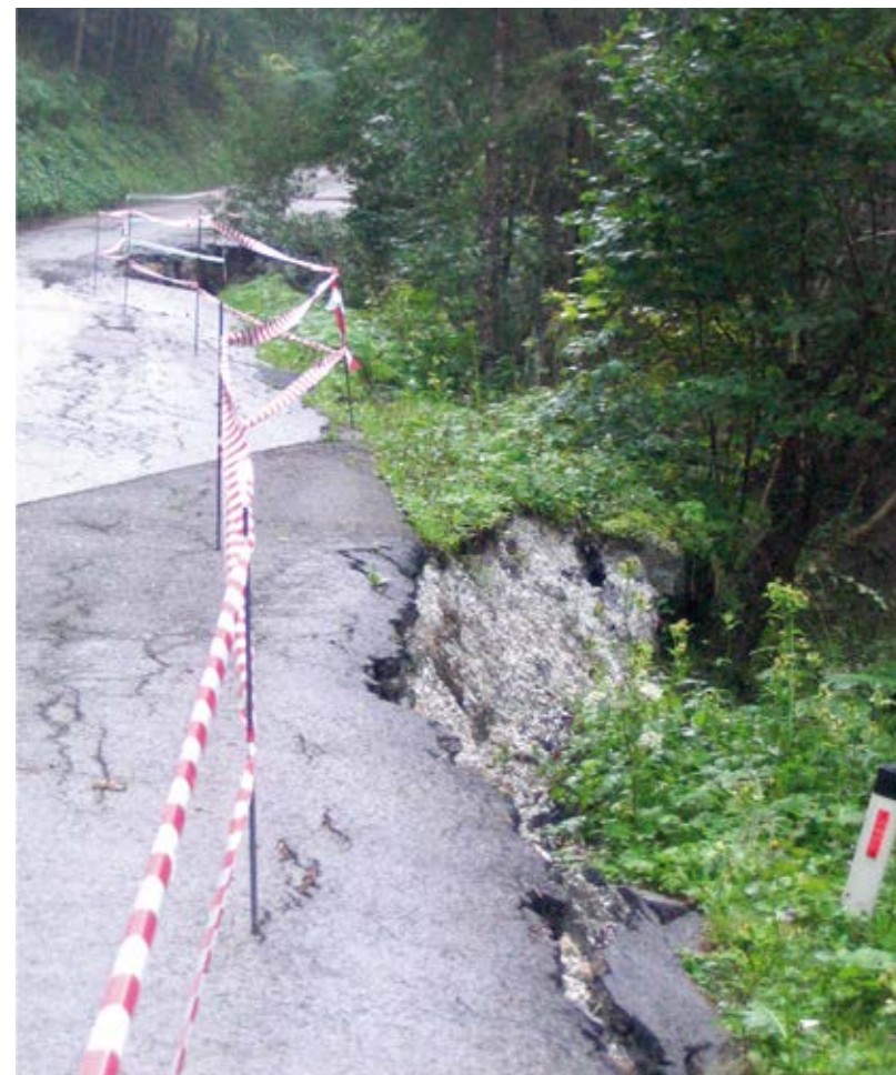
Abb. 2: Offensichtlicher Einfluss des Straßen- und Wegebaues auf die Auslösung von Rutschungen
