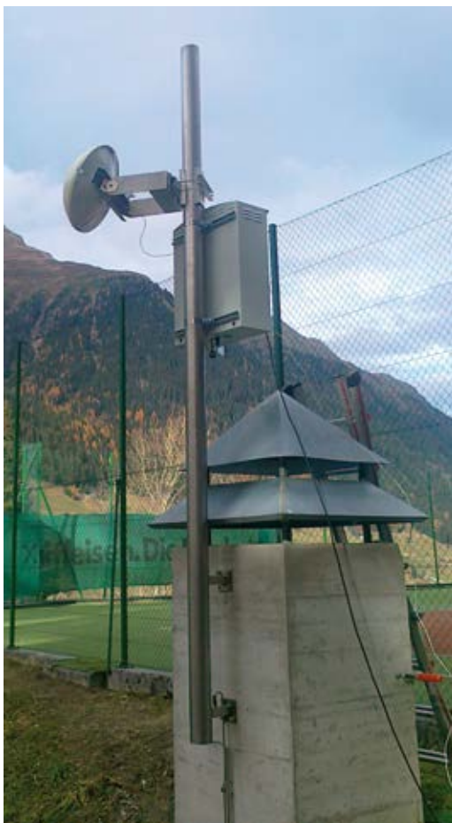
Abb. 4: Das Lawinenradar, installiert am Tennisplatz der Gemeinde Ischgl mit Blick auf die Großtal-Lawine. Stromversorgung mit Kabel und Internetanbindung mit Mobilfunknetz. Zum Schutz vor Schnee wurde nachträglich noch ein Dach über die Antenne an den Mast geschraubt.
