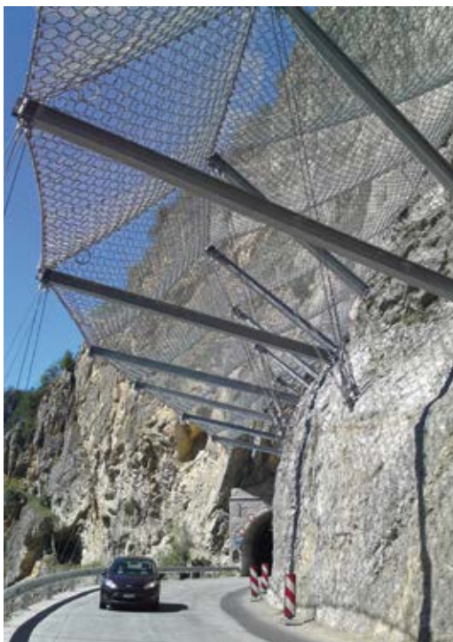
Abb. 8: Installiertes Schutzsystem im ersten Jahr nach der Wiedereröffnung der Straße.
