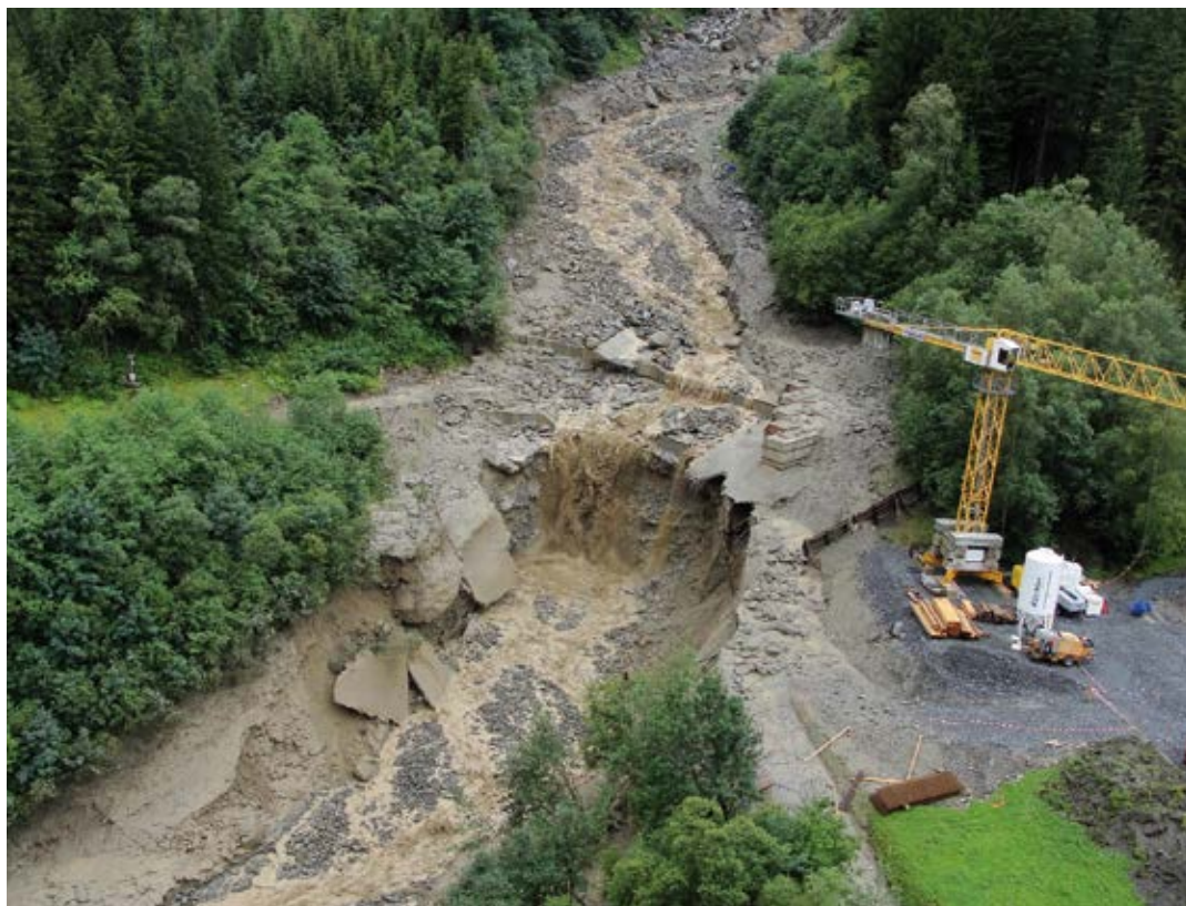
Abb. 3: Beeinträchtigttes Querungsbauwerk am Spreitgraben (Kull et al., 2012)
