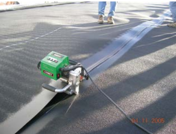
Abb. 4: Folienschweißgerät
