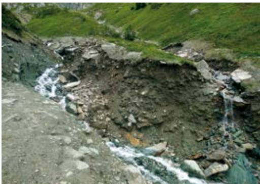
Abb. 8: Sohl- und Ufererosion bei hm 34,6 im unteren Sammelgebiet (bachaufwärts schauend)
