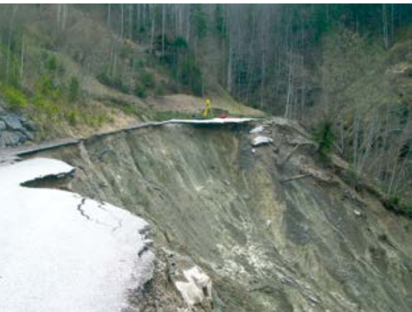
Abb. 2: Links: Muranbruch, Hangrutschung als auslösendes Ereignis. Rechts: Situation im Graben.
