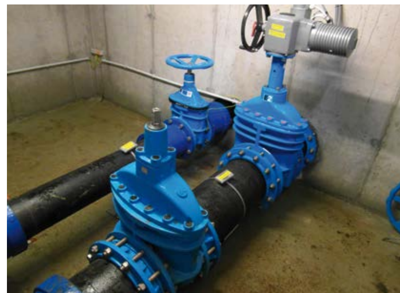
Abb. 8: Grundablassverschlüsse
