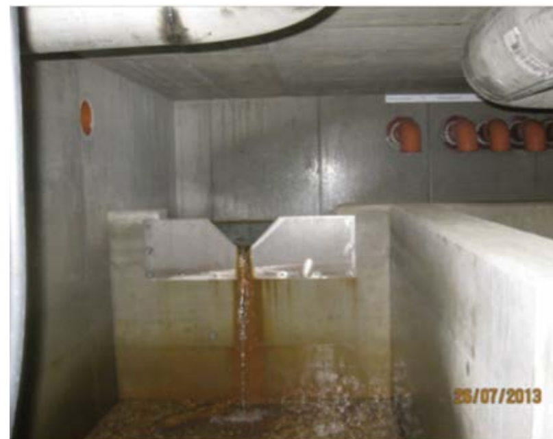
Abb. 7: Messwehr für Sickerwassererfassung (© Eistert)
