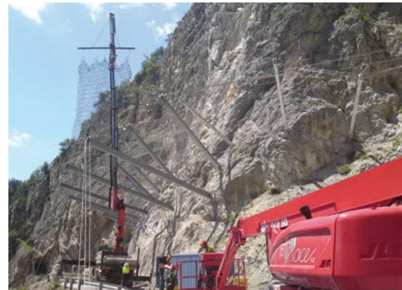
Abb. 6: Montage der Ringnetze.
