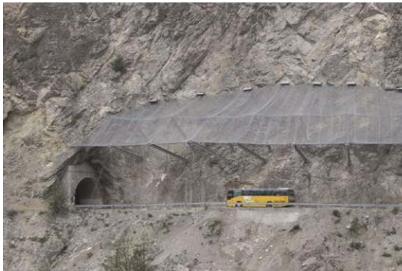
Abb. 7: Fertig gestelltes und für den Verkehr freigegebenes Galeriedach Pontis Süd.
