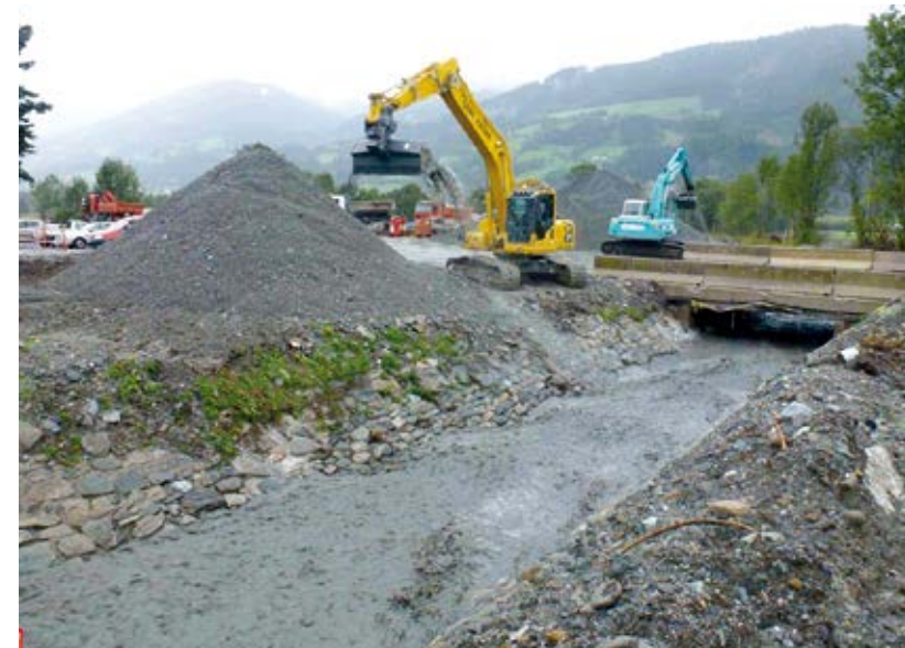
Abb. 5: Baggereinsatz nach dem Ereignis
