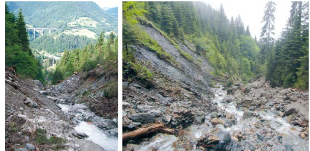
Abb. 13: Situation im Mittellauf (ausgeräumter Querschnitt bis auf Felssohle)
