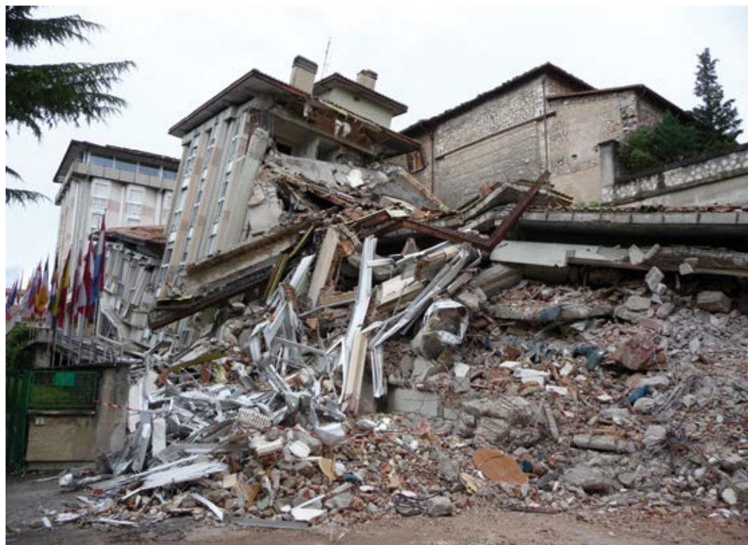
Abb. 10: Das Erdbeben in den Abruzzo, vom 6. April 2009 beschädigte oder zerstörte rund 15.000 Gebäude.
