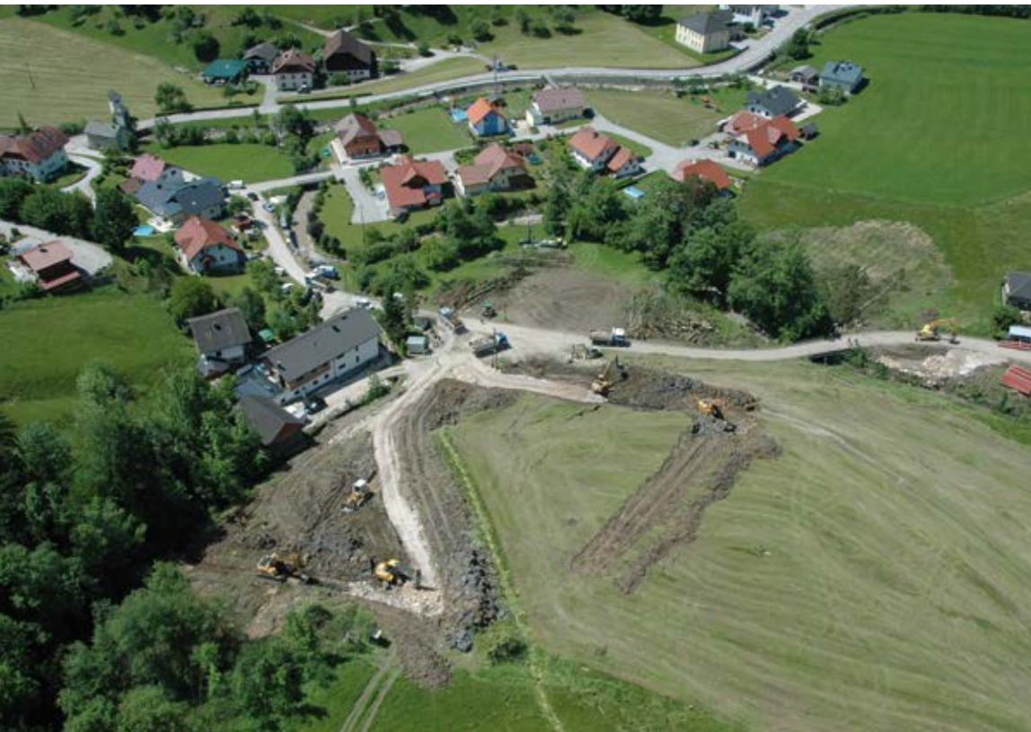
Abb. 2: Der südwestliche Auslaufbereich der Rutschung mit der Ortschaft Pechgraben
