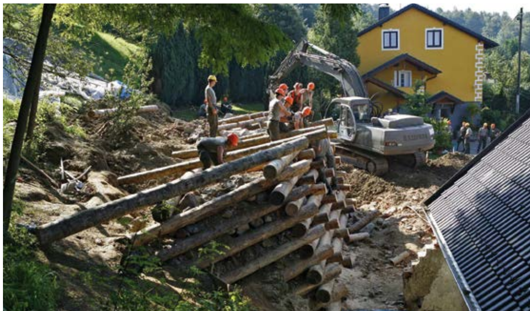
Abb. 6: Bau einer Krainerwand zur Hangstabilisierung (Foto: Bundesheer/Wolfgang Grebien)
