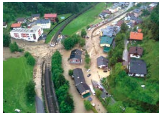
Abb. 11: Situation im Mündungsbereich in den Fritzbach
