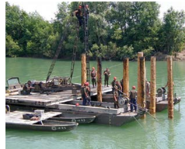
Abb. 4: Dieselramme auf Fähre zum Errichten von Brückenjochen (Foto Bundesheer/PiB3)
