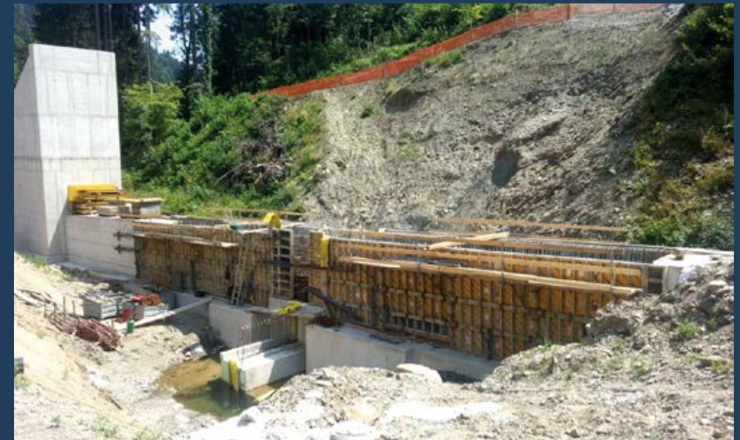
Abb. 1: Hochwasserrückhaltebecken Lankowitzbach, im Bau (© WLW Steiermark)
