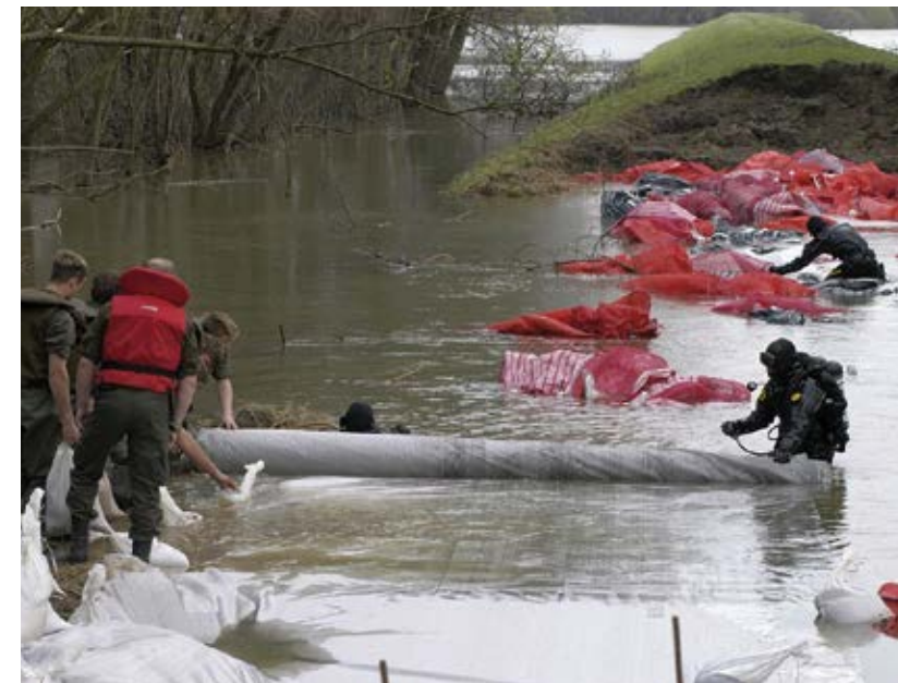
Abb. 8: Pioniertäucher beim Schließen einer Dammlücke (Stillfried, 2006; Foto Bundesheer/PiB3)
