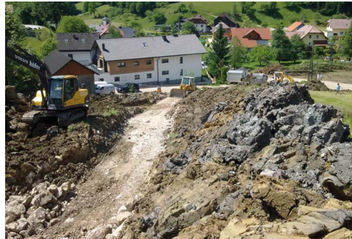
Abb. 3: Stützrippen und Materialaustausch von unten beginnend als erste Gegenmaßnahme
