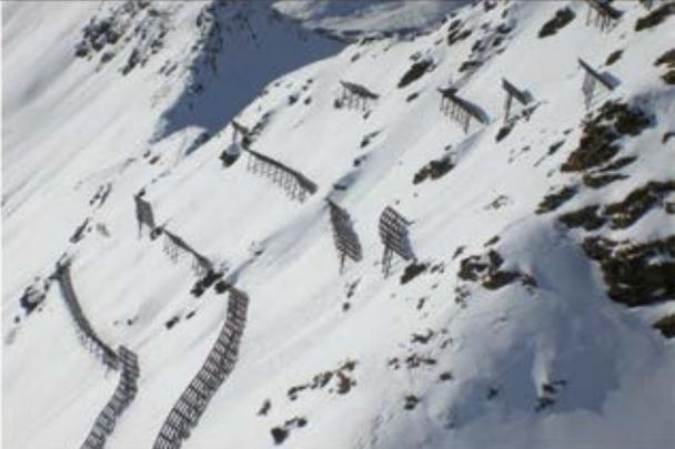
**Stahlschneebrücken • Gleitschneeböcke • Triebsschneewände**
