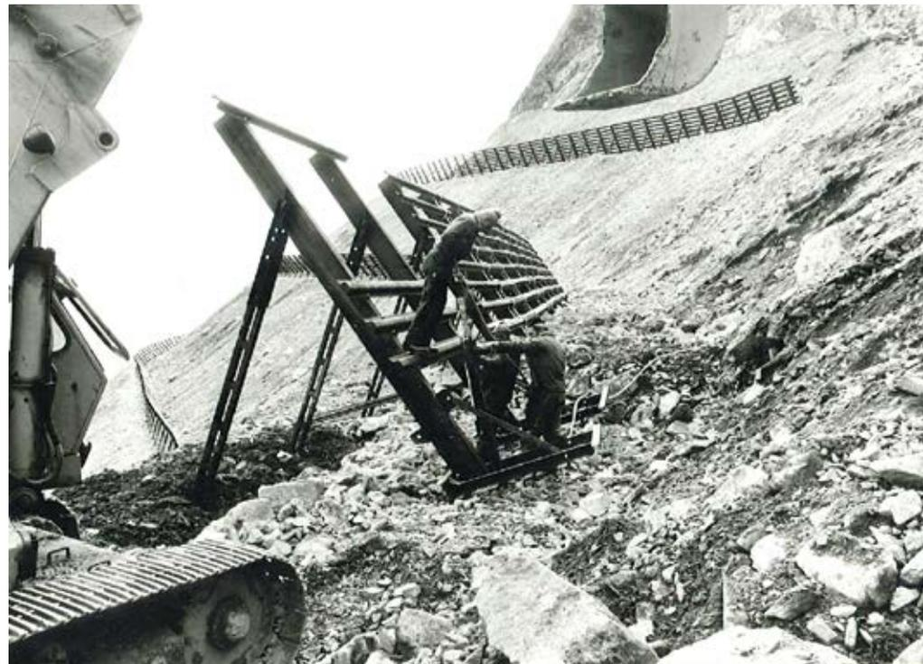
Abb. 3: Einbau desselben Werkes wie in Abb. 2; der Bagger arbeitet am Aushub für die nächste Stahlschneebrücke.
