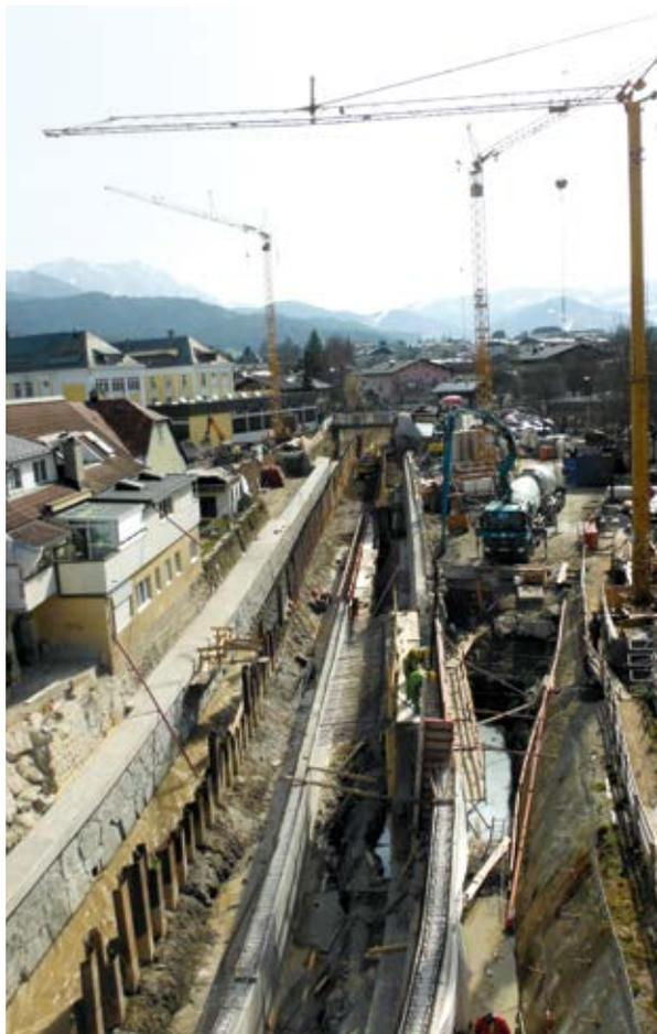
Abb. 6: Fertig gestellte Unterfangung mit vorgesetzter neuer Ufermauer (links im Bild); die gegenüberliegende Ufersicherung ist in Bau und wird als Doppelpprofil ausgebildet.
