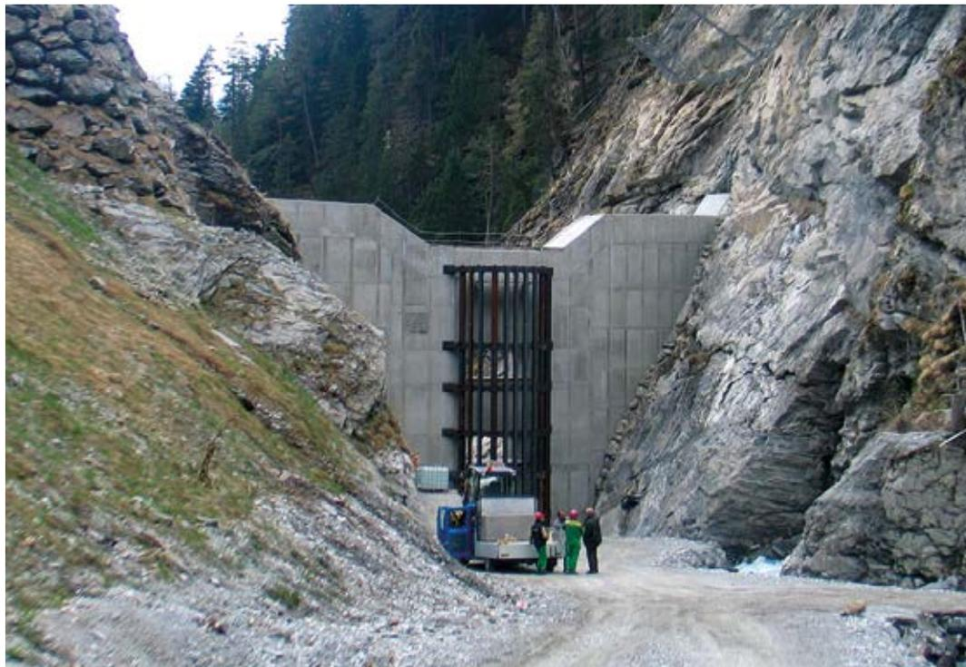
Abb. 13: Rechenkonstruktion
