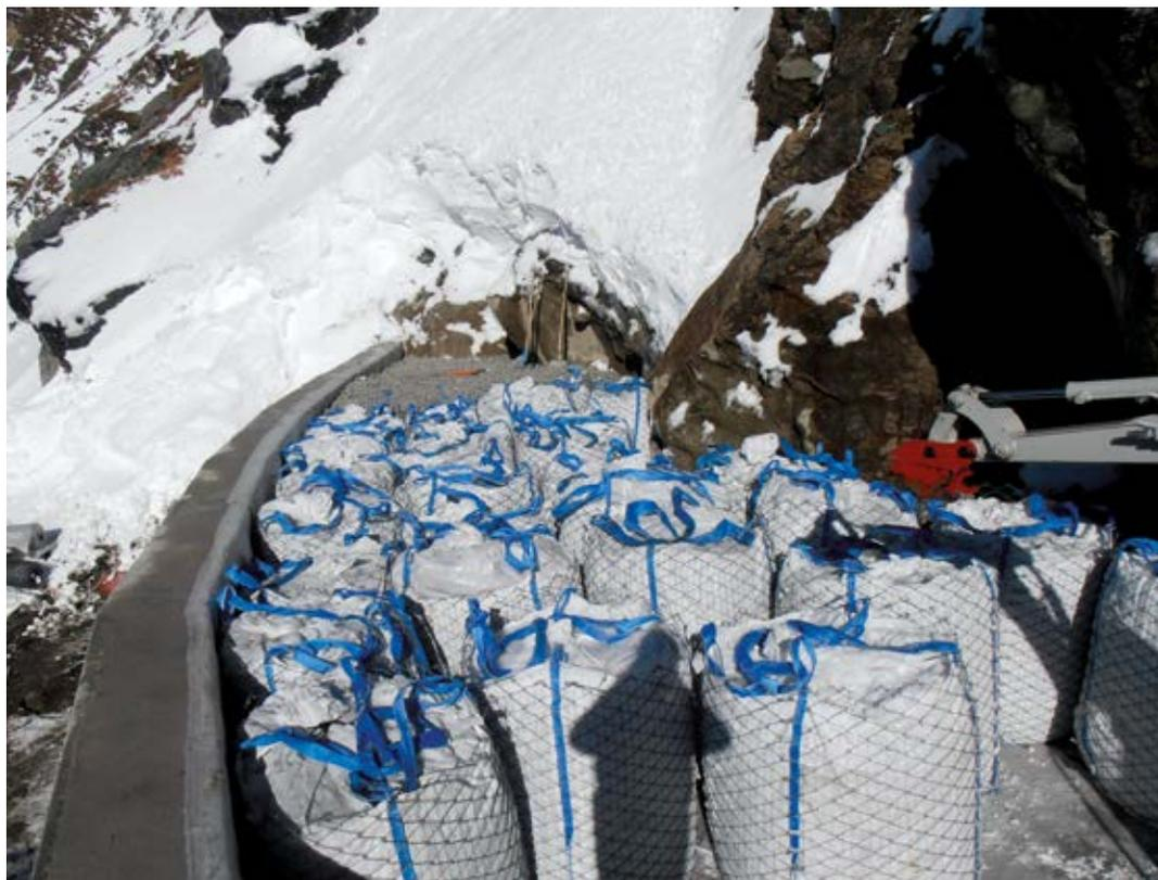
Abb. 15: Steinschlagdämpfungssystem Gamsgrubenweg, Großglockner (Quelle: GROHAG)
