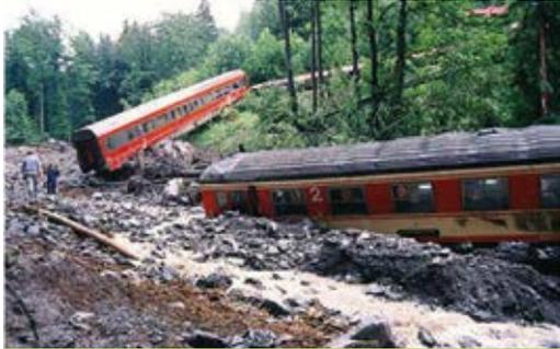
Abb. 24: Arlbergbahnstrecke, Steinschlag, Muren, Hochwasser (Quelle: Internet)
