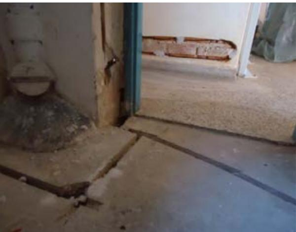
Abb. 9: Verhinderung des Kapillaraufstiegs – Bauteilheizung
