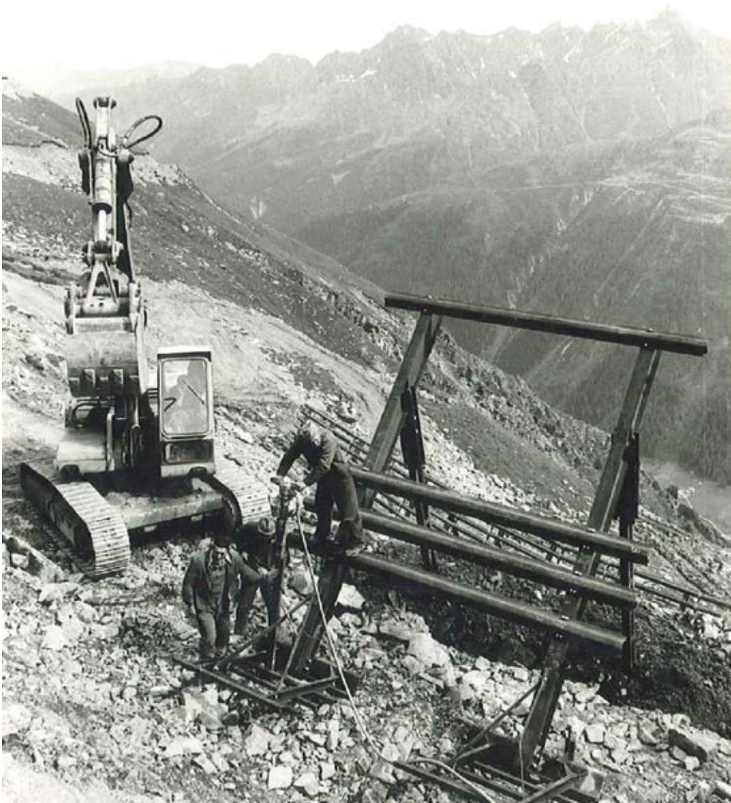
Abb. 2: Einbau eines ÖAM-Werkes 4,95s (Anmerkung Dk = 3,5 m) mit Rostfundierung auf der Lawinenterasse. Die Roste werden zusätzlich mit je einem T-Pfahl „angenagelt“.
