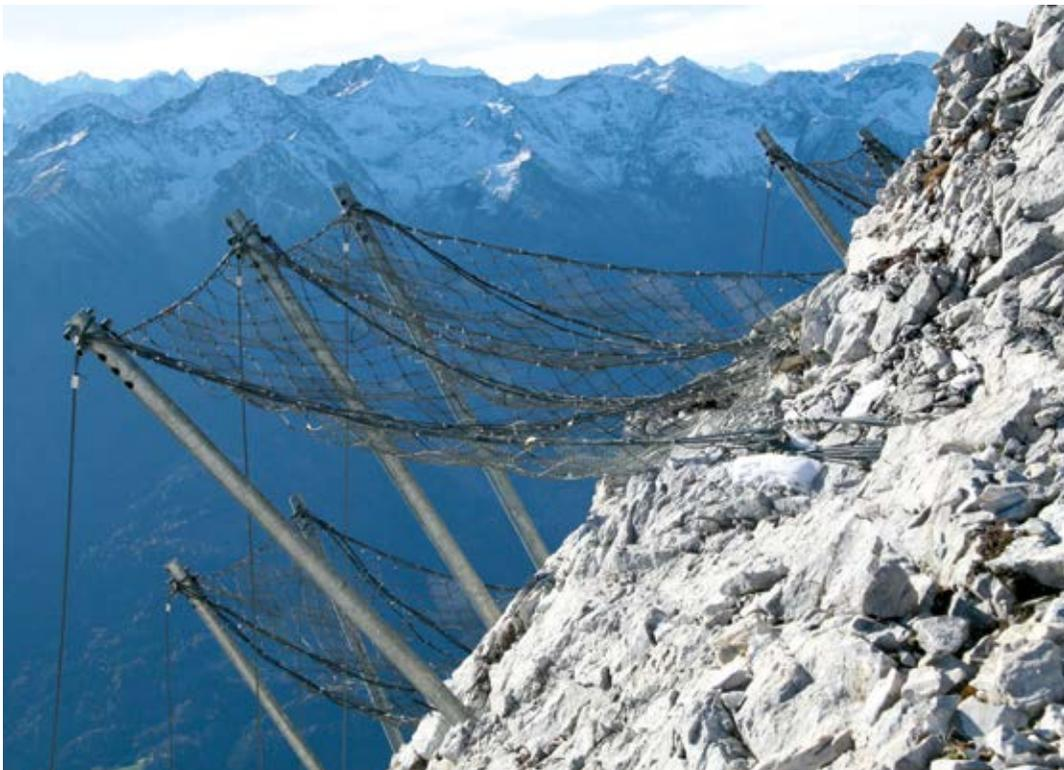
Abb. 13: In ebenmäßigem Gelände sind die Netze leicht anzuordnen
