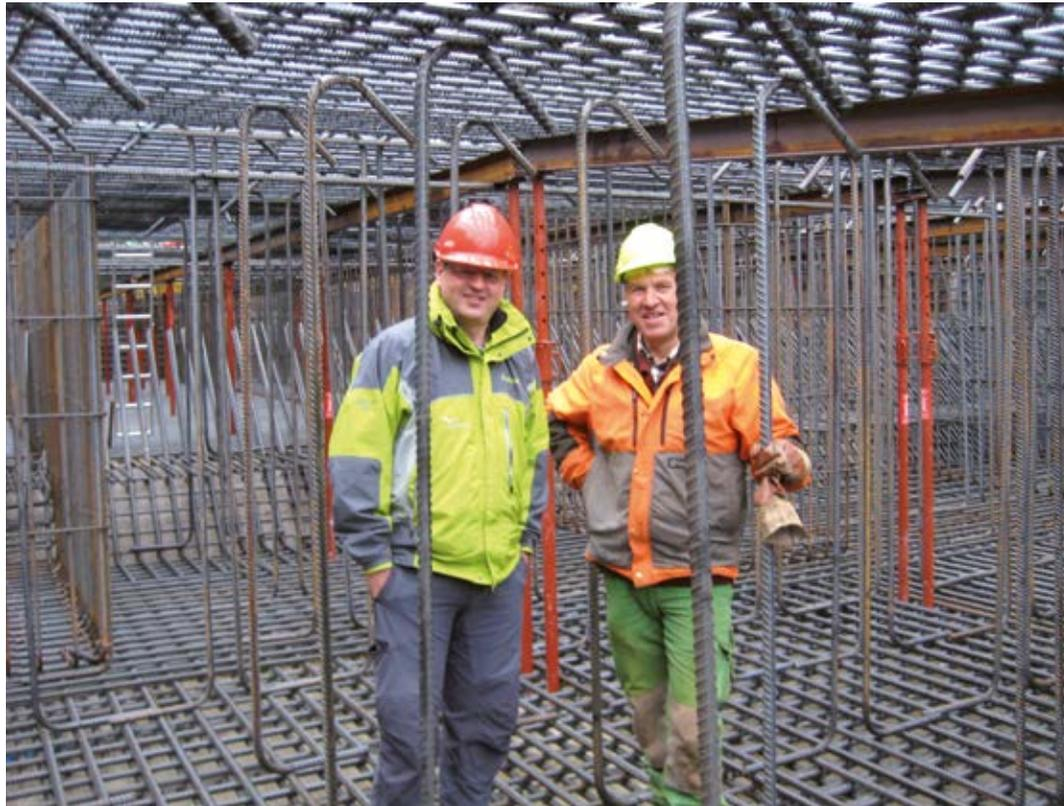
Abb. 6: Bewehrung der Fundamentplatte
