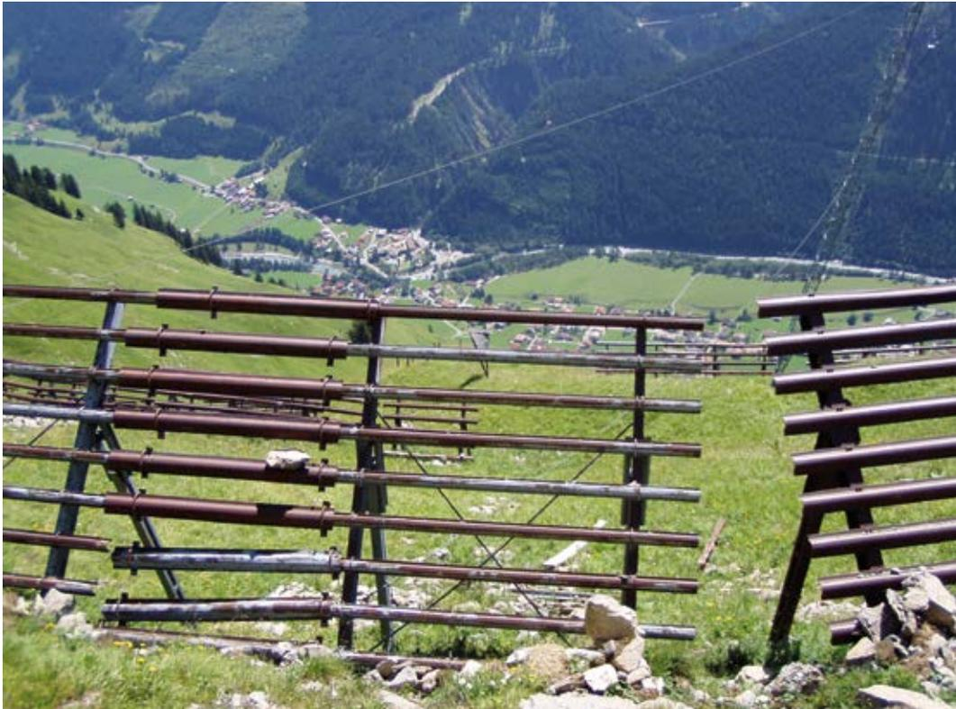
Abb. 7: Stützverbauung mit Stahlschneebrücken aus den sechziger Jahren des vorigen Jahrhunderts am Heuberg in Häselgehr. Dringender Sanierungsbedarf und Anpassung an zeitgemäße Dimensionierung ist offensichtlich
