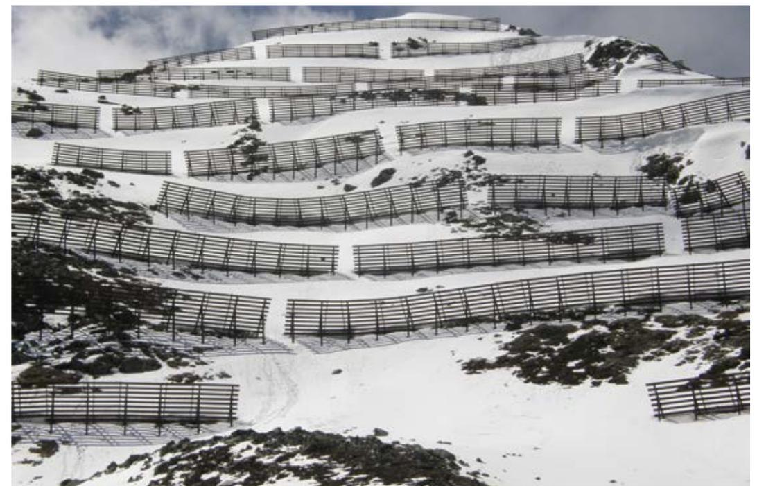
Abb. 6: Richtliniengemäß errichtete Stützverbauung mit Stahlschneebrücken
