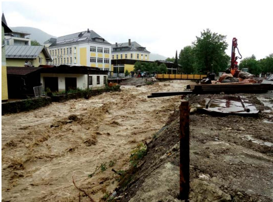
Abb. 1: Hochwasserereignis am 2.6. 2013 im Bereich der Baustelle. Die Spundwand in der Bachmitte ist gerade noch sichtbar.
