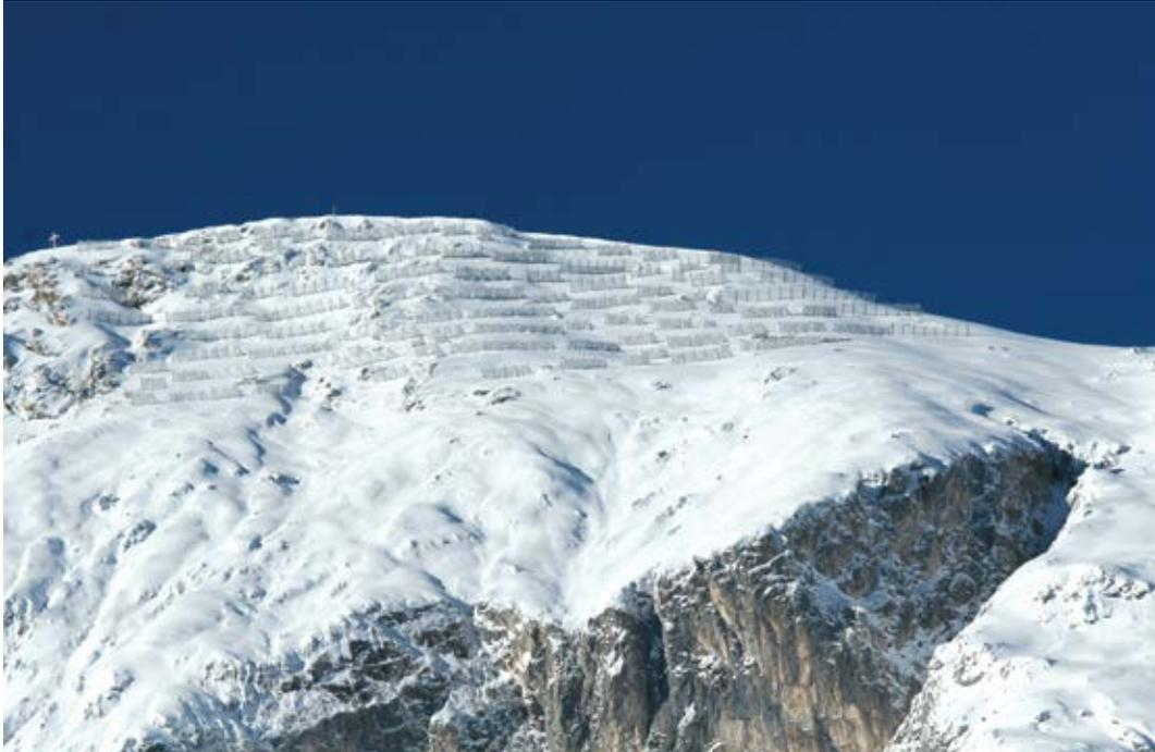
Abb. 4: Anbruchverbauung mit Schneenetzen; der untere Teil des Anbruchgebietes wurde nicht mehr gesichert, Untersuchungen ergaben, dass Lawinen aus diesem Restanbruchgebiet die Siedlung nicht mehr gefährden können.
