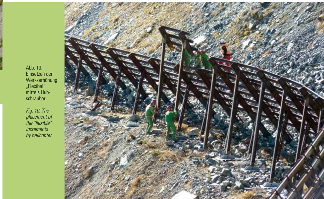
Abb. 10: Einsetzen der Werkserhöhung „Flexibel“ mittels Hub-schrauber.
