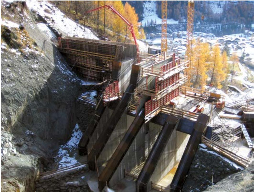
Abb. 7: Betonieren des oro. linken Flügels
