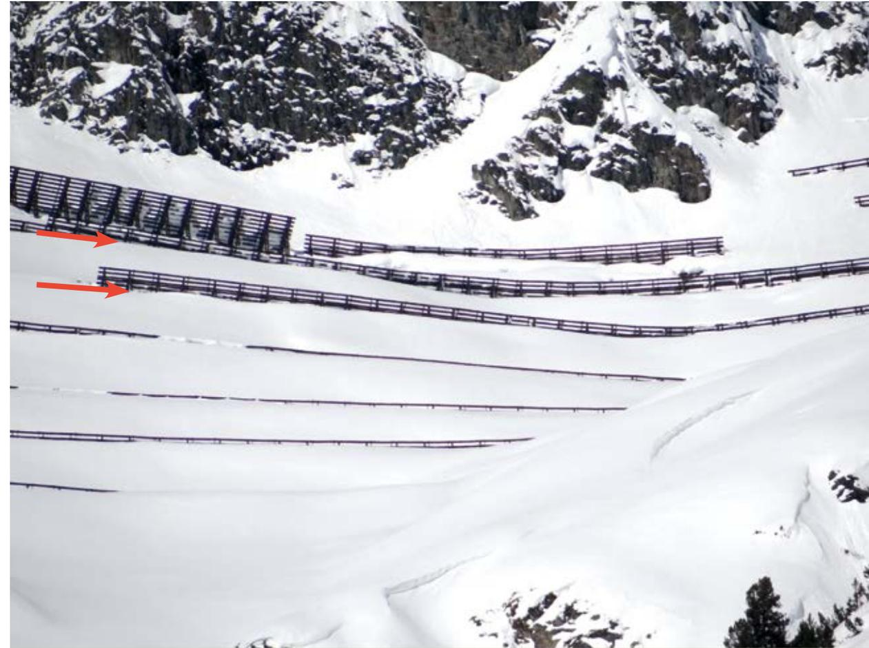
Abb. 11: Die erste „Belastungsprobe“ im Winter 2012/2013 wurde schadlos bestanden; die erhöhten Werke durchstoßen die Schneedecke. Die beiden Pfeile verdeutlichen den Standort der im Baujahr 2012 erhöhten Werksreihen.
