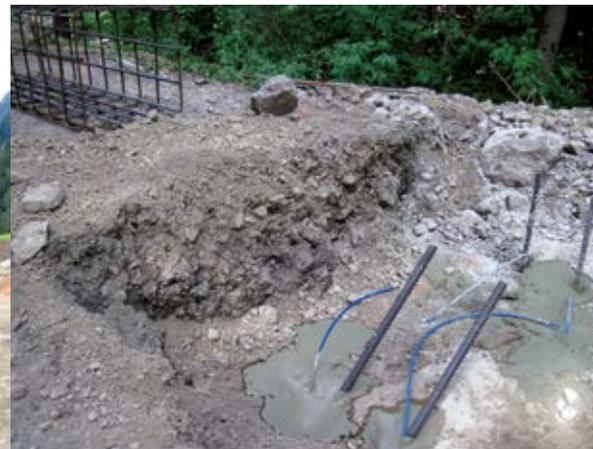
Abb. 17: Links: Fundamentherstellung bei den Werksreihen ohne bergseitige Abspannung; rechts: über den adaptierten Einfahrtsbereich verlängertes Netz mit bergseitiger Abspannung im Norden
