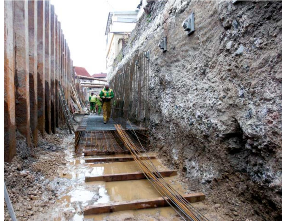
Abb. 5: DSV-Unterfangung mit Spannanker an der Urslau
