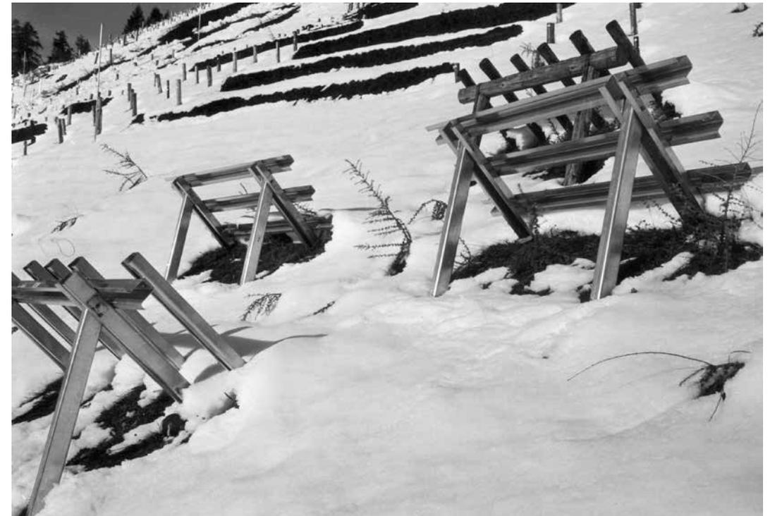
Abb. 1: In den Jahren 1952 bis 1955 wurden im SLF-Versuchsverbau Dorfberg verschiedene Baumaterialien, Werktypen und Anordnungen untersucht. Die Schneerechen und Schneebrücken auf dem Bild sind aus Aluminium gefertigt. Um Verformungen infolge Schneedrucks einfacher beurteilen zu können, wurden die Bauteile leichter konstruiert.
