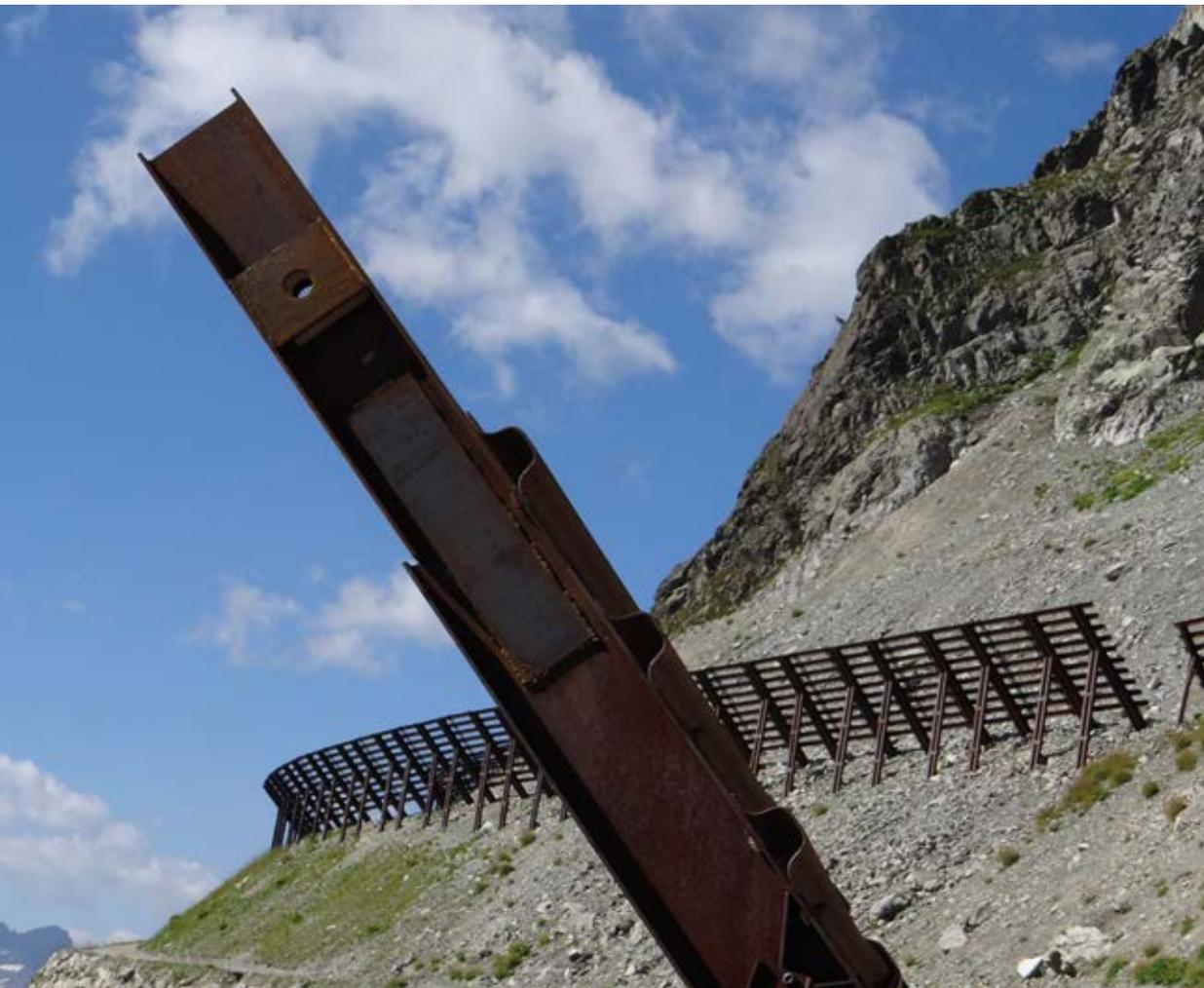
Abb. 8: Erhöhung der Type „Starr“ mit beidseitigen Schweißplatten an den Trägersteg; bei dieser Erhöhung wurde ein IPE 270 (Erhöhung 1,18 m) auf einen IPE-300-Träger vor Ort geschweißt.
