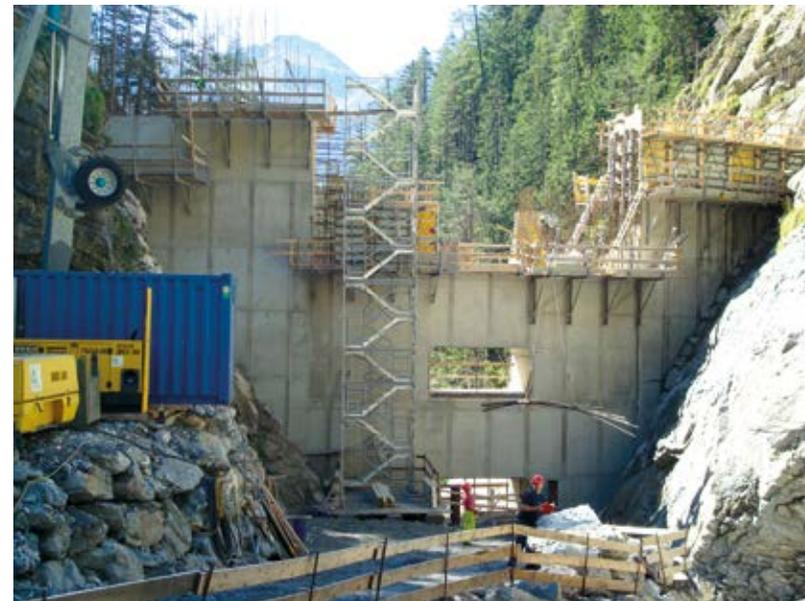
Abb. 11: Wasserseitige Ansicht Betonier- und Schalungsarbeiten
