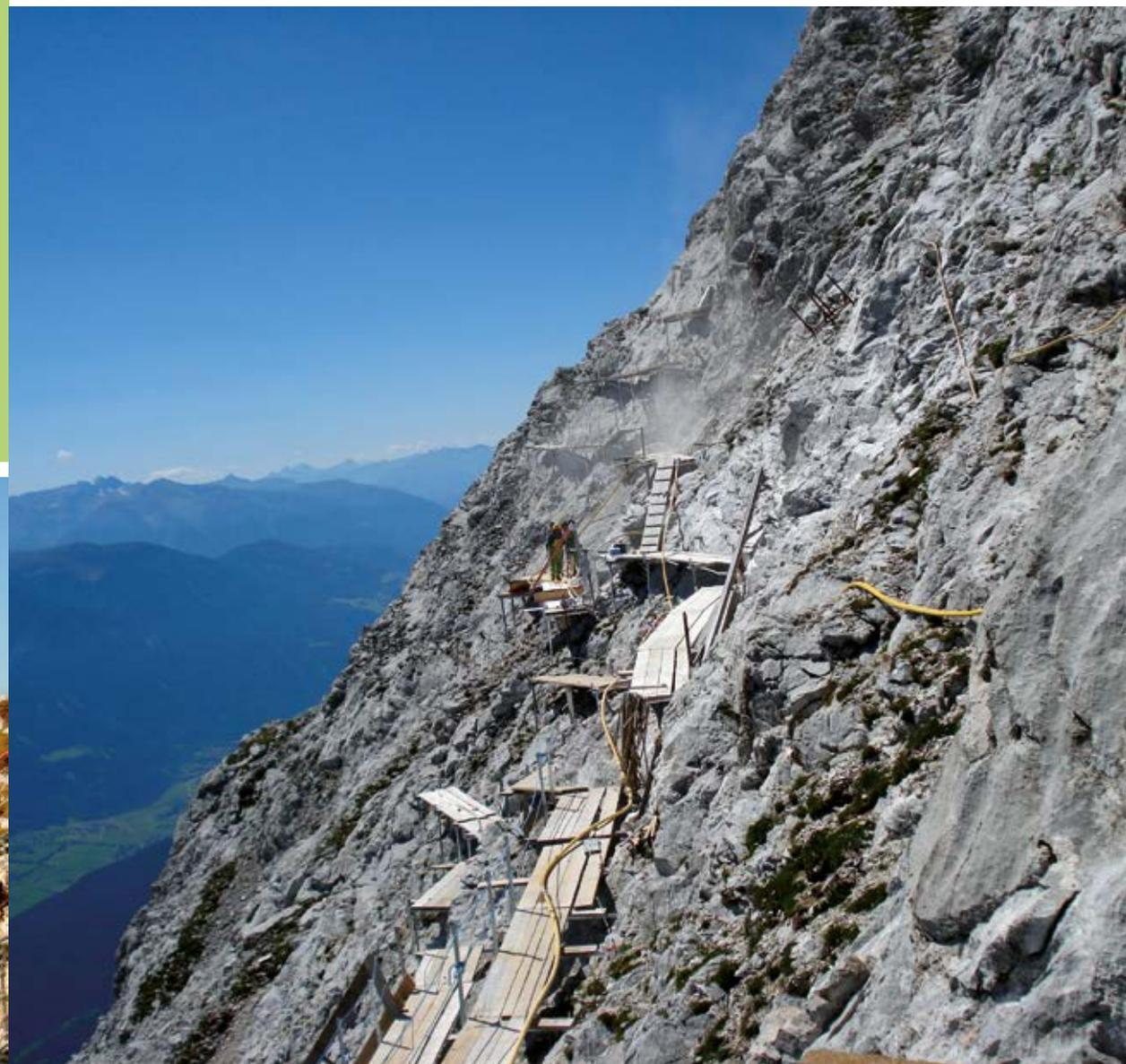
Abb. 7: Baustellenhilfseinrichtung in Form von Holzwegen entlang der Bohrebenen
