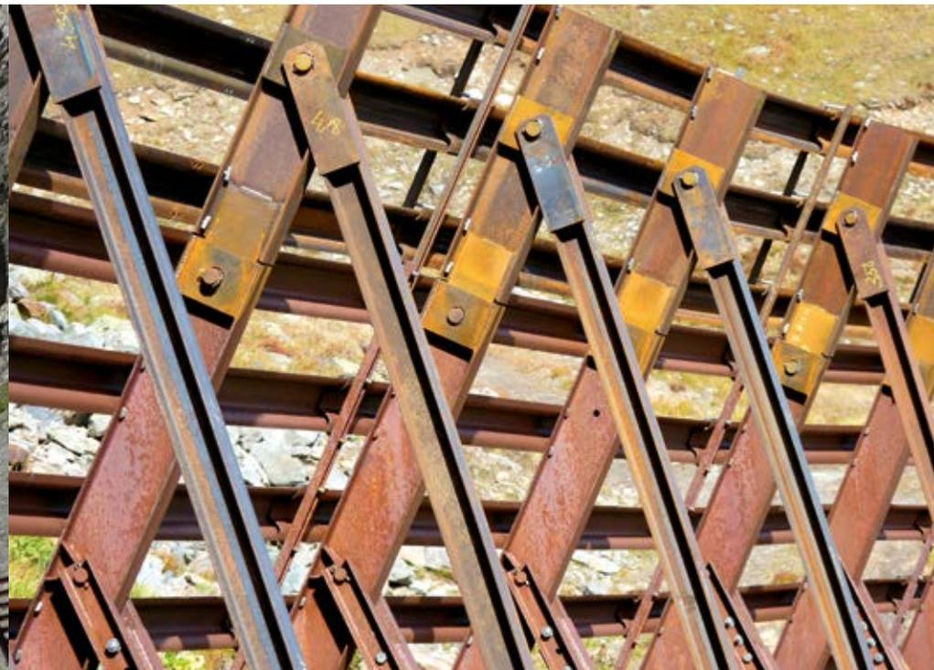
Abb. 9: Fertig montierte Werkserhöhungen der Type „Flexibel“ (Erhöhung 1,10 m)
