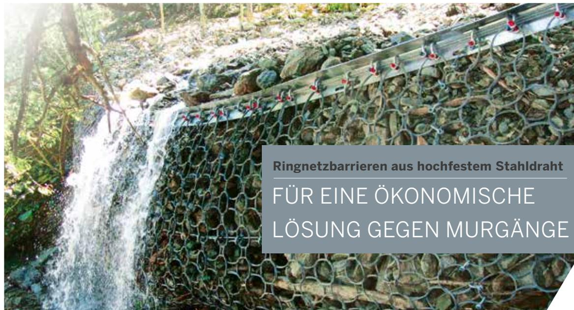
Ringnetzbarrieren aus hochfestem Stahldraht
