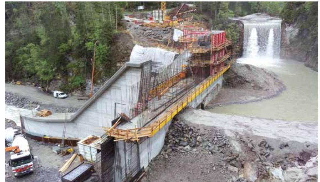
Abb. 3: Im Bau befindliche neue Blauseesperre – Stand Mai 2016 (im Hintergrund ist die alte Steinsperre erkennbar) (Quelle WLV)
