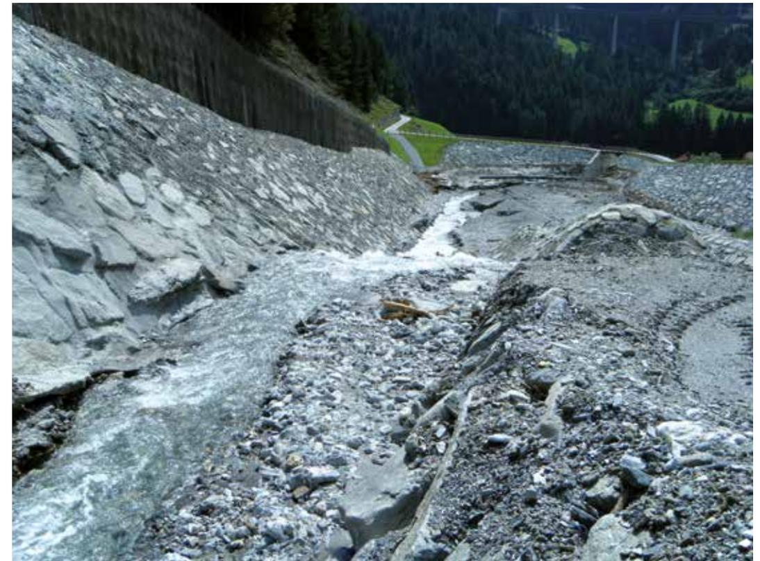
Abb. 1: Geschieberückhaltebecken
