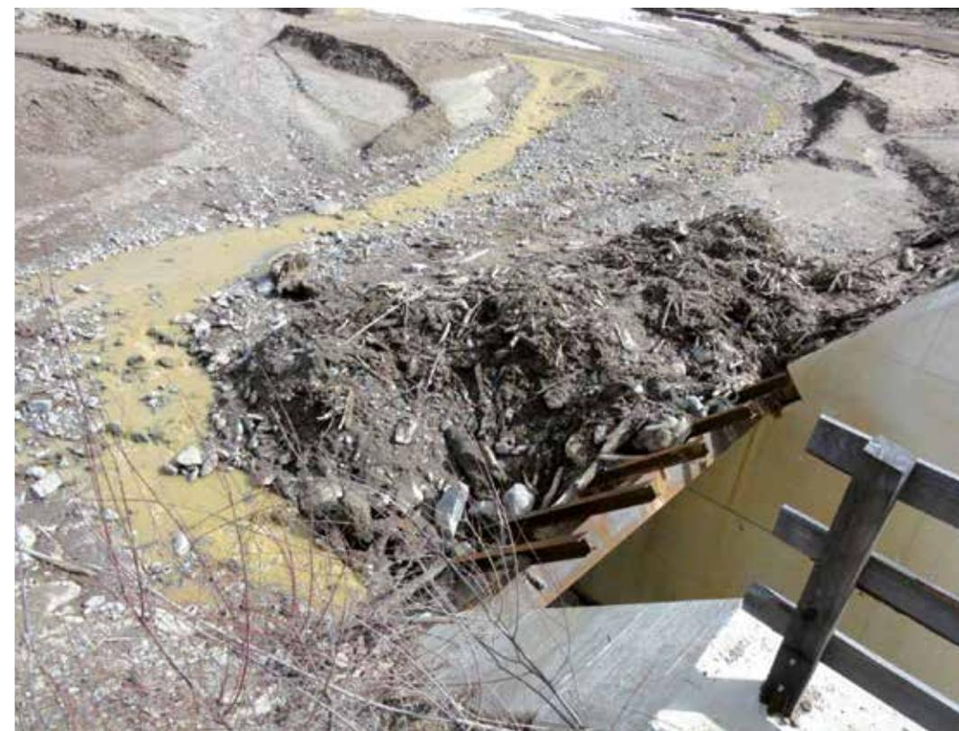
Abb. 2: Murholz im Geschieberückhaltebecken, Bereich Rechen
