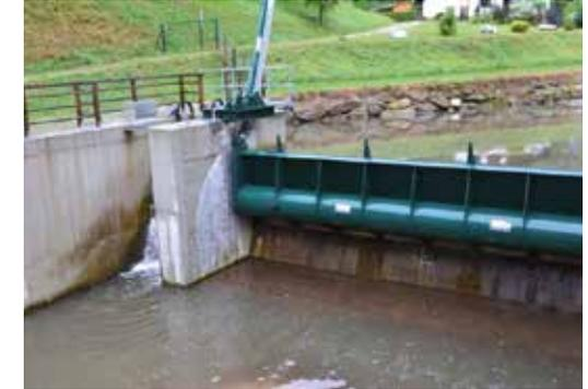
Abb. 4: Beispiel für eine Bachfassung mit Seitenentnahme, KW Sallabach (Fotos: Stadtwerke Köflach)
