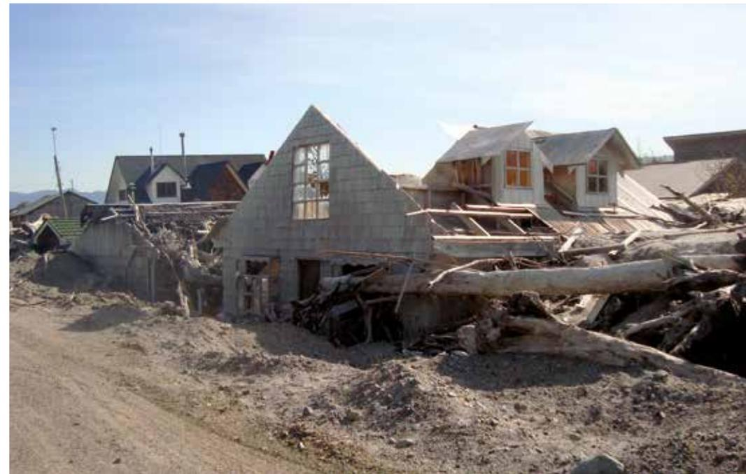
Abb. 3: Durch den Lahar in Chaiten hervorgerufene Schäden (mit Bewilligung von Hector Ulloa).
