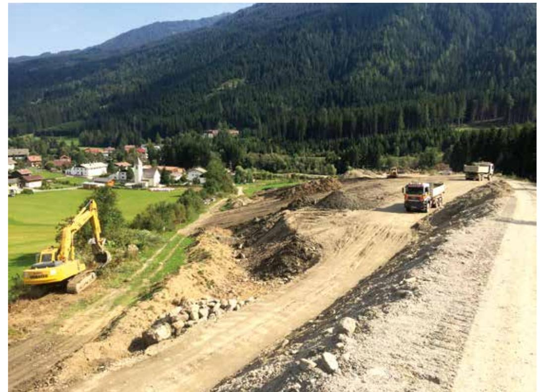
Abb. 6: Bodenaushubdeponie Tödterbach, anschließend an den LKW-fahrbar ausgebauten und erhöhten linken Uferdamm
