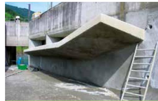
Abb. 5: Beispiel für eine Kragplatte am Einlauf als Geschiebeabweiser und geschiebeaktivierende Initialstruktur für eine Spiralströmung zum Grundablass (Kraftwerk Sölk, Bachfassung Kleinsölk, Foto: Verbund)
