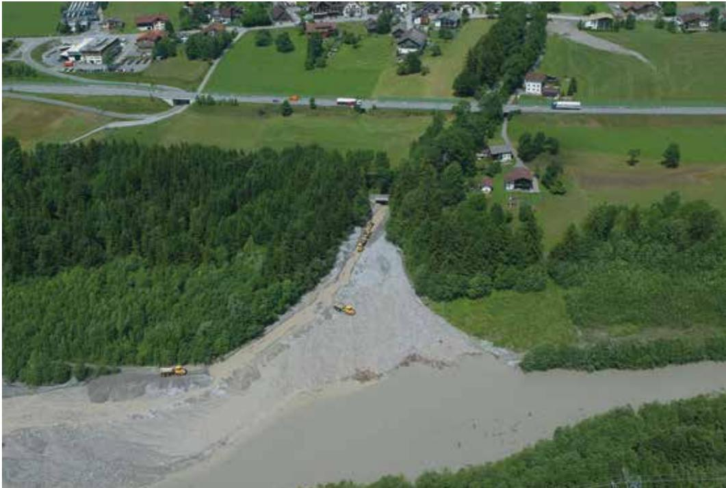
Abb. 3: Ereignis 2003 – Räumung von Becken und Bachbett sowie Einbau entlang der Alfenz (links unten im Bild).
