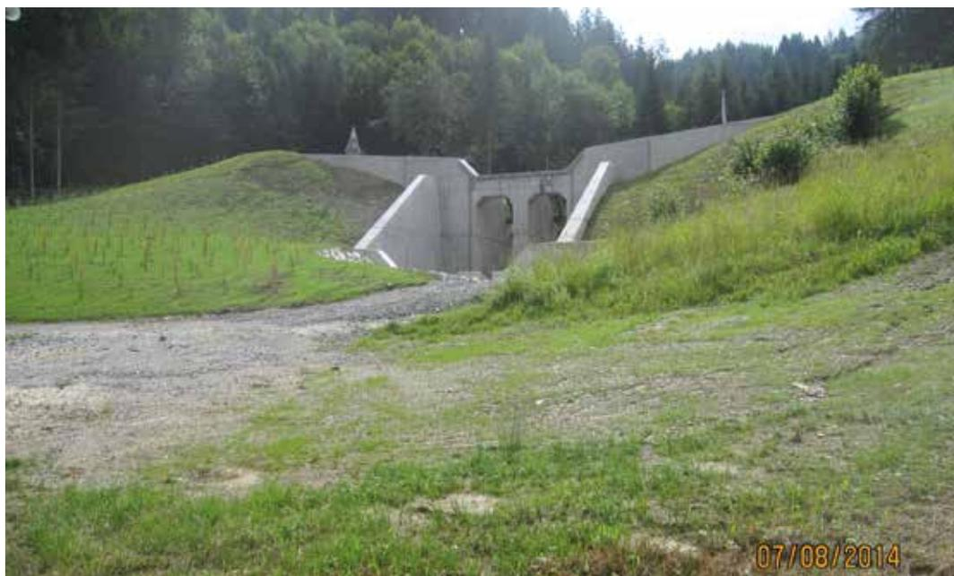
Abb. 4: Filterbauwerk Jaidhausgraben ein Großteil des angefallenen Sediment- und Aushubmaterials konnte zur Einschüttung der Sperrenflügel verwendet werden
