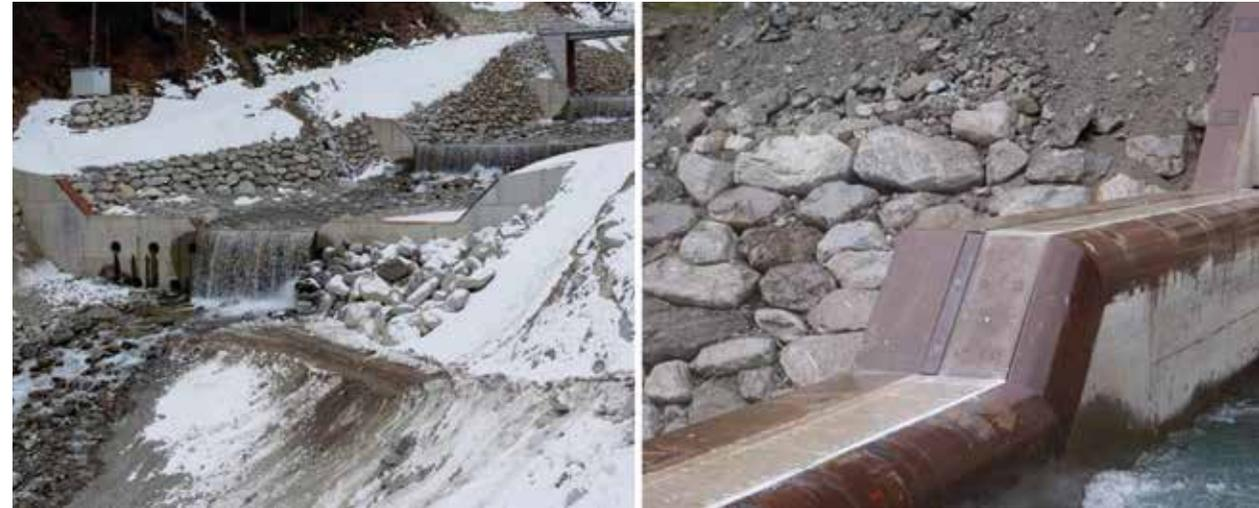
Abb. 2: Übersicht und Detailaufnahme der Geschiebemessanlage am Suggadinbach.
