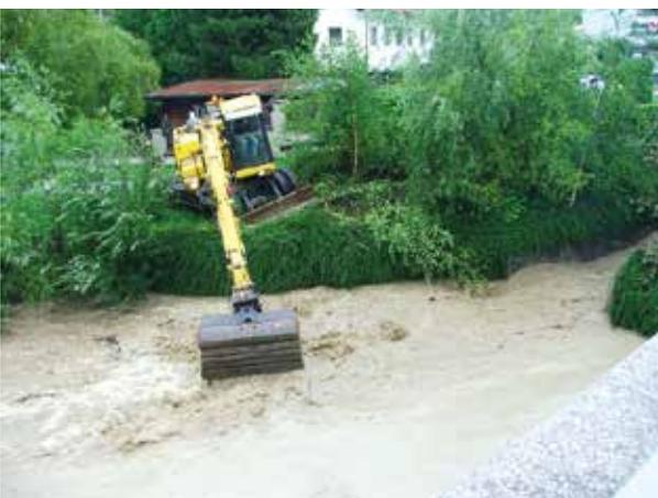
Abb. 4: Mündungsbereich des Lahnbaches in Schwaz beim Innhochwasser 2005: Nur durch intensives Baggern im Mündungsbereich konnte der Rückstau von Geschiebe im Gerinne verhindert werden.
