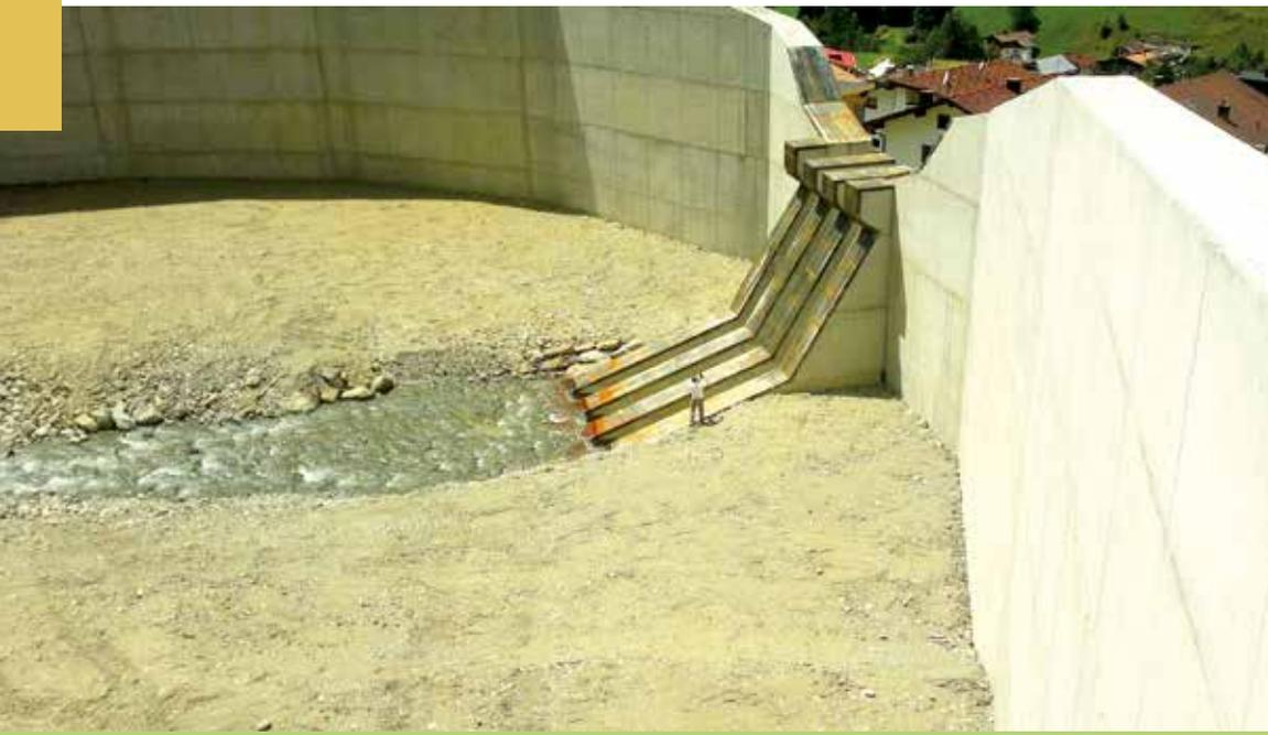
Abb. 2: Nur ein Jahr nach der verheerenden Murenkatastrophe am Schallerbach in der Paznauner Gemeinde See ist das Herzstück der neuen Verbauung – ein erweitertes Geschiebebecken mit einem Fassungsvermögen von 45.000 m<sup>3</sup> – fertig.
