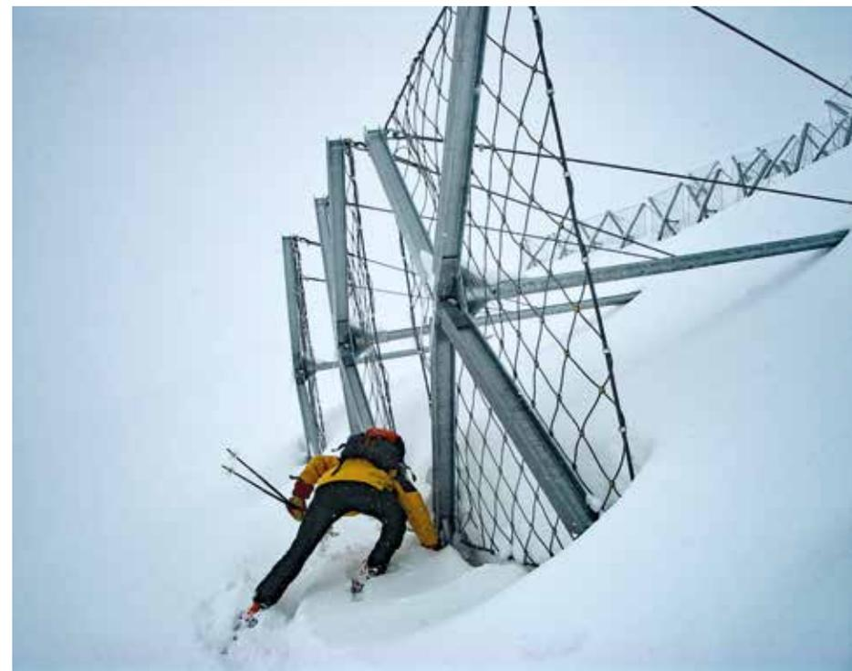
Abb. 4: Stützwerk, das an einem Anker aufgehängt ist.
