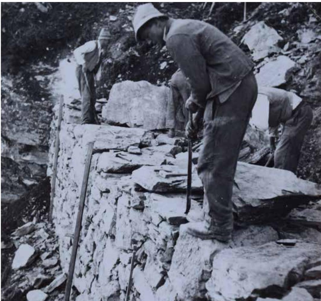
Abb. 1: Arbeiter bei der Errichtung einer Steinterrasse im Jahr 1954 (Quelle: WLV)
