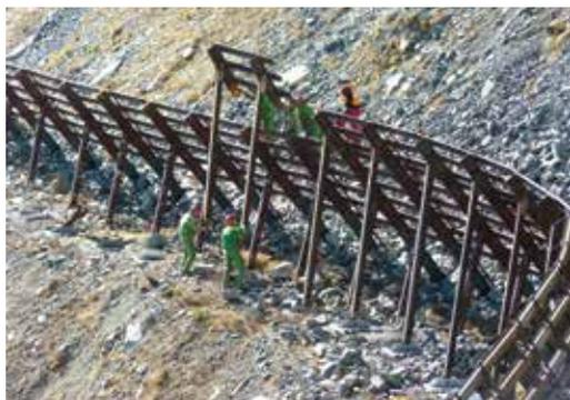
oder wenn großflächig überschneite Anbruchverbauungen sichtbar wurden. Das Beispiel der Großstal-Lawine aus dem Jahr 1982 zeigt, dass die Stahlschneebrücken großflächig überschneit waren (Abbildung 4). Als Reaktion darauf, wurden die bestehenden Anbruchverbauung erhöht (Drexel, 2010).
