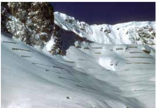
Abb. 4: Im Jahr 1982 wurde die bestehende Anbruchverbauung der Großstal-Lawine großflächig überschneit. Im Zuge eines Ergänzungsprojektes wurden die Stahlschneebrücken erhöht.
