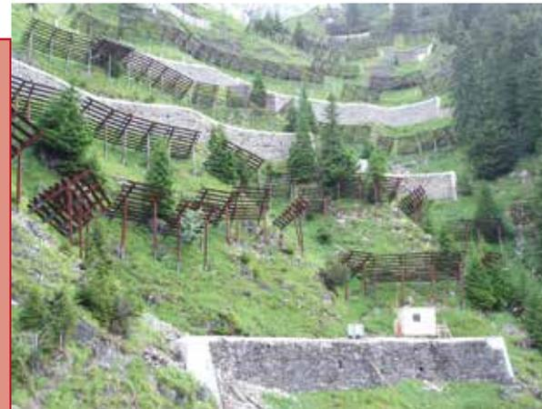
Abb. 1: Trockenstein Lawinenausmauern teilweise saniert und ergänzt mit Schneebrücken
