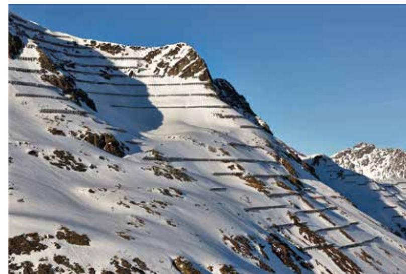
Abb 4: Stützverbauung im Anbruchgebiet der Wasserleiterlawine in Galtür
