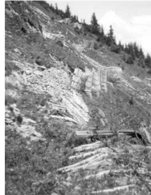
Abb. 5: Zerstörter Arlbergrechen im Anbruchgebiet der
