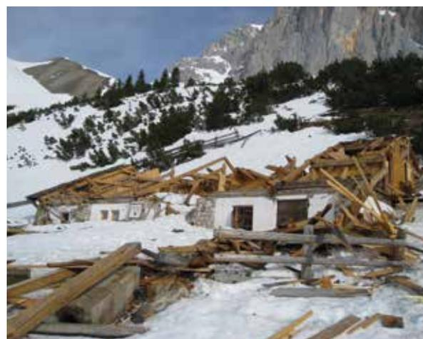
Abb. 7: Beispiele für Lawinenschäden an Gebäuden.
