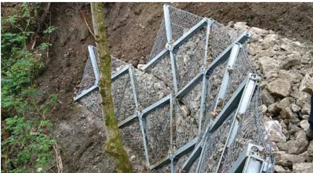
Abb. 1: Farfalla Böschungssicherung bei Wegbau in schwierigem Gelände
