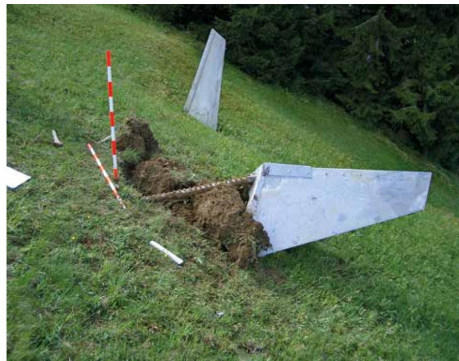
Abb. 5: Beschädigter Snowgripper in der SLF-Versuchsbauung.
