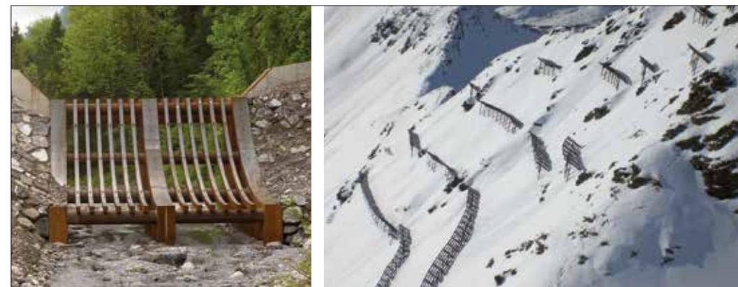
Stahlschneebrücken • Gleitschneeböcke • Triebsschneewände
