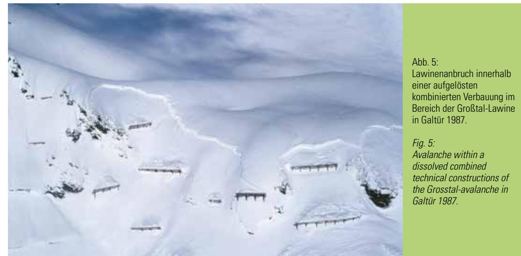
Abb. 5: Lawinenanbruch innerhalb einer aufgelösten kombinierten Verbauung im Bereich der Großstal-Lawine in Galtür 1987.
