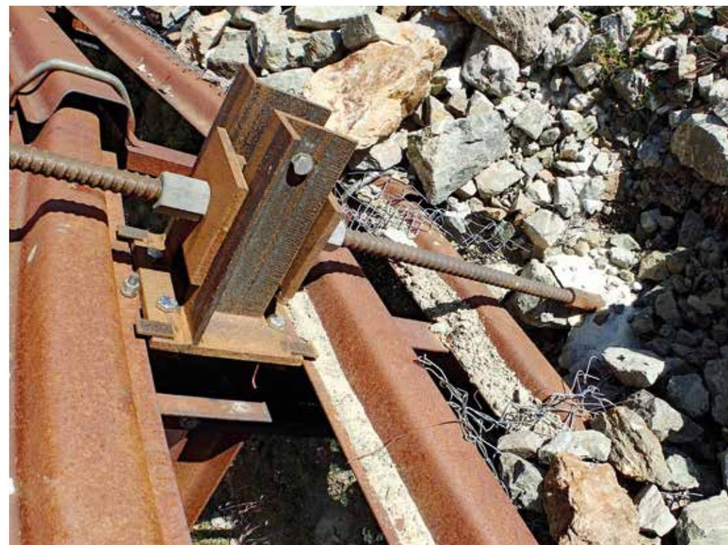
Abb. 9: 40-jähriges Riegelwerk, dessen oberer Anker mit einem Zusatzanker verstärkt wurde, der wegen der einfachen Montage über dem Stützrost versetzt wurde. Problematisch ist, dass der Anker Schneedruck und Steinschlag ausgesetzt ist. Neukonstruktionen sollten auf einen einfachen Unterhalt optimiert werden.
