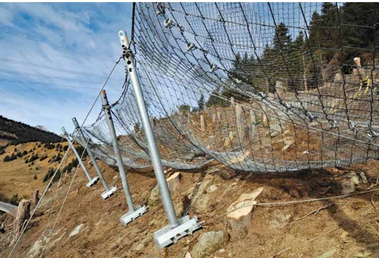
Abb. 3: Schneenet des Typs „SPIDER-Avalanche“; die Stütze ist auf einer Grundplatte fundiert.
