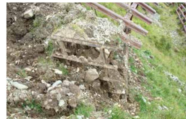
Abb. 6a: Historische Stahlschneebrücken der Großstal-Lawine in Galtür mit den sogenannten Zugplatten als Fundierung. Abb. 6b: Versagen der Zugplatten infolge von Erosionen am Predigtberg in Galtür.
