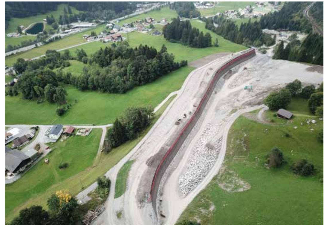
Abb. 6: Baustelle des Auffangdammes der Spreubachlawine im Sommer 2019. (Quelle: DI Jürgen Gruber, Tencate Geosynthetics)
