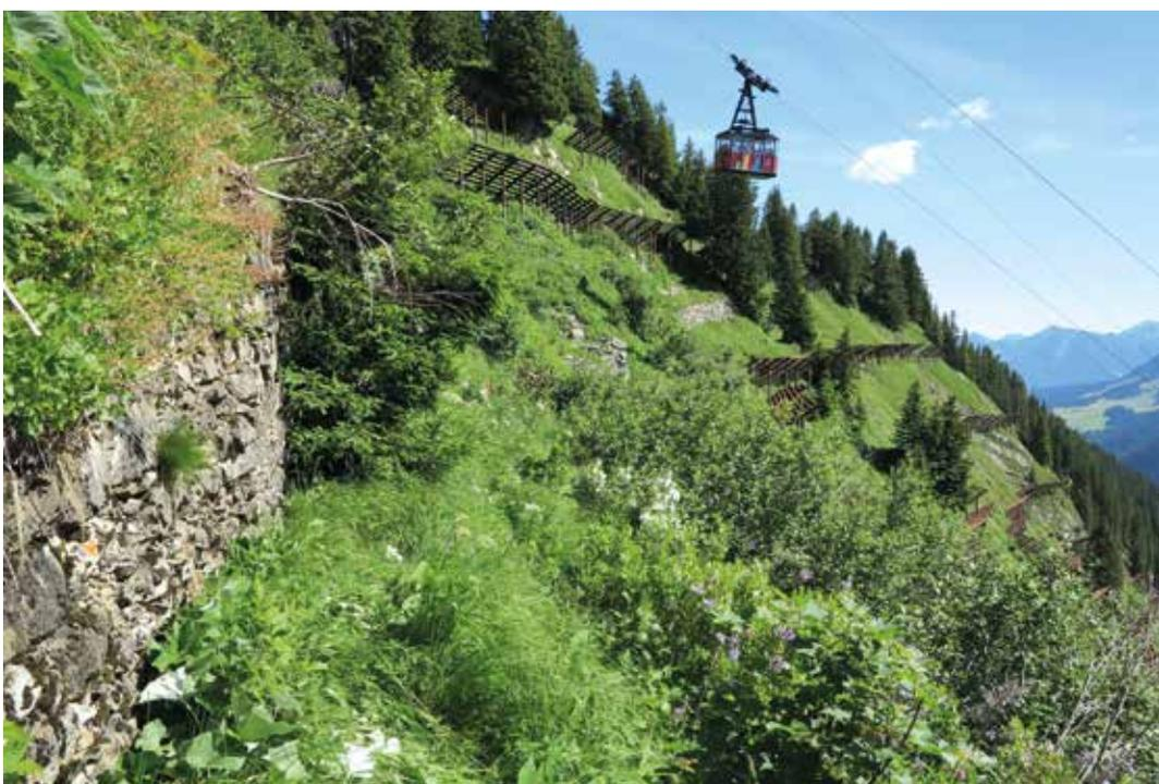
Abb. 2: Älteste historische Lawinenschutzmauern nahe der Walmendinger Horn-Bahn (IBLB BOKU Wien 2018).
