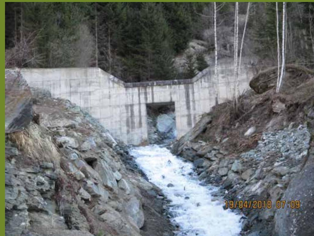
Abb. 3: Beispiel einer unbehandelten Geschiebesperre einige Jahre nach Errichtung
