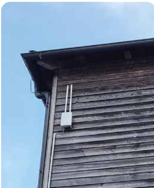
Abbildung 4: LoRaWAN-Gateway montiert am Feuerwehrhaus Weißenbach bei Bad Goisern
