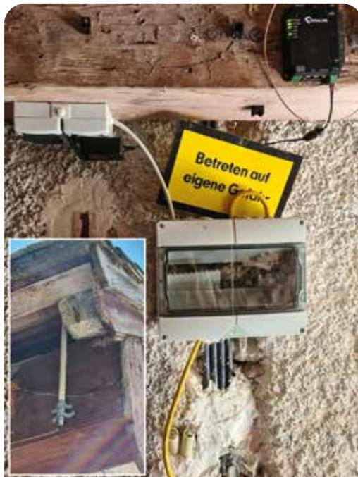
Abbildung 5: LoRaWAN Solar-Gateway montiert am Klausengebäude, mit externer Antenne am Dach, angeschlossen an die bestehende Solaranlage vor dem Klausengebäude
