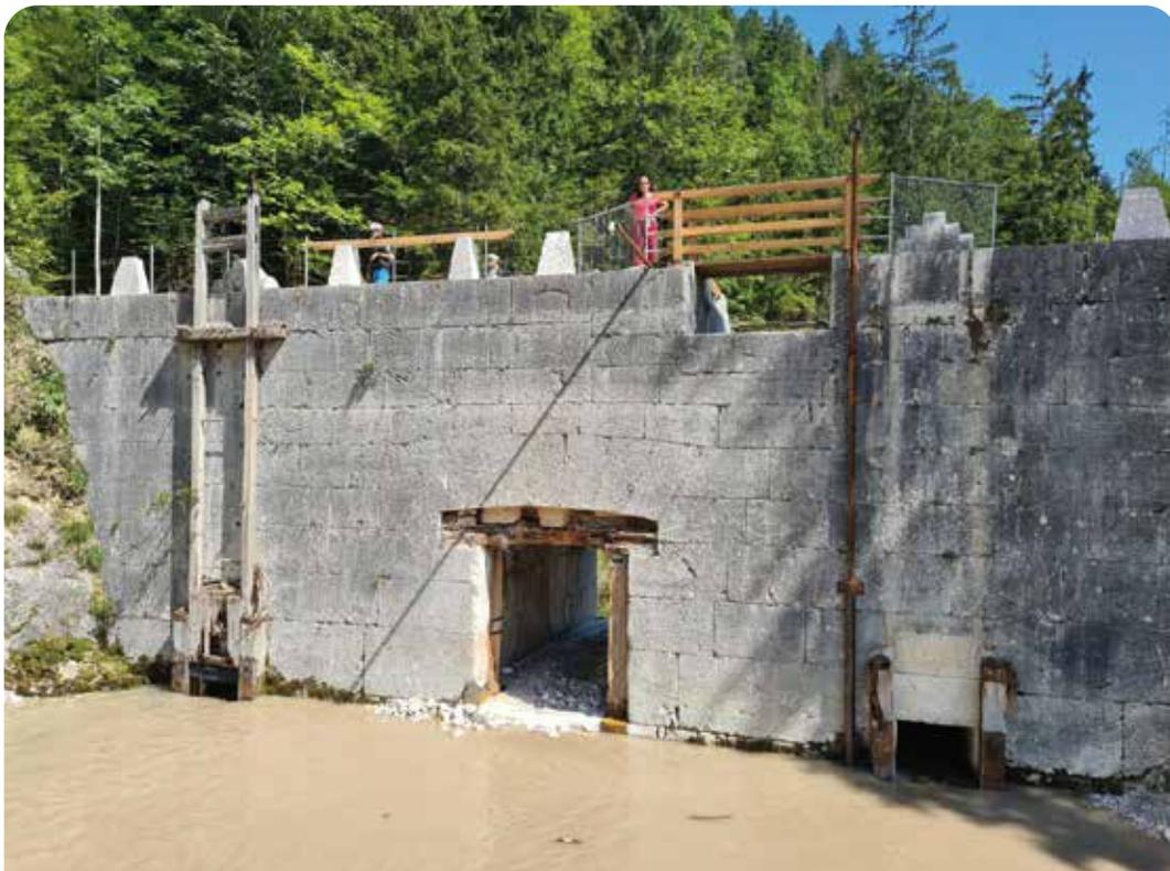
Abbildung 10: Ansicht der Chorinskyklause mit den Messeinrichtungen
