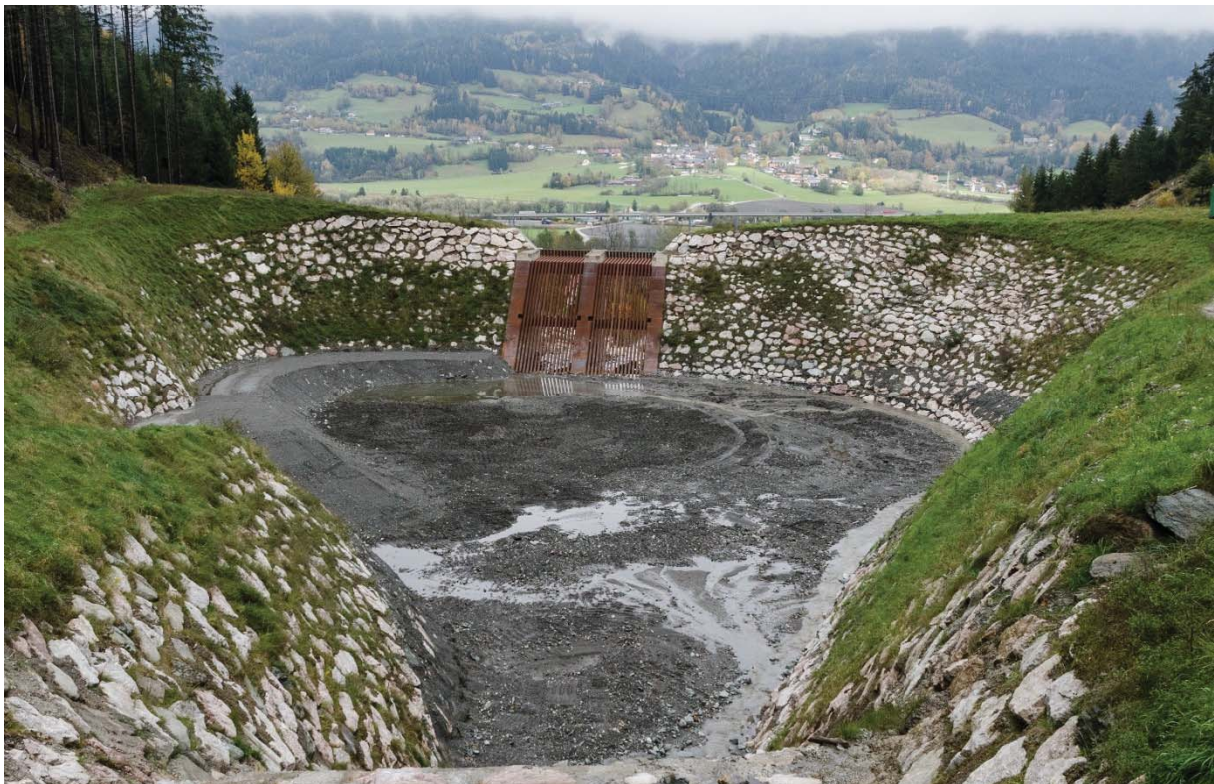
Fertiggestelltes Geschieberückhaltebecken im Schwarzenbach; Foto: Holzinger
