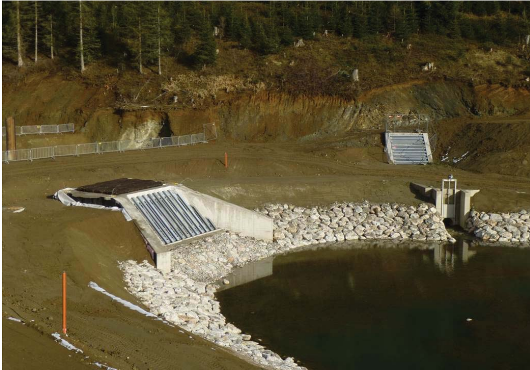
Bauphase 2015, Einlaufbauwerk Grundablass, Bypasseinlauf; Foto © WLV Stmk.-Nord
