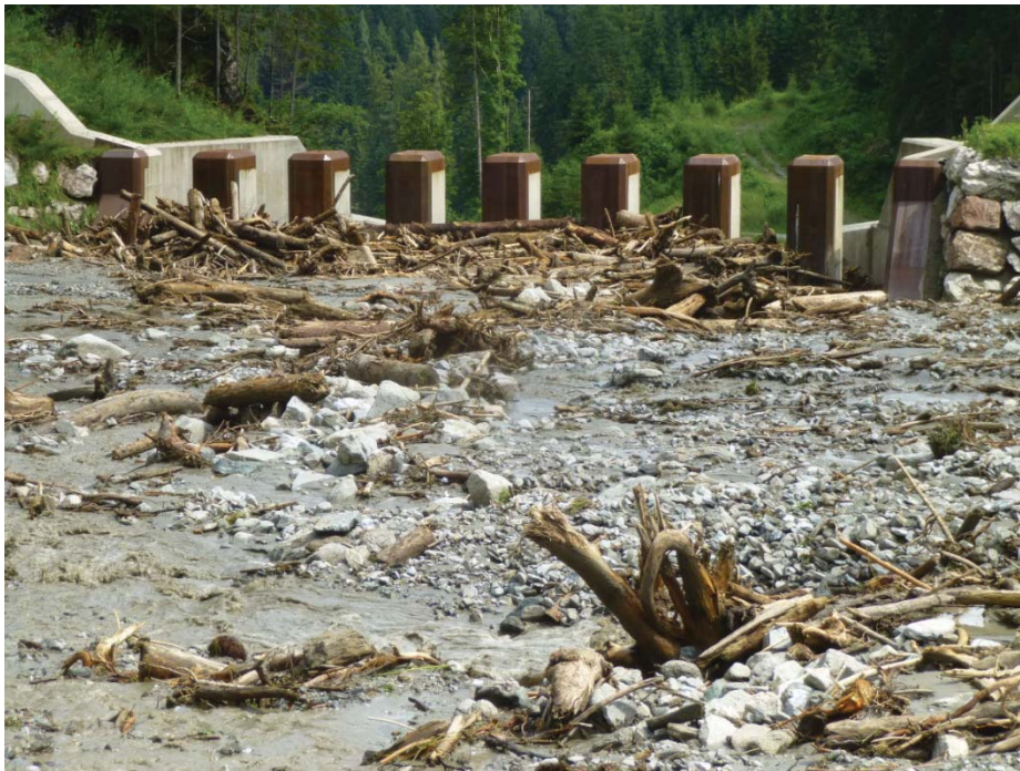
Grobfilterbauwerk im Sommer 2016; Foto: WLV Stk.-Nord
