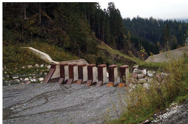
Murbrecher am Lorenzbach im 3-d-Modell und nach Fertigstellung; Fotos: WLV, Pürstinger
