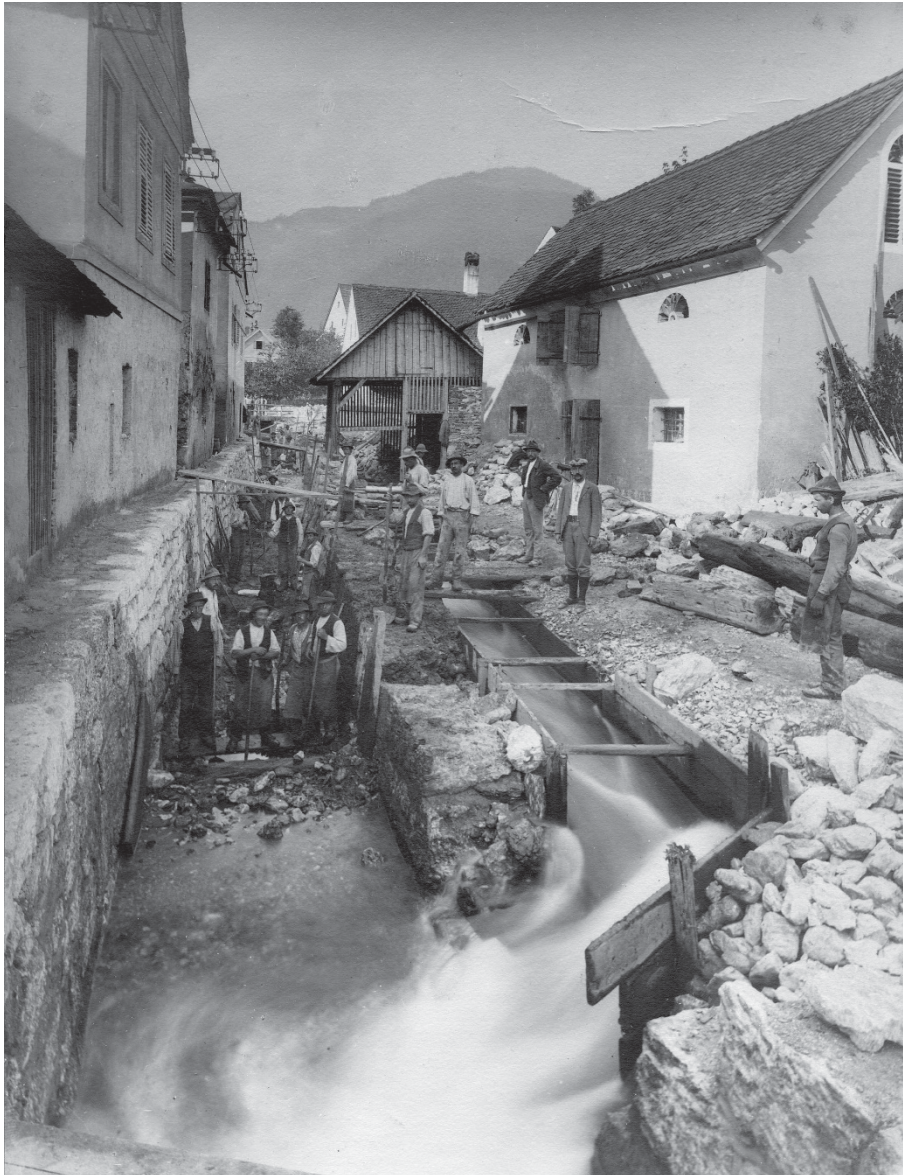
Unterlaufregulierung, Foto © WLV; Gebietsbauleitung Steiermark Nord
