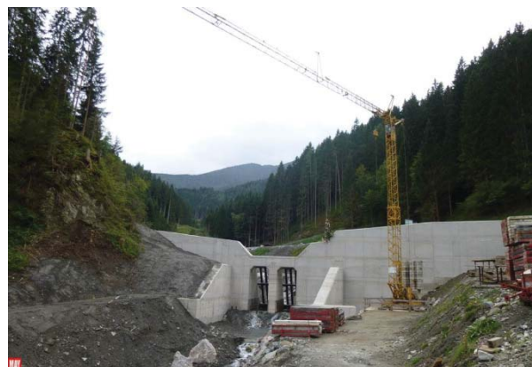
Geschieberückhaltebecken am Lorenzerbach; Fotos: WLV Stmk.-Nord; Mayerl
