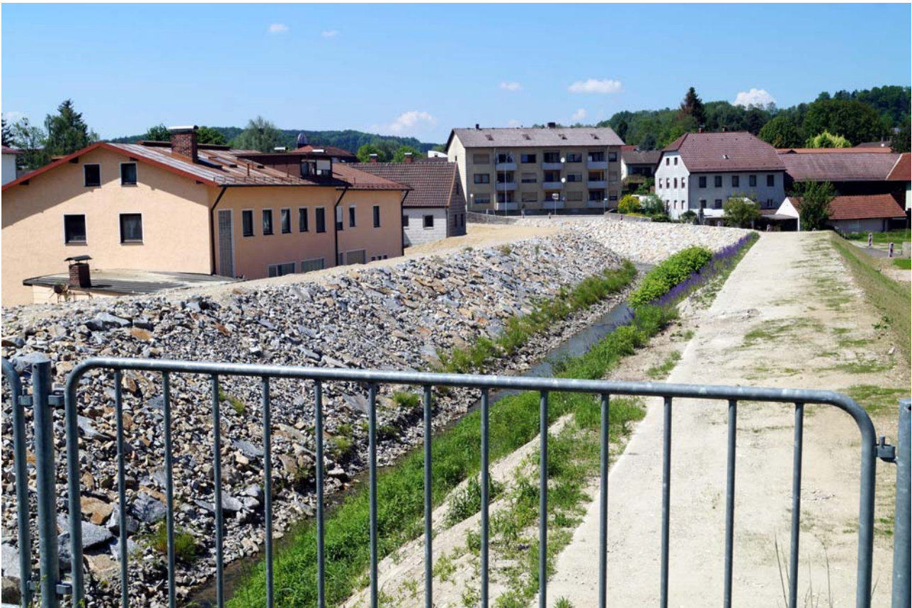
Abbildung 24: Im Zuge der Sofortmaßnahmen sanierter Deich bei der Wilhelm-Dieß-Straße. Die links im Hintergrund sichtbaren Gebäude wurden bereits abgelöst und sollen abgerissen werden (Foto: Pürstinger)
