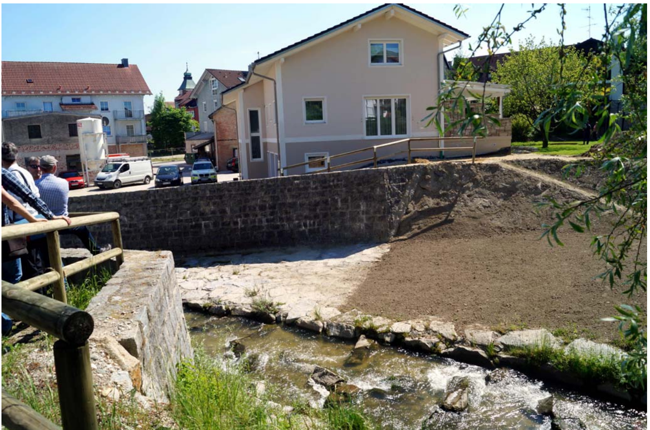
Abbildung 29: Situation beim Einlaufbereich am oberen Ende der Ortskүнette (Foto: Pürstinger)
