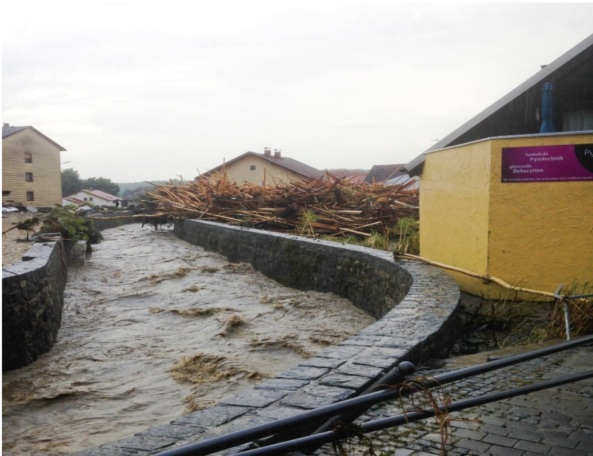
Abbildung 21: Enorme Unholzablagerungen außerhalb des Simbaches im Siedlungsbereich (Foto: Gemeinde Simbach)
