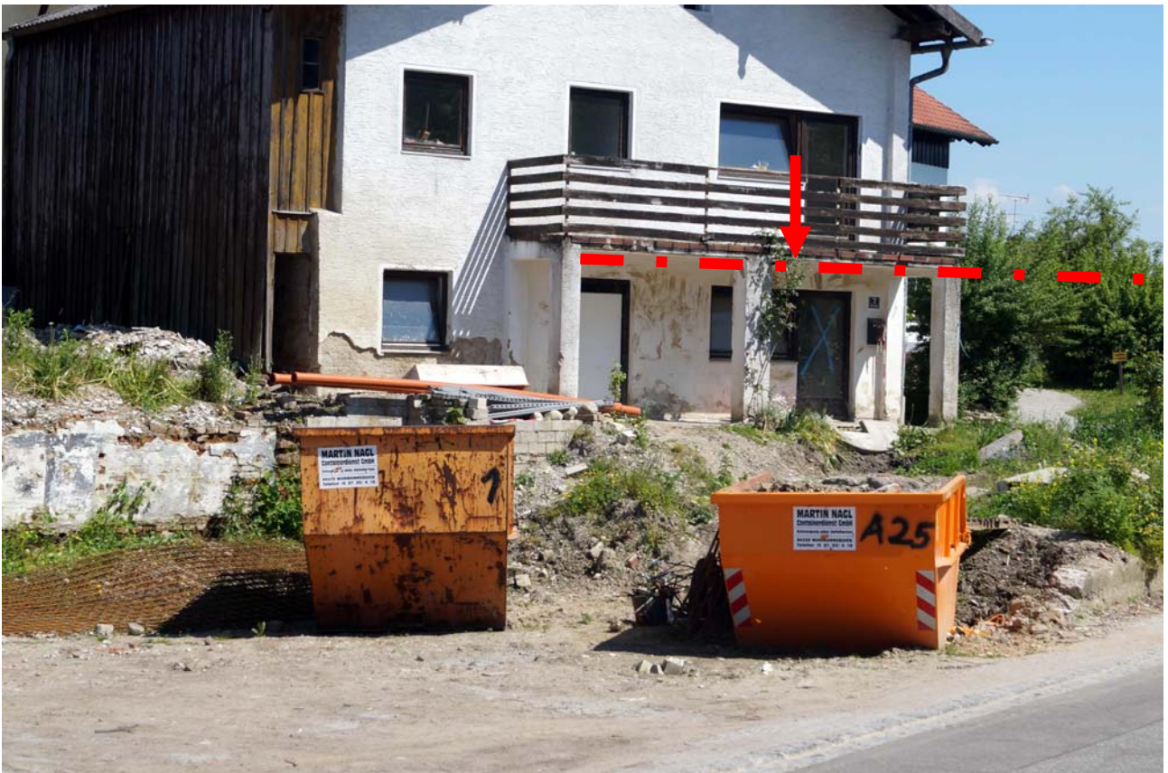
Abbildung 27: An einigen Gebäuden sind heute noch die Anschlaglinien vom Juni 2016 zu erkennen (Foto: Pürstinger)
