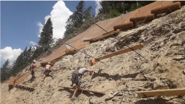
**Abbildung 30:** Rutschung Promeggen, Felsabtrag und Felsvernetzung sowie Fundierung der Lawinenwerke, Stand 06/2019 (Quelle: WLVB, GBL Kärnten Süd)
