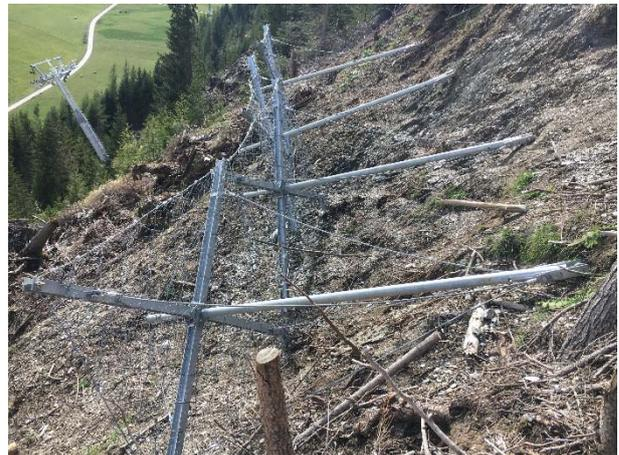
**Abbildung 41:** Gleitschneeschutzschirm „Erdox® Neve“ – große Ausführung mit 11 m² Stützfläche
