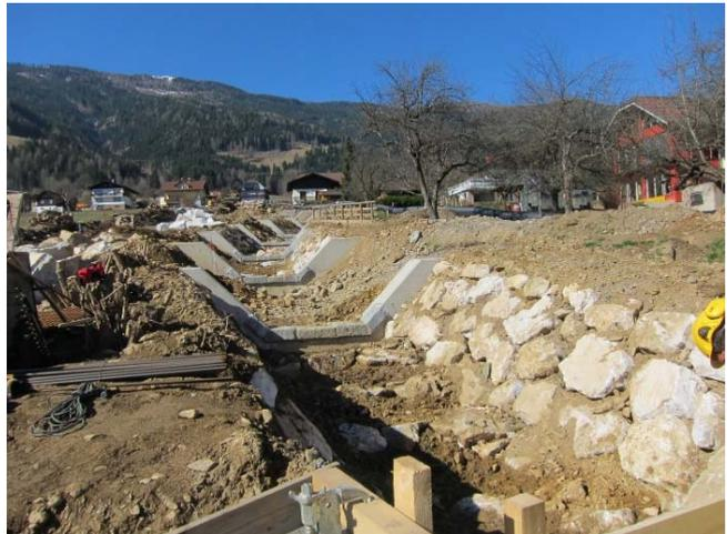
**Abbildung 59 und 60:** Die 87 Sohlgurten der Schwemmkegelverbauung im Bau (Quelle: WLV, GBL Kärnten Nordost)
