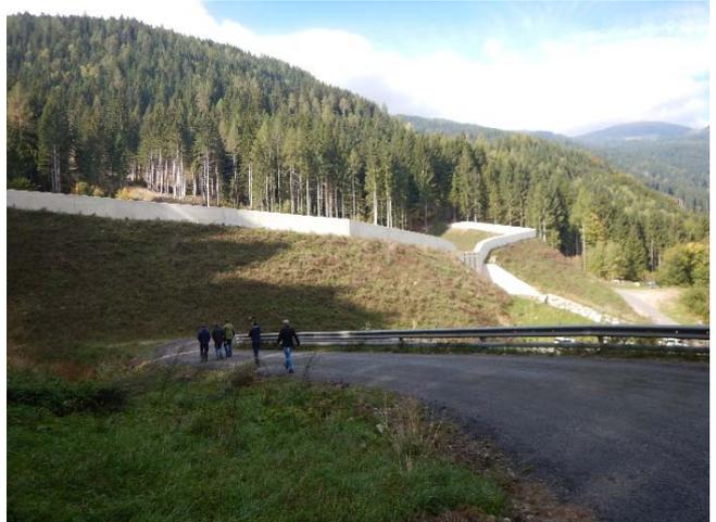
**Abbildung 53 und 54:** Verlandungsraum der Geschiebedosiensperre bei hm 10,81 (links) und Ansicht von der Luftseite (rechtes Bild)
