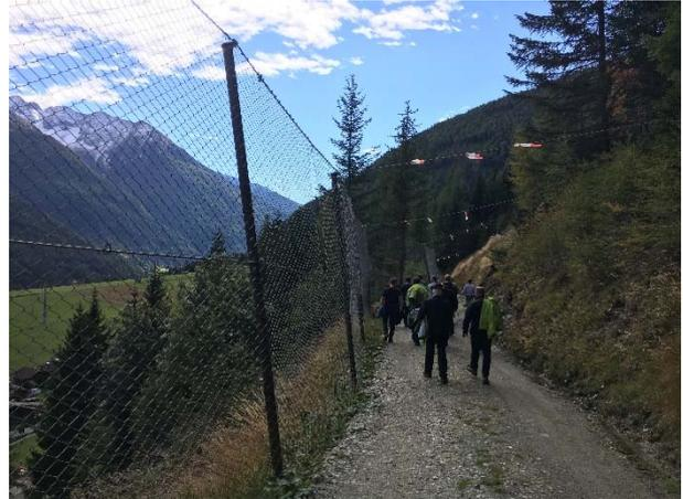
**Abbildung 39:** Provisorisches Steinschlagschutznetz oberhalb Großdorf (1.335 m) zum Schutz während der Schadholzbringung und Errichtung der forsttechnischen Maßnahmen
