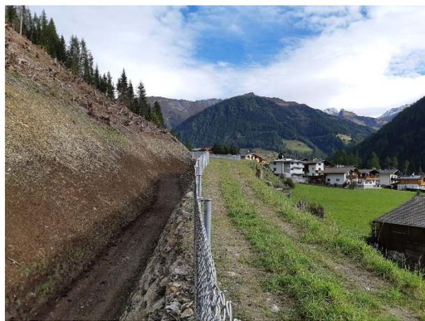
**Abbildung 37:** Steinschlagschutzdamm mit 150 KJ-Steinschlagschutzzaun als Absturzsicherung
