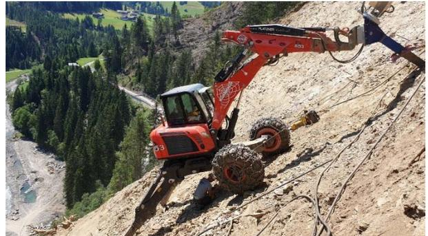
**Abbildung 31:** Rutschung Promeggen, Felsabtrag und Felsvernetzung sowie Fundierung der Lawinenwerke, Stand 06/2019 (Quelle: WLVB, GBL Kärnten Süd)
