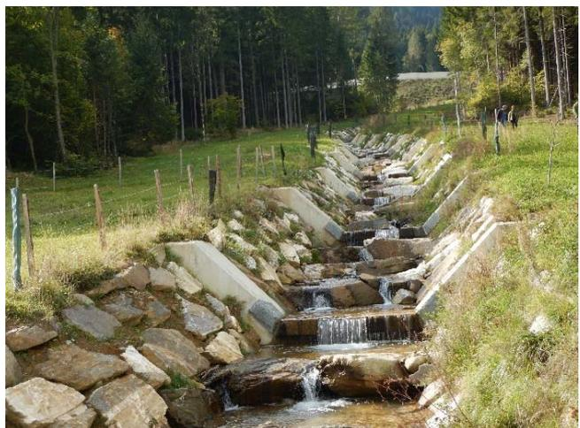
**Abbildung 61 und 62:** Fertige Unterlaufverbauung, bestehend aus 87 Sohlgurten in Stahlbetonbauweise sowie einer rau verlegten Sohl- und Ufersicherung mittels GSS. Hier wurde auch Wert auf eine Strukturierung des Bachlaufes gelegt.
