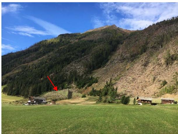
**Abbildung 36:** Spaltkeilförmiger Lawinenablenkdamm mit oberhalb anschließender Windwurffläche
