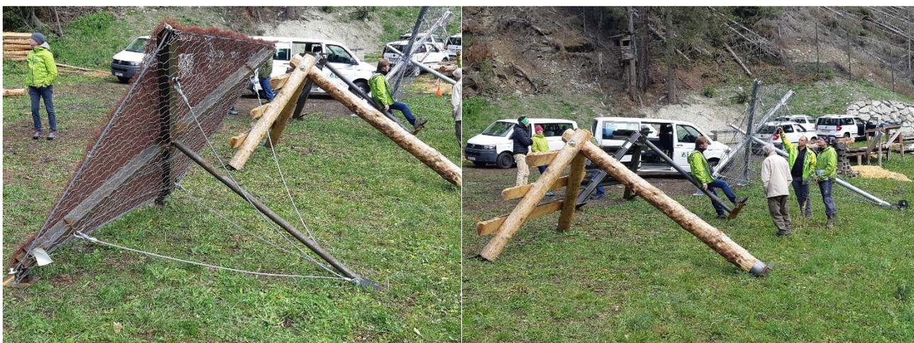
Abbildung 35: Gleitschneeschtzbautypen v.l.n.r.: Erdox Neve – 5 m<sup>2</sup>, Holzbock, Stahlbock, Erdox Neve – 11 m<sup>2</sup>
