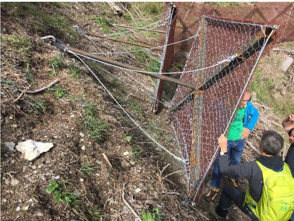
**Abbildung 40:** Gleitschneeschutzschirm „Erdox® Neve“ – kleine Ausführung mit 5 m² Stützfläche
