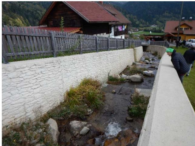
**Abbildung 63 und 64:** Unterlaufkünette im dicht besiedelten Gebiet während dem Bau (Quelle: WLW, GBL Kärnten Nordost) und nach Fertigstellung und Rekultivierung.
