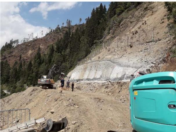
**Abbildung 32:** Rutschung Promeggen, Wiedererrichtung B111 mittels Geländeabtrag und Spritzbetonsicherung, Stand 09/2019 (Quelle: WLVB, GBL Kärnten Süd)
