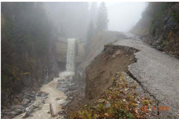
**Abbildung 22:** Eggenbach – Grenzbach Kärnten-Osttirol, Vorfelderrosion bei der Geschieberückhaltesperre
