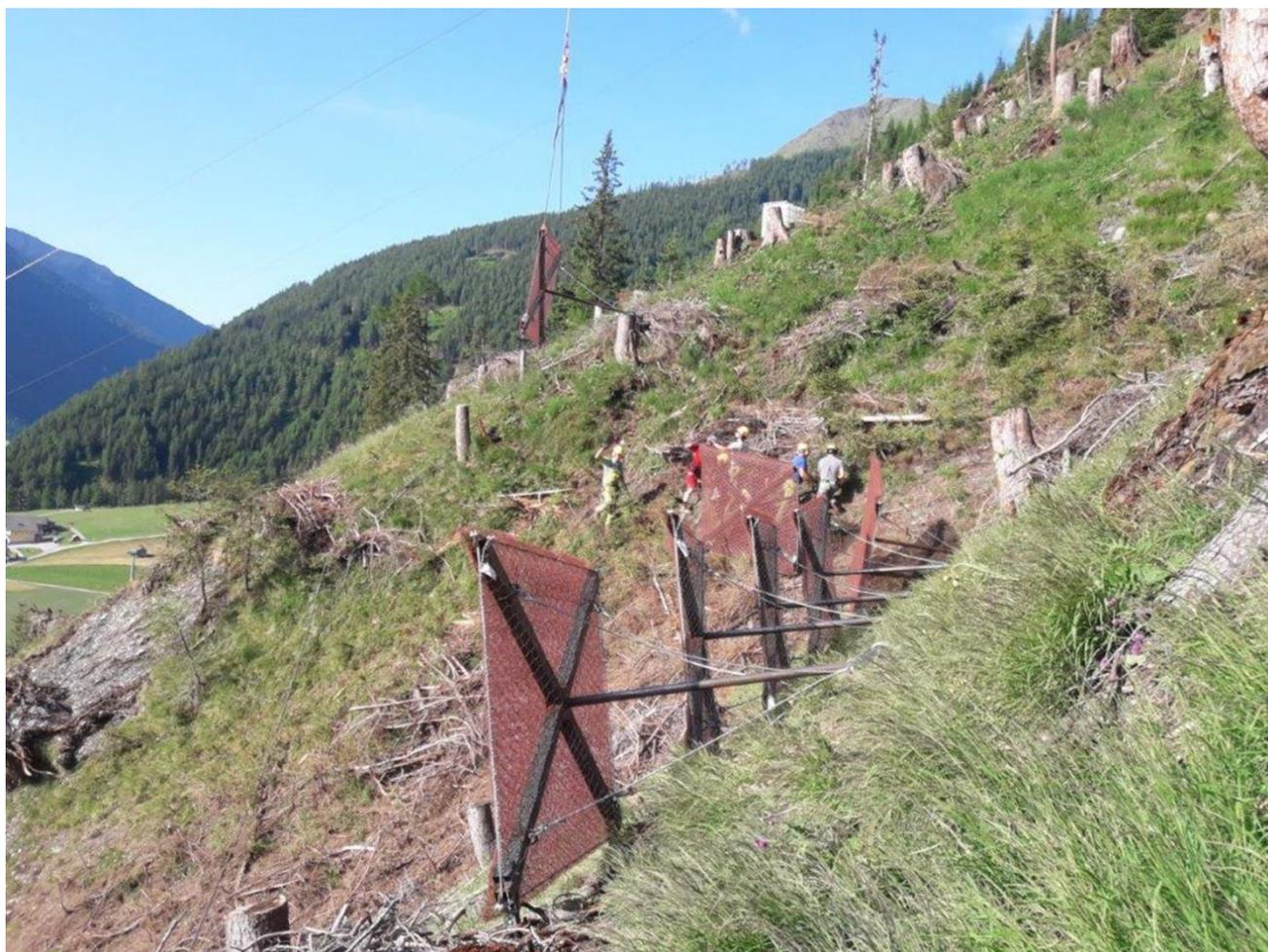
**Abbildung 21:** Sicherung mittels Farfalla L-Systemen (© WLIV, GBL Osttirol)
