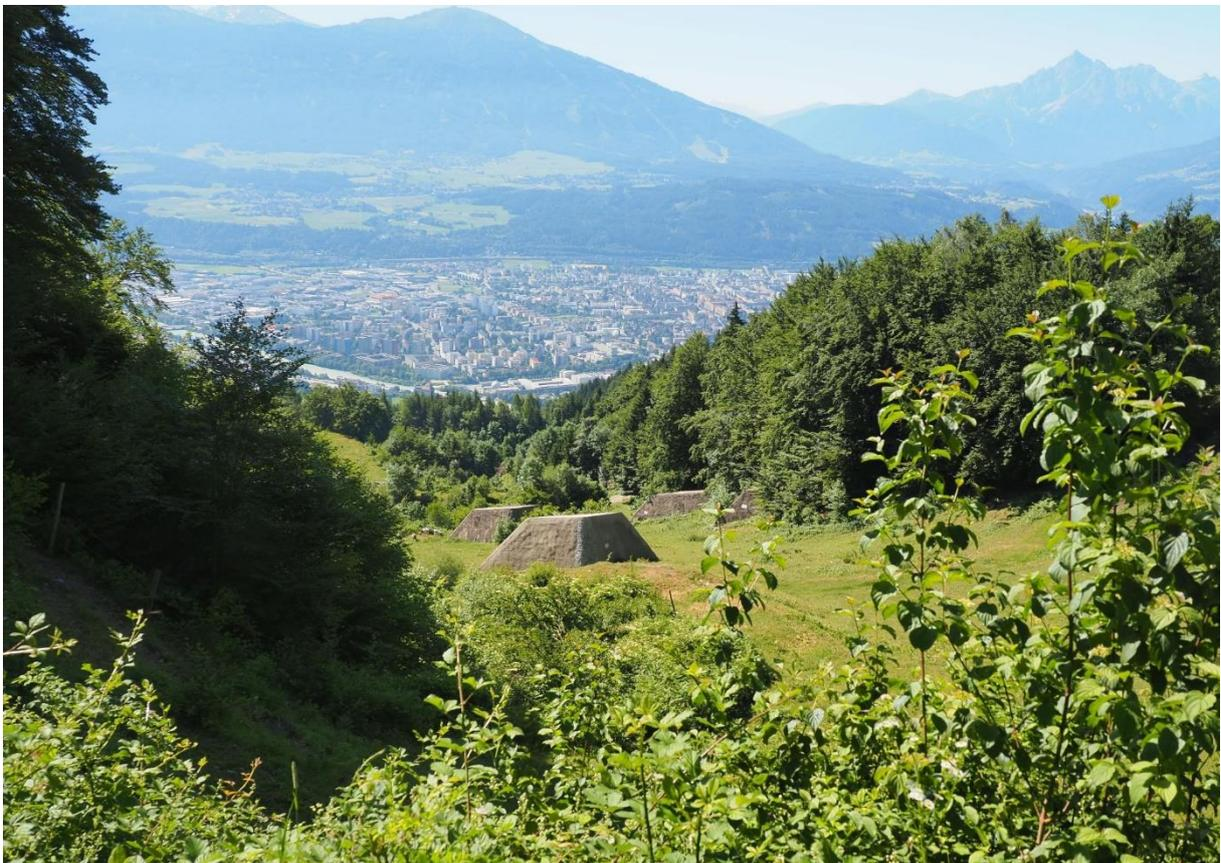
**Abbildung 35:** Arzleralm Lawine - Bremshöcker in Sturzbahn mit Innsbruck im Hintergrund. (Foto: Ribitsch 2023)
