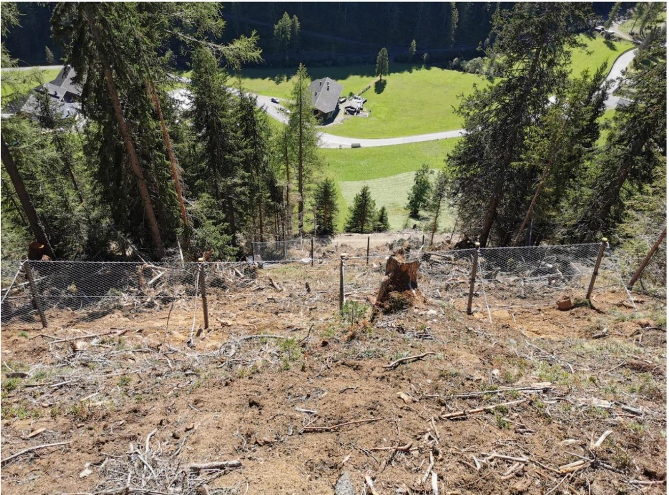
**Abbildung 20:** Temporäre Steinschlagschutznetze (© WLV, GBL Osttirol)
