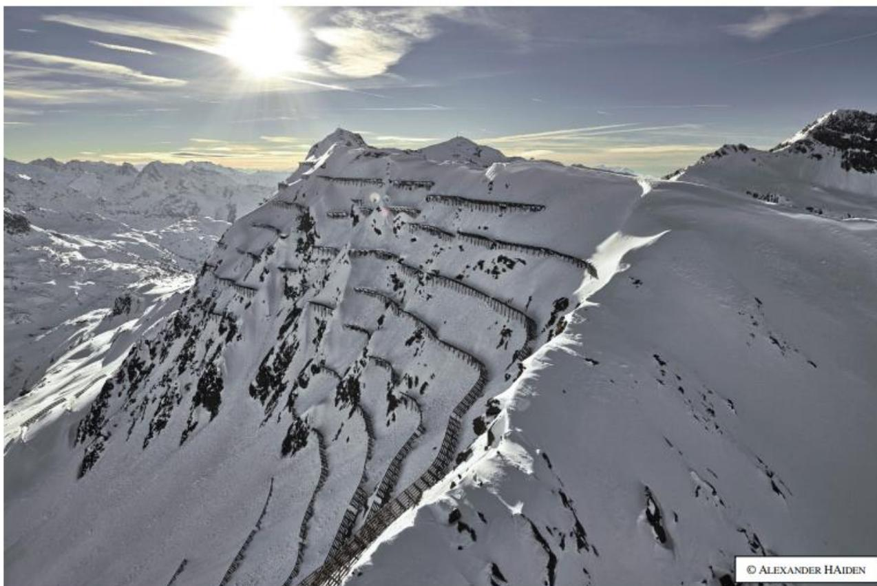
Abbildung 7: Praxisempfehlung Stahlschneebrücken der WLV, Sektion Tirol
