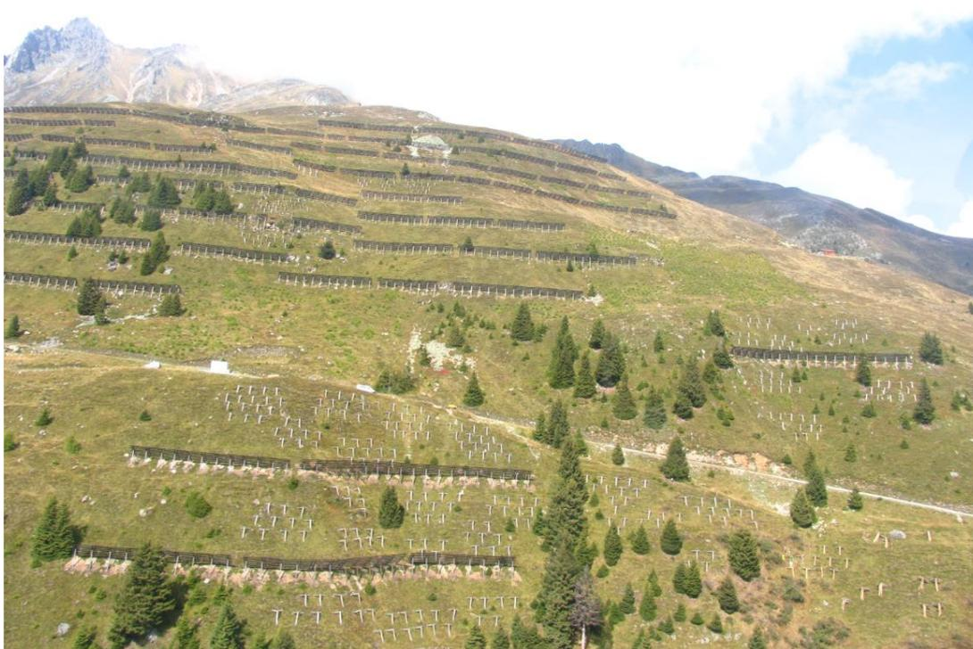
**Abbildung 24:** Technischer und forstlicher Lawinenschutz im Bereich der Judtal- und Wolfstallawine (Foto: Ribitsch, 2023)
