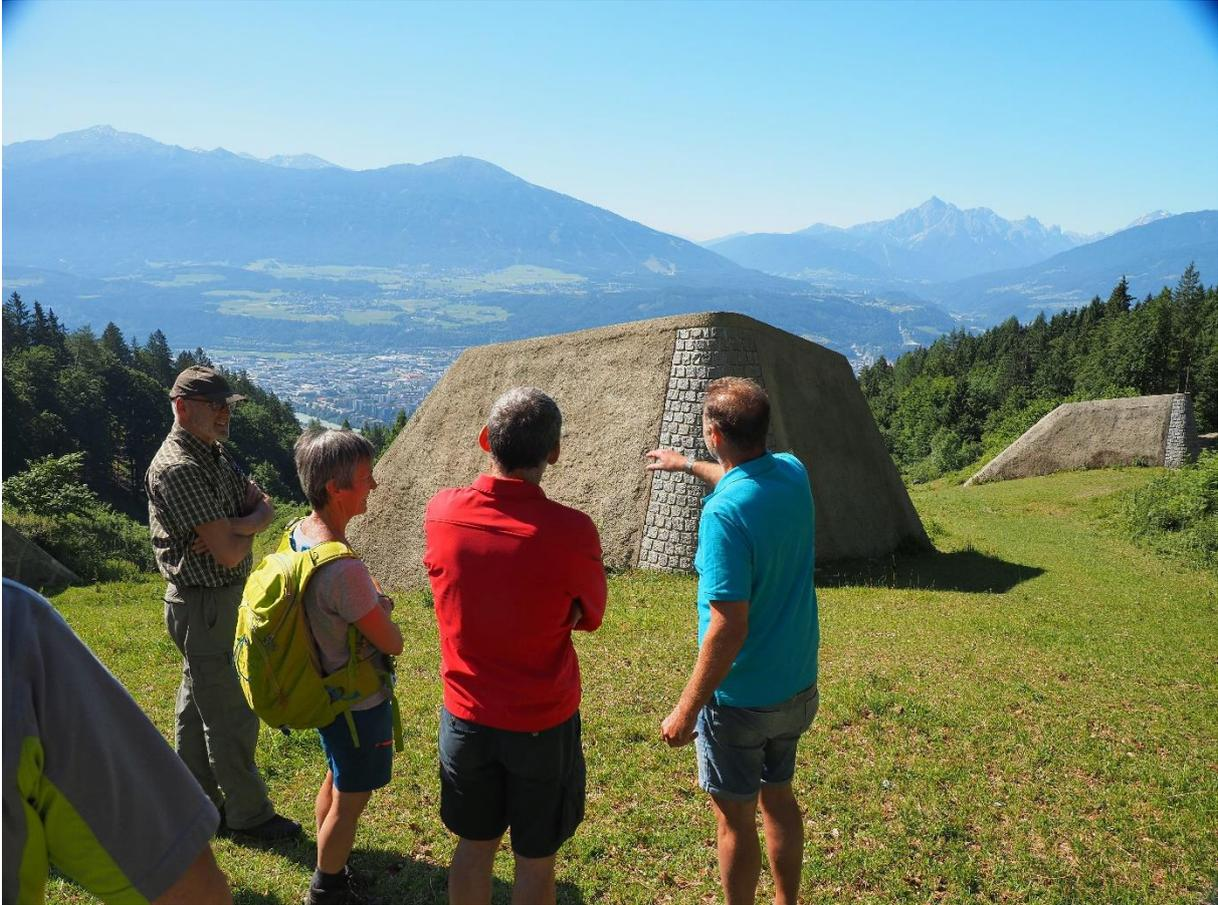
**Abbildung 36:** Mit Bewehrungsmatte und Spritzbeton werden die Prallmauern der Bremshöcker in der Sturzbahn der Arzleralm Lawine saniert. (Foto: Ribitsch 2023)
