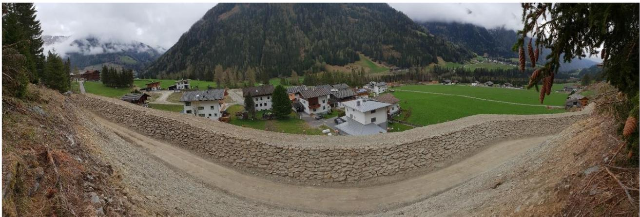
Abbildung 17: Beispiel für die Errichtung eines Steinschlagschutzdammes (© WLIV, GBL Osttirol)
