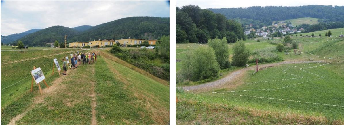
Abbildung 4: Linkes Bild: Erdschüttdamm mit einer Gesamtlänge von 140 lfm und einer Höhe von 12,4 m. Rechtes Bild: Rückhalteraum mit einem Speichervolumen von 155.000 m<sup>3</sup>. Das Becken wird auch als Erholungsgebiet genutzt. Zum Zeitpunkt der Exkursion diente es als Veranstaltungsort der Mountainbike-Weltmeisterschaft. (Fotos: Ribitsch)
