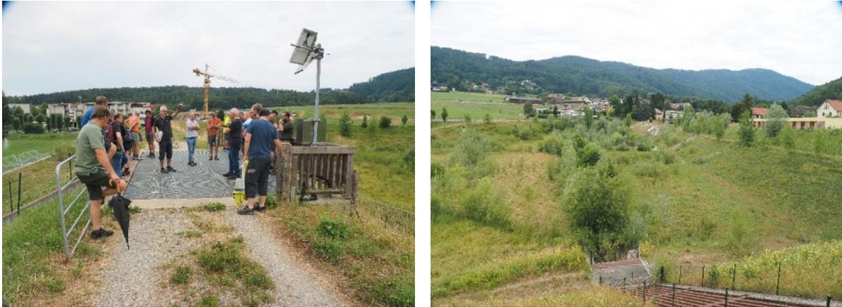
Abbildung 5: Linkes Bild: Erdschüttung mit Hochwasserentlastungsanlage, Gesamtlänge 110 lfm, maximale Höhe 13,3 m. Rechtes Bild Naturnahe Beckenausgestaltung mit einem Speichervolumen von 116.000 m<sup>3</sup>. Das Becken wird auch als Erholungsgebiet für Reitzwecke genutzt. (Fotos: Ribitsch)
