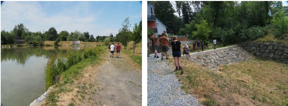
Abbildung 7: Linkes Bild: Blick auf den Absperrdamm mit Hochwasserentlastungsanlage (Gesamtlänge: 200 lfm, Dammhöhe: 3,5 m). Im Vordergrund ein neu angelegter naturnaher Teich, der im Winter als Eisstockbahn genutzt wird. Rechtes Bild: Festes Überlaufwehr mit freiem Überfall in das im Nebenschluss liegende Hochwasserrückhaltebecken mit einem Rückhaltevolumen von 33.100 m<sup>3</sup>. (Fotos: Ribitsch)
